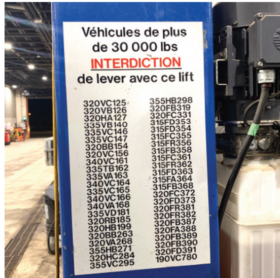
Photo 15 : Pont élévateur avec interdiction de levage sur les véhicules identifiés (atelier de Hull)
