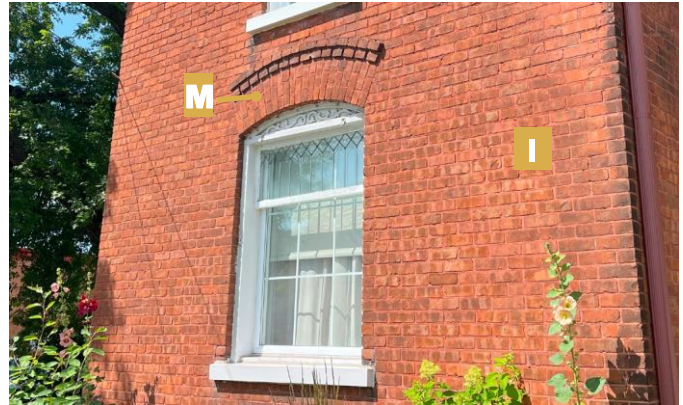
Fenêtre à carreaux avec résille de plomb et couronnée par un linteau arqué en brique 501, rue Charles Enclume
