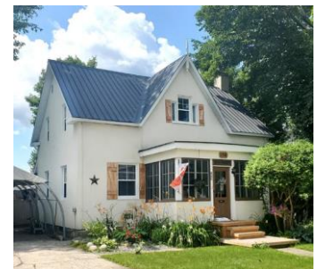
Maison avec un pignon central plus étroit 150, rue MacLaren Ouest Enclume
