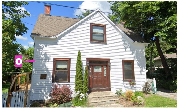
Maison à pignon central avec recouvrement en bois 79, rue Front Street View
