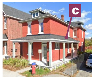
Maison cubique sur le modèle hullois 216, rue Laval Street View
