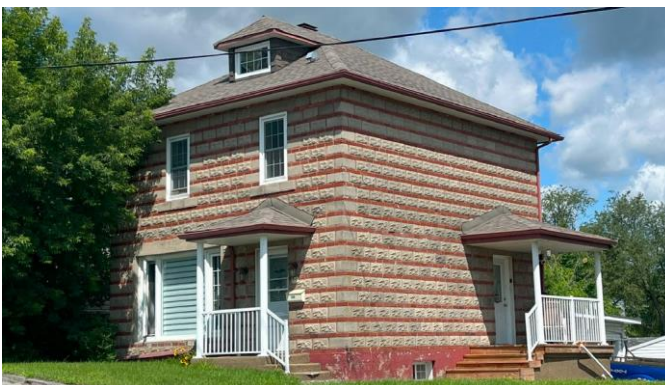
Maison cubique en bloc de béton et en brique 109, rue Jean-XXIII Enclume
