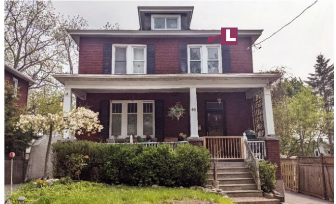
Maison cubique avec briques en soldat au-dessus des ouvertures 46, rue du Couvent Passerelles
