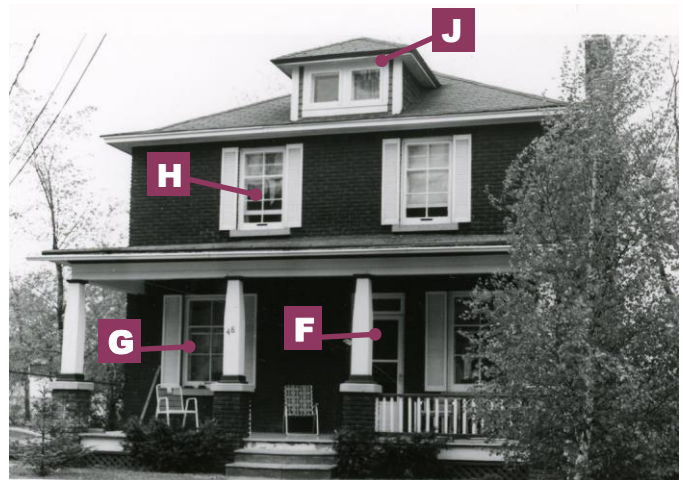
Maison cubique avec fenêtres à guillotine à 6 carreaux et fenêtres verticalement non alignées 48, rue du Couvent Association du patrimoine d'Aylmer
