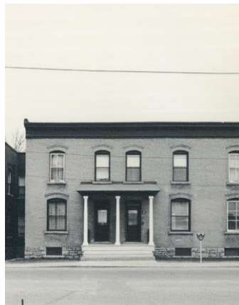
Maisons en brique à toit plat en rangée 62-66, rue Montcalm Ville de Gatineau
