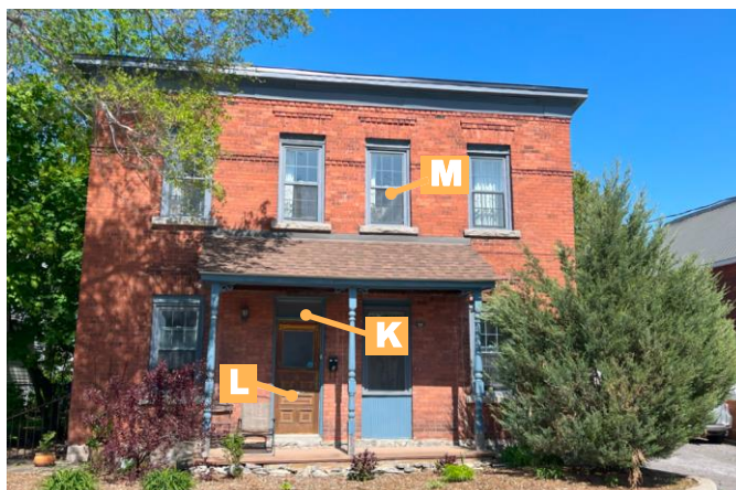
Maison avec porte en bois fenestrée avec imposte et fenêtres à guillotine avec 12 carreaux 10, rue de Carillon
