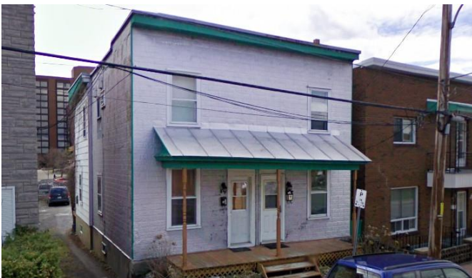
Maison recouverte de tôle embossée 48, rue Wright Street View
