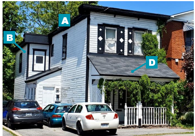
Maison en bois à toit plat avec galerie en appentis 35, rue Principale Enclume
