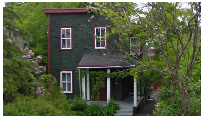
Maison recouverte de papier brique, avec débord de toit simple 22, rue Lois Street View
