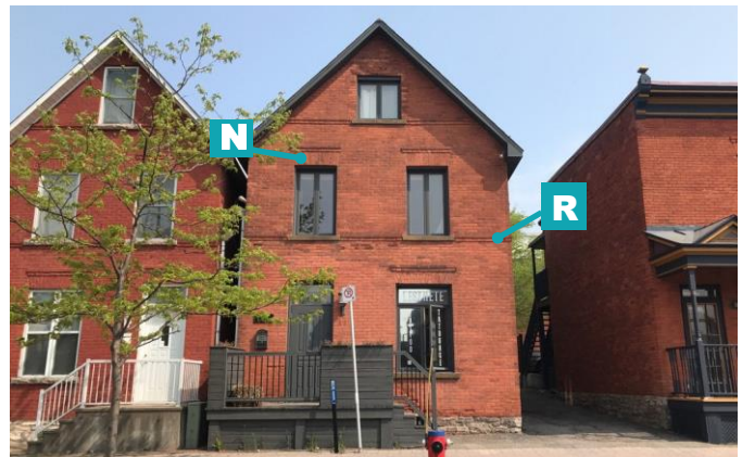
Maison avec jeux de briques et briques en soldat 133, rue Wellington Passerelles
