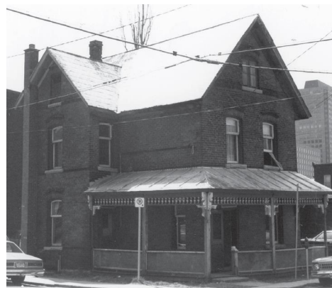
Maison allumette en brique avec un corps secondaire perpendiculaire et une galerie en L Ville de Gatineau
