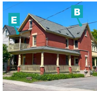
Maison avec corps secondaire perpendiculaire 36, rue Lois Enclume
