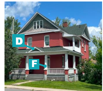
Maison avec galerie en L 133, rue MacLaren Ouest Enclume
