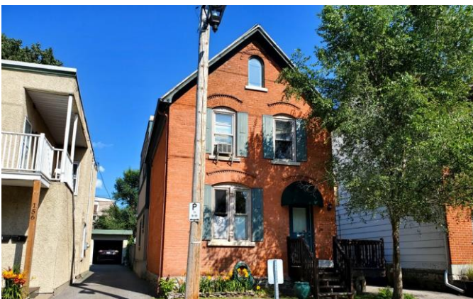
Maison avec une fenêtre cintrée dans le pignon 154, rue Champlain Enclume
