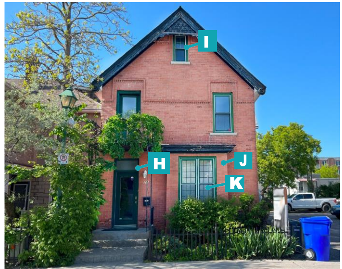
Maison avec fenêtres à guillotine et fenêtre rectangulaire dans le pignon 69, rue Vaudreuil Enclume
