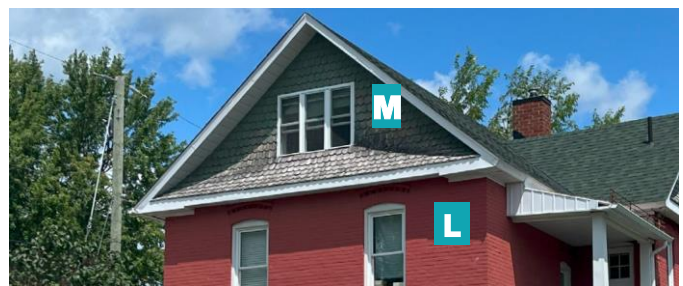
Maison avec revêtement mural en bardeaux de bois dans le pignon 133, rue MacLaren Ouest Enclume
