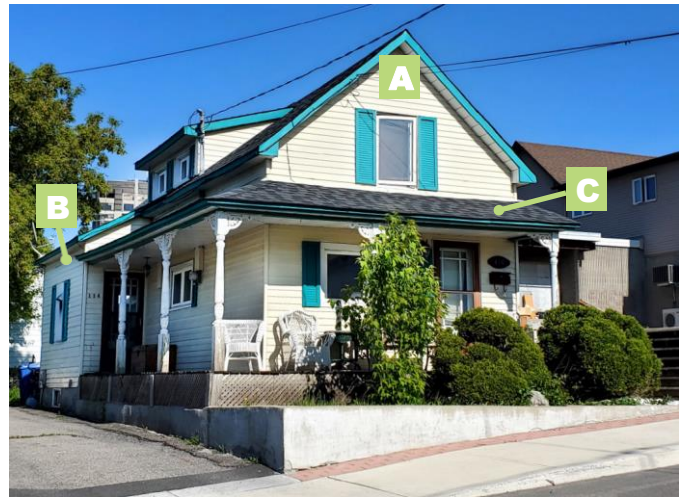
Maison à une fenêtre à l'étage avec un corps secondaire d'un étage en appentis qui accueille une entrée secondaire décalée 114, rue Saint-Jacques
