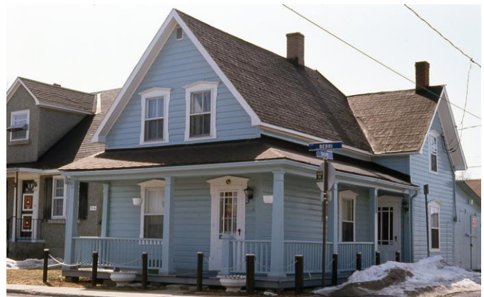
Maison à deux fenêtres à l'étage avec un corps secondaire perpendiculaire qui accueille une entrée secondaire décalée 73, rue Berri
