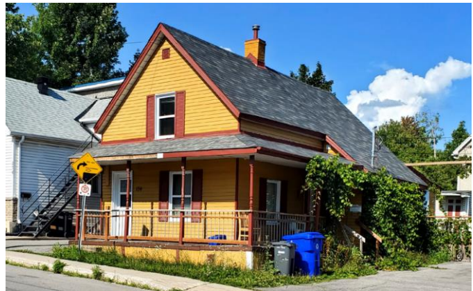
Maison à une fenêtre à l'étage avec corps secondaire en appentis 174, rue Leduc Enclume
