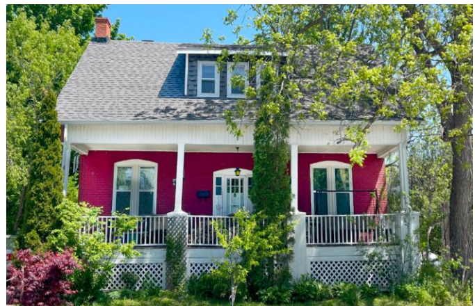
Bungalow avec une fenêtre en triplet dans la lucarne et des fenêtres doubles au rez-de-chaussée 430, rue Parker Enclume
