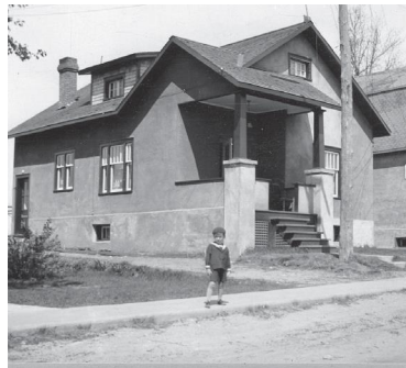
Bungalow nord-américain dans les années 1930 29, rue Chateaubriand Roch Defayette. Ville de Gatineau
