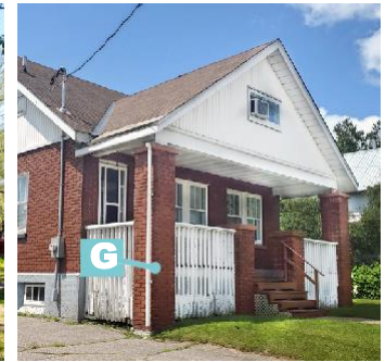
Bungalow avec balustrade et colonnes de maçonnerie 130, rue MacLaren Ouest Enclume
