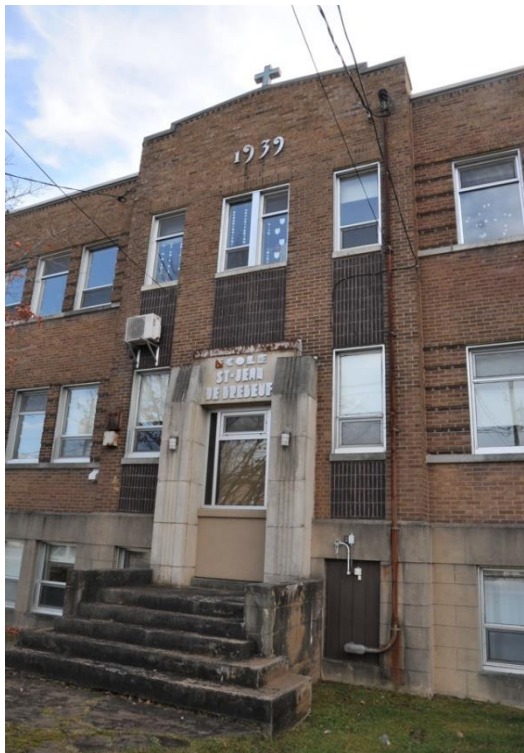
Image 3 : Détail façade, novembre 2022. Source : Ville de Gatineau
