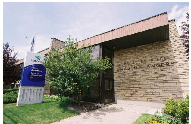
Image 5 : Façade avant, vers 2005. Source : Ville de Gatineau
