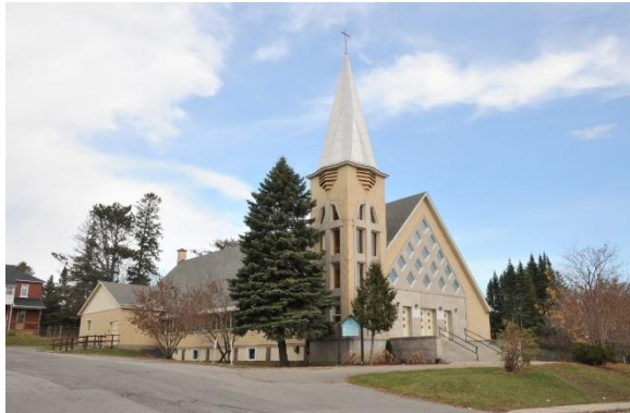
Image 1 : Façade avant / latérale gauche, novembre 2022. Source : Ville de Gatineau
