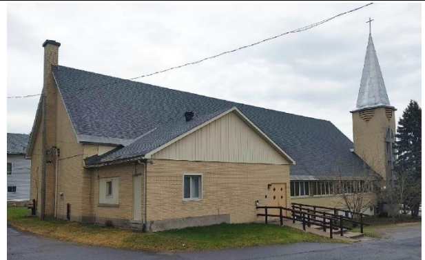
Image 7 : Façade latérale gauche / arrière, avril 2022. Source : EVOQ Stratégies
