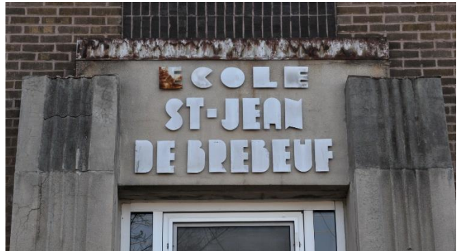
Image 4 : Détail façade, novembre 2022. Source : Ville de Gatineau
