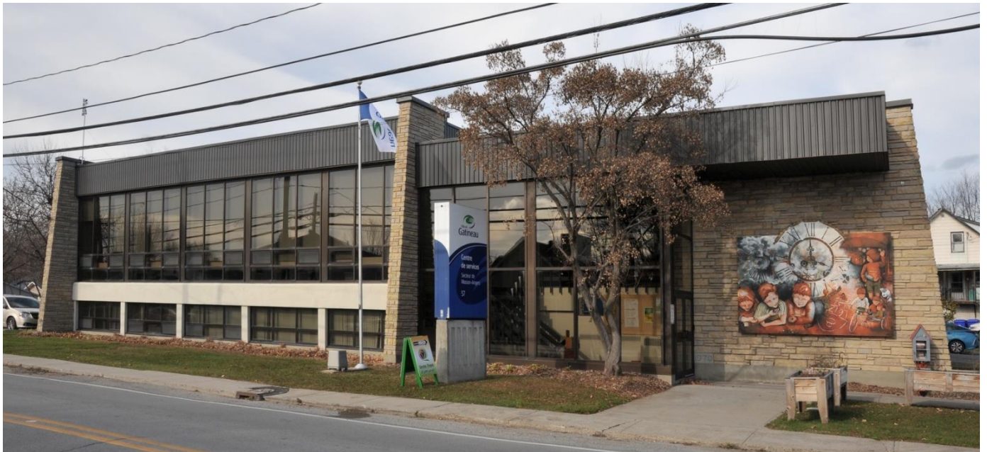
Image 1 : Façade avant, novembre 2022. Source : Ville de Gatineau
