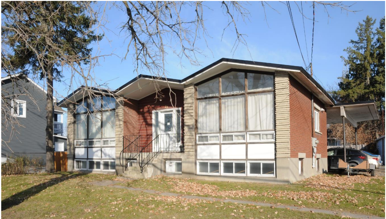
Photo 1 : Façade avant / latérale droite, novembre 2022. Source : Ville de Gatineau
