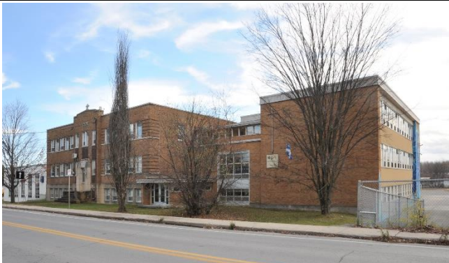
Image 6 : Façade avant, novembre 2022. Source : Ville de Gatineau
