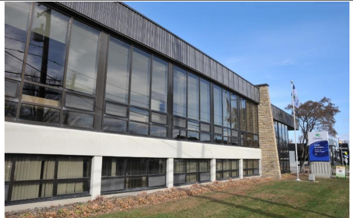
Image 3 : Façade avant novembre 2022. Source : Ville de Gatineau
