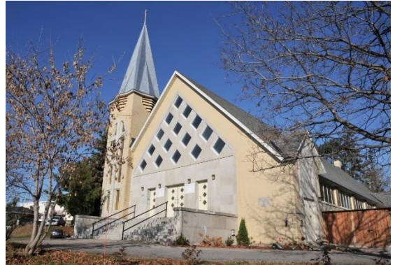
Image 2 : Façade avant, novembre 2022. Source : Ville de Gatineau
