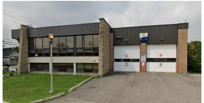
Image 5 : Façade latérale droite, juillet 2023. Source : Google Street View
