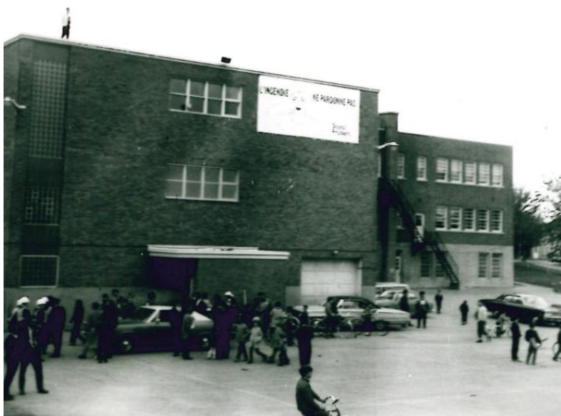
Image 3 : Façade arrière, 1968. Source : Ville de Gatineau
