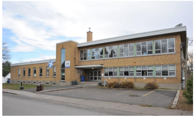
Image 2 : Façade avant, novembre 2022. Source : Ville de Gatineau
