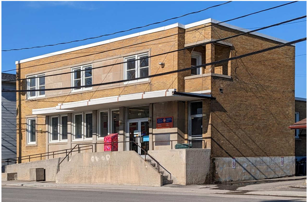
Image 2: Façade avant / latérale droite, mars 2023. Source : Ville de Gatineau
