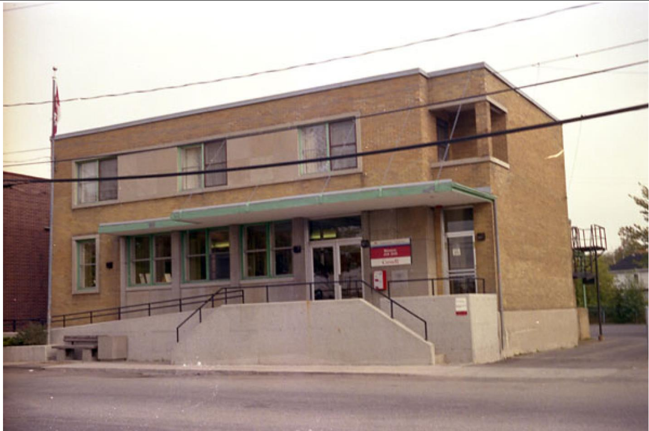
Image 2: Façade avant / latérale droite, 1984. Source : Bibliothèque et Archives Canada
