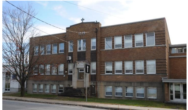
Image 2 : Façade avant, novembre 2022. Source : Ville de Gatineau
