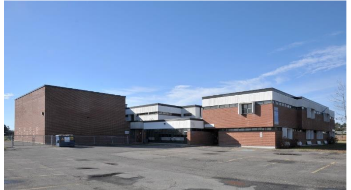
Image 2 : Façade avant / latérale gauche, novembre 2022. Source : Ville de Gatineau
