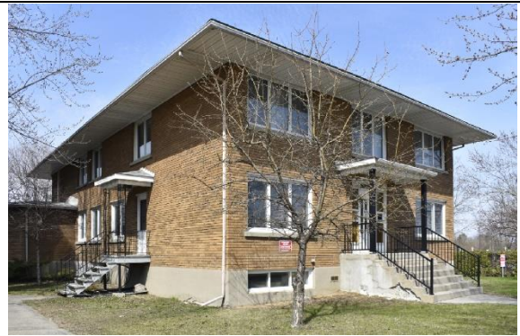
Image 3 : Façade avant / latérale gauche, avril 2023. Source : Ville de Gatineau
