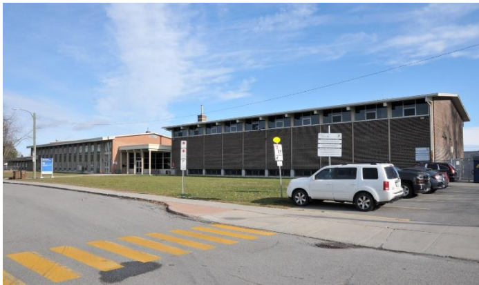
Image 2 : Façade avant / latérale gauche, novembre 2022. Source : Ville de Gatineau
