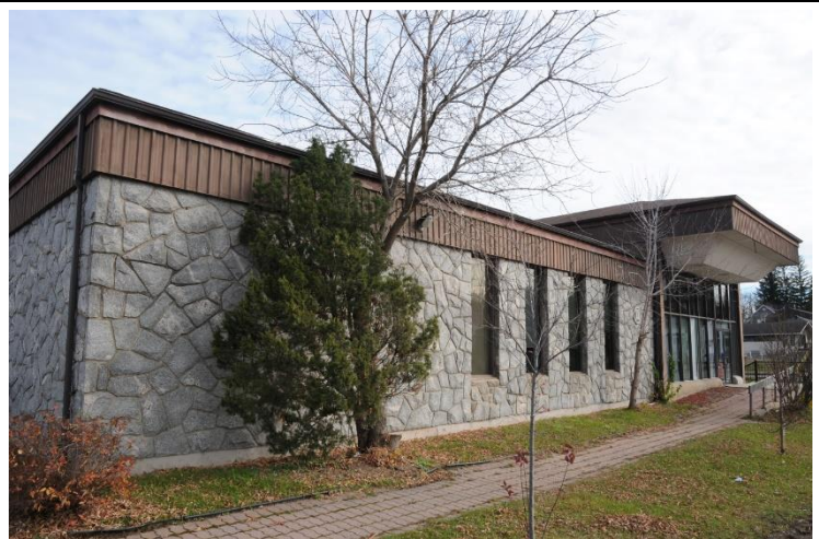
Image 6 : Façade avant, novembre 2022. Source : Ville de Gatineau
