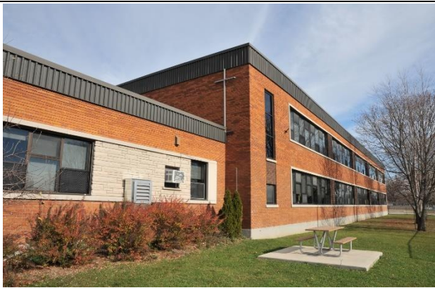
Image 5 : Façade latérale droite, novembre 2022. Source : Ville de Gatineau
