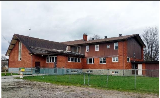
Image 6 : Façade arrière / latérale droite, avril 2022. Source : EVOQ Stratégies
