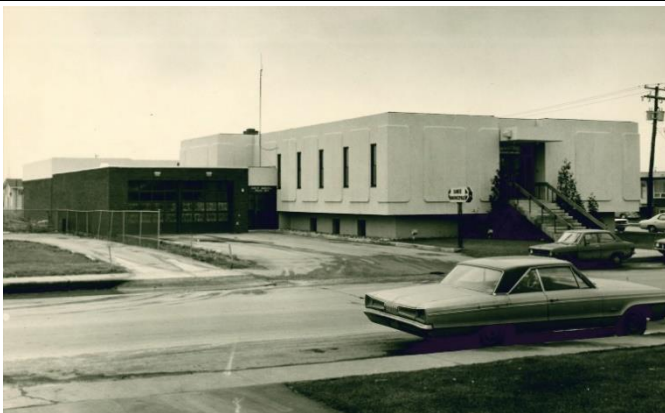
Image 3 : Façade avant / latérale gauche, années 1970. Source : Ville de Gatineau
