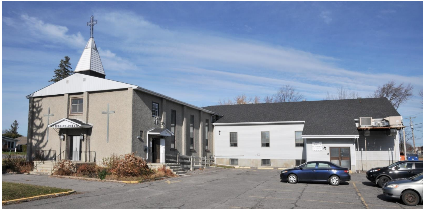
Image 1 : Façade avant / latérale droite, novembre 2022. Source : Ville de Gatineau
