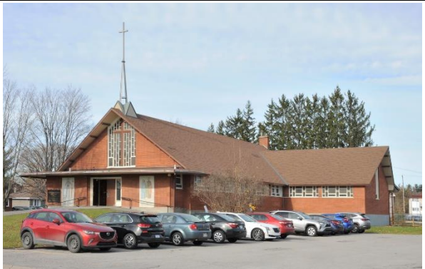
Image 8 : Façade avant / latérale droite, novembre 2022. Source : Ville de Gatineau
