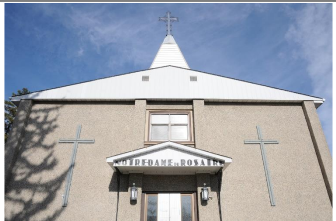
Image 3 : Détail façade, novembre 2022. Source : Ville de Gatineau
