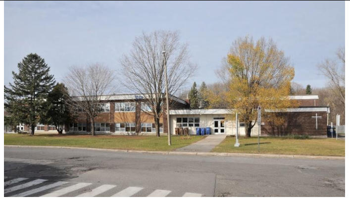
Image 2 : Façade avant, novembre 2022. Source : Ville de Gatineau
