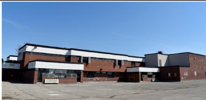
Image 6 : Façade arrière, avril 2023. Source : Ville de Gatineau
