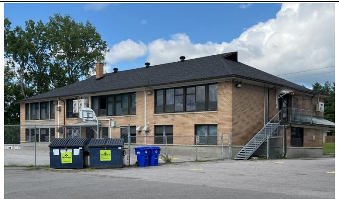
Image 5 : Façade arrière / latérale gauche, août 2022. Source : EVOQ Stratégies
