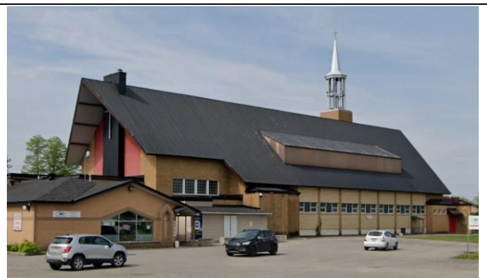
Image 6 : Façade latérale gauche / arrière, mai 2022. Source : Google Street View
