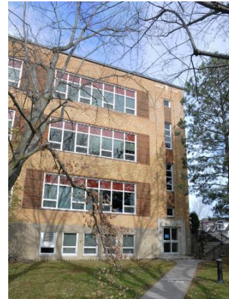
Image 4 : Détail façade, novembre 2022. Source : Ville de Gatineau
