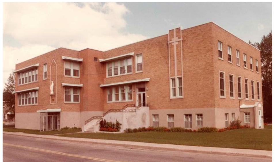
Image 4 : Façade avant / latérale droite, années 1980. Source : Sœurs de Sainte-Marie-de-Namur
