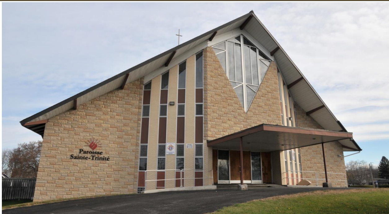
Image 1 : Façade avant, novembre 2022. Source : Ville de Gatineau
