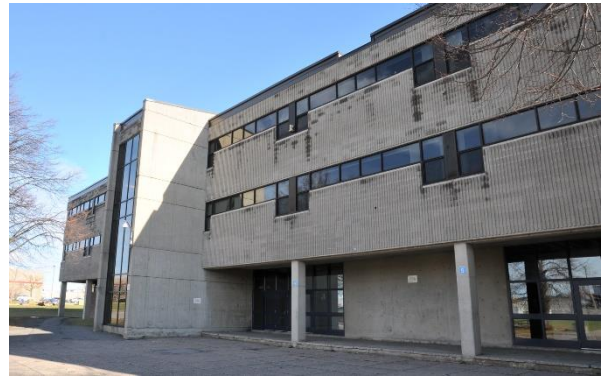
Image 4 : Détail façade, novembre 2022. Source : Ville de Gatineau
