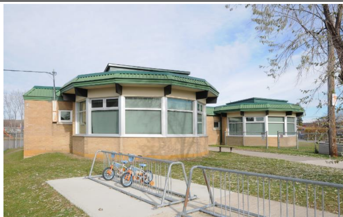
Image 3 : Détail façade, novembre 2022. Source : Ville de Gatineau
