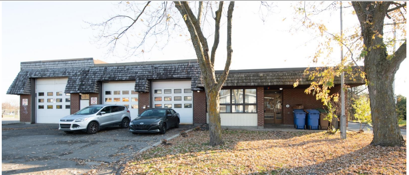
Image 1 : Façade avant, novembre 2022. Source : Ville de Gatineau
