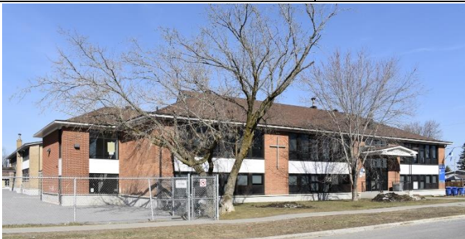
Image 5 : Façade avant / latérale gauche, avril 2023. Source : Ville de Gatineau
