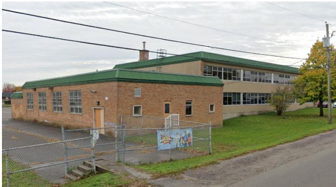
Image 4 : Façade arrière / latérale gauche, octobre 2020. Source : Google Street View
