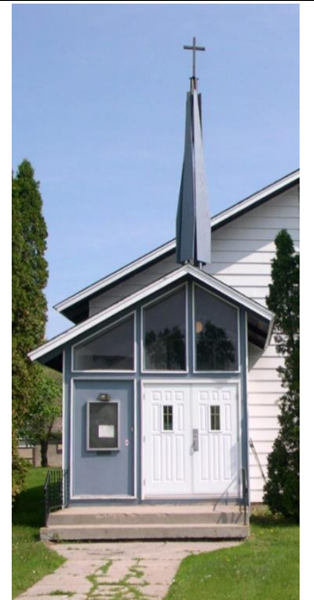
Image 4 : Détail entrée, 2003. Source : CPRQ
