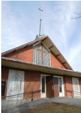
Image 3 : Détail façade, novembre 2022. Source : Ville de Gatineau
