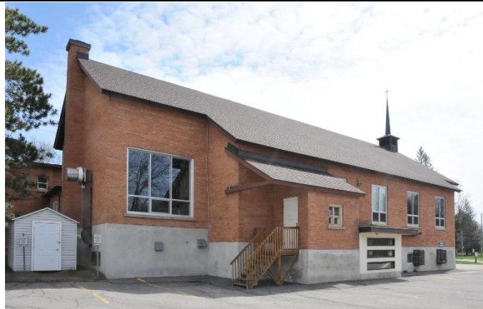
Image 3 : Façade latérale droite / arrière, mars 2023. Source : Ville de Gatineau
