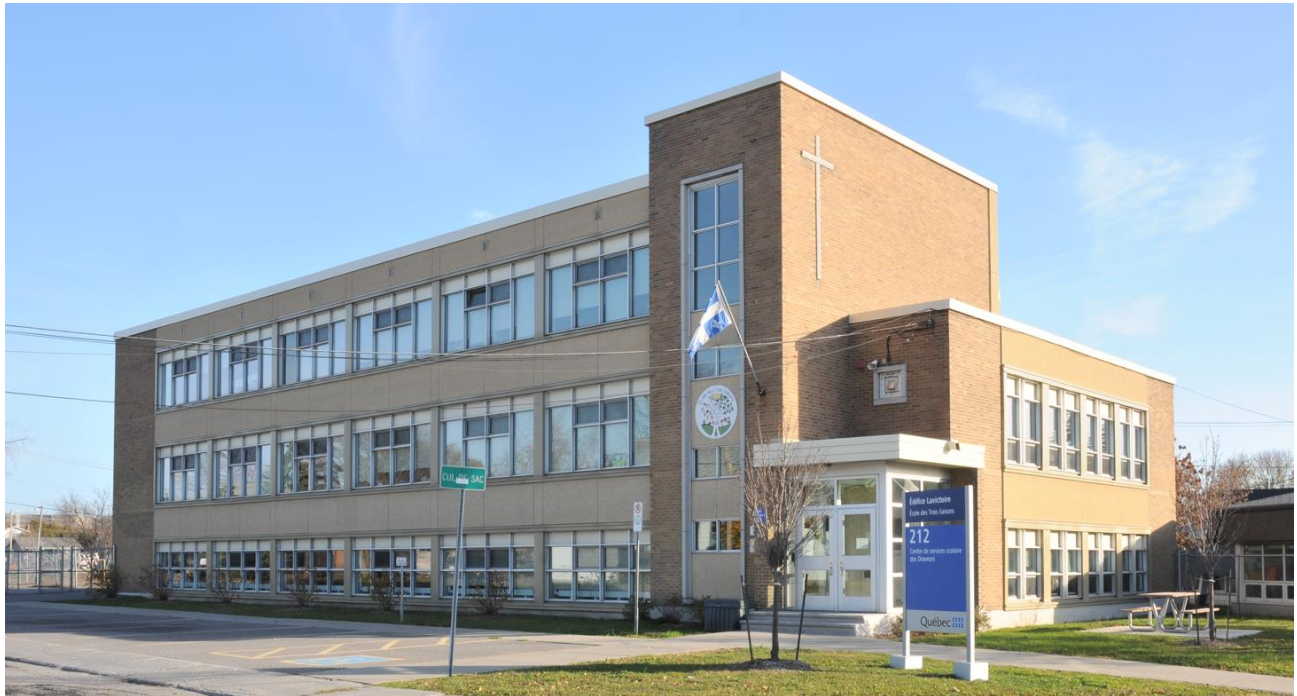
Image 1 : Façade avant / latérale droite, novembre 2022. Source : Ville de Gatineau
