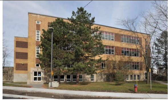
Image 2 : Façade avant, novembre 2022. Source : Ville de Gatineau
