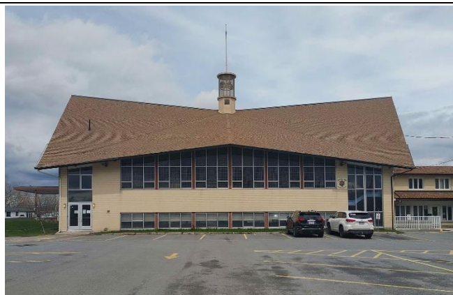
Image 3 : Façade latérale droite, avril 2022. Source : EVOQ Stratégies
