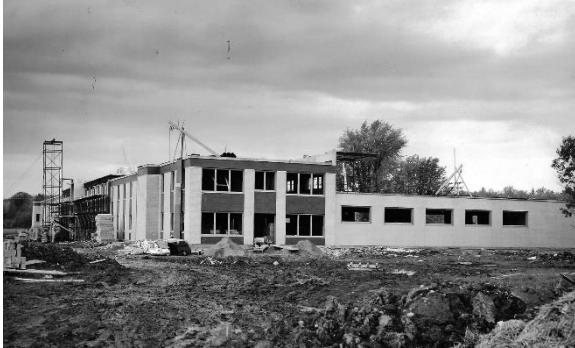
Image 1 : Façade latérale droite (en construction), 1961. Source : Fonds Les Pères Eudistes
