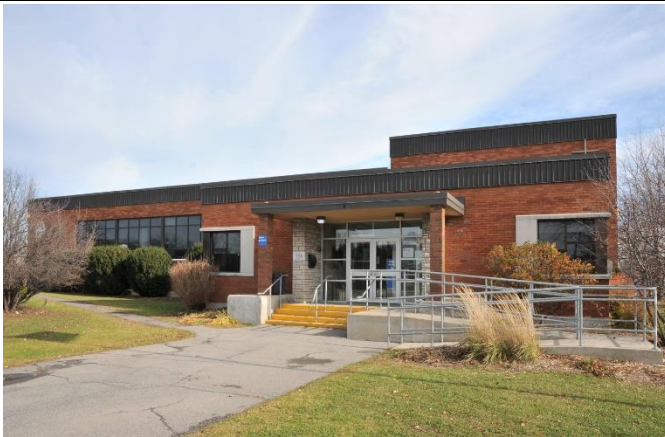
Image 3 : Façades avant, novembre 2022. Source : Ville de Gatineau
