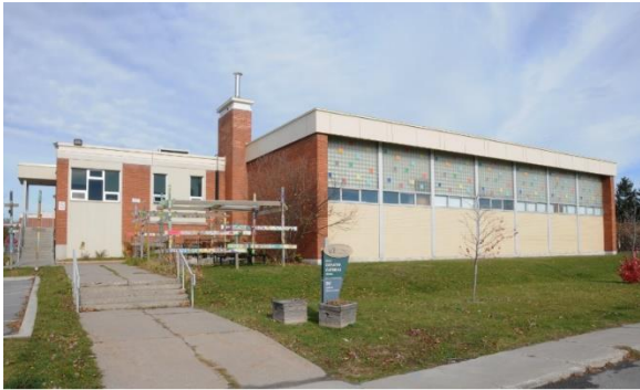
Image 2 : Façade avant, novembre 2022. Source : Ville de Gatineau
