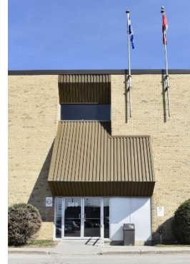
Image 2 : Détail façade, mai 2023. Source : Ville de Gatineau
