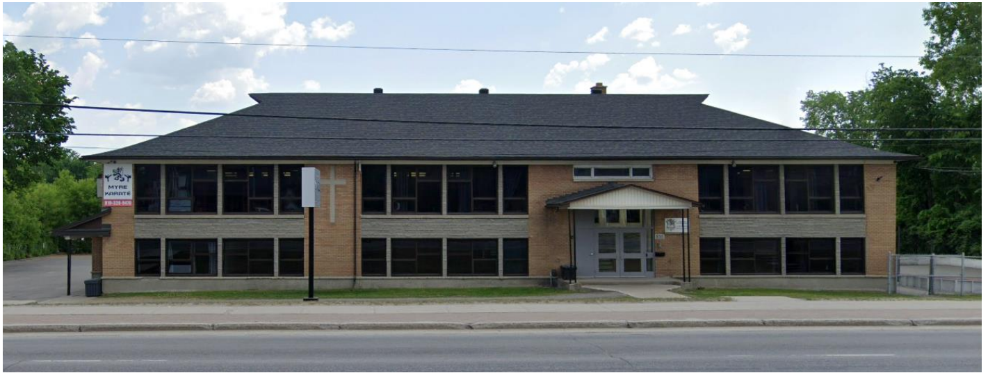
Image 1 : Façade avant, juin 2023. Source : Google Street View
