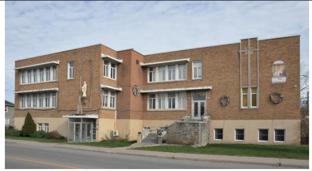
Image 2 : Façade avant, novembre 2022. Source : Ville de Gatineau
