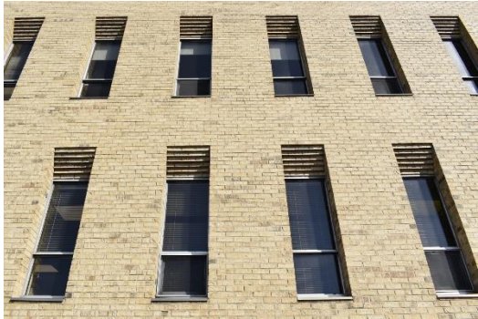
Image 3 : Détail façade, mai 2023. Source : Ville de Gatineau
