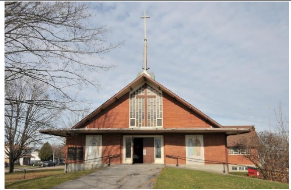
Image 2 : Façade, novembre 2022. Source : Ville de Gatineau
