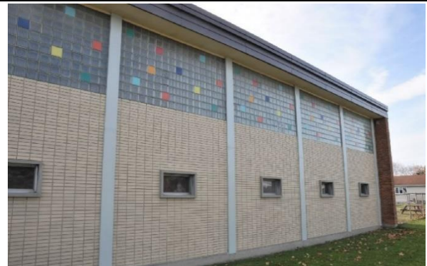
Image 5 : Détail façade, novembre 2022. Source : Ville de Gatineau
