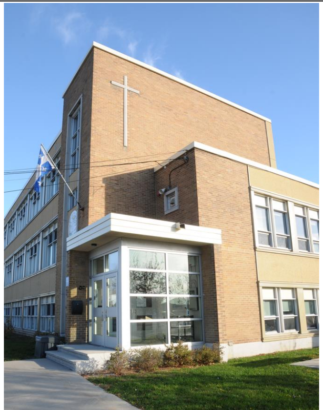
Image 4 : Détail façade, novembre 2022. Source : Ville de Gatineau
