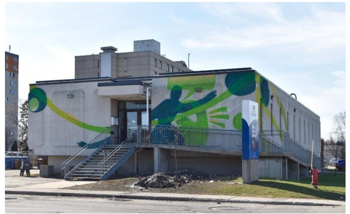
Image 2 : Façade avant / latérale droite, avril 2023. Source : Ville de Gatineau
