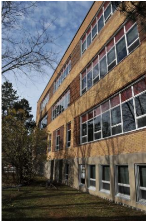
Image 3 : Détail façade, novembre 2022. Source : Ville de Gatineau
