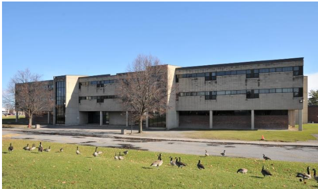
Image 3 : Façade latérale droite, novembre 2022. Source : Ville de Gatineau
