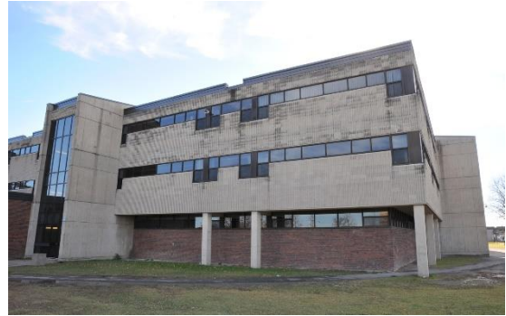
Image 2 : Façade avant, novembre 2022. Source : Ville de Gatineau
