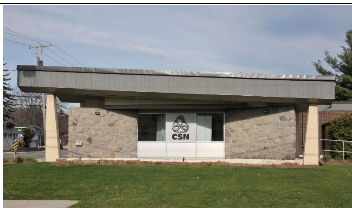
Image 4 : Façade latérale droite, novembre 2022. Source : Ville de Gatineau
