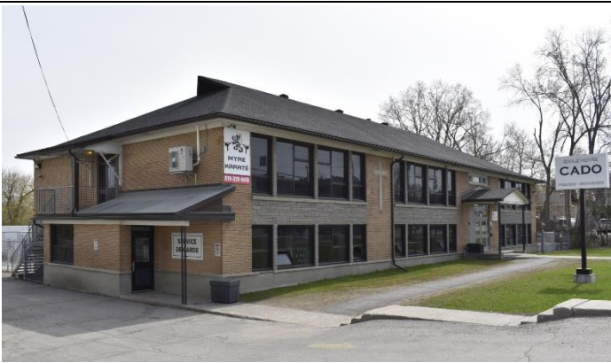
Image 2 : Façade avant / latérale gauche, mai 2023. Source : Ville de Gatineau
