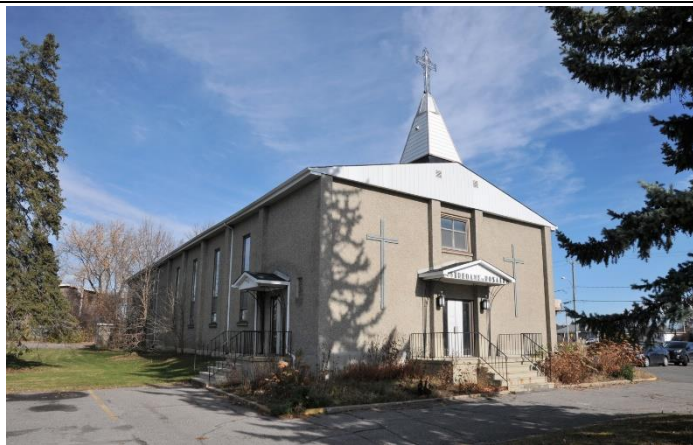
Image 2 : Façade avant / latérale gauche, novembre 2022. Source : Ville de Gatineau
