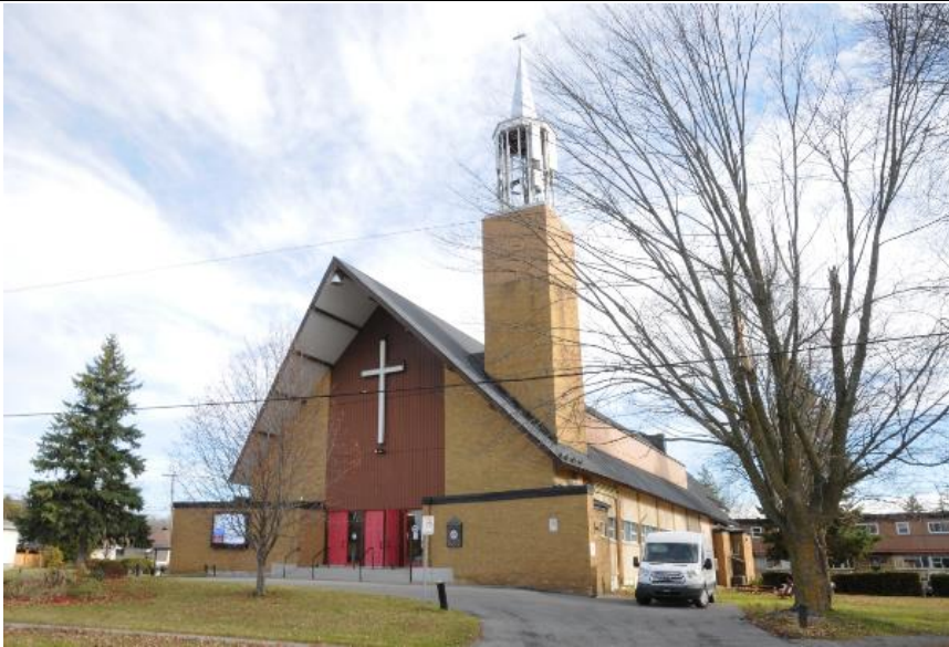
Image 1 : Façade avant / latérale droite, novembre 2022. Source : Ville de Gatineau
