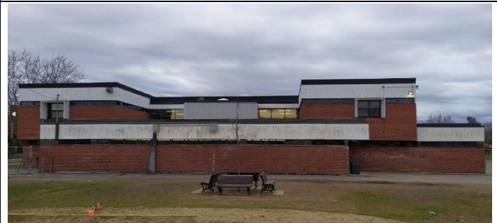
Image 5 : Façade latérale droite, avril 2022. Source : EVOQ Stratégies
