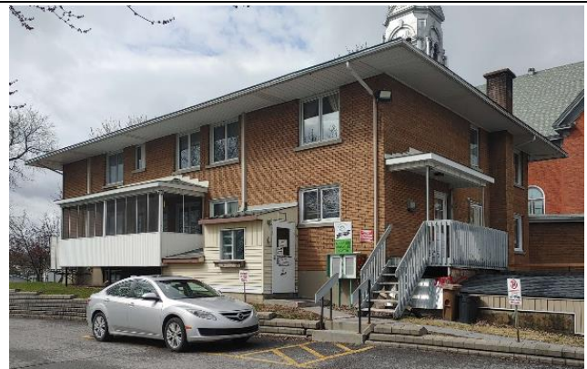
Image 5 : Façade latérale droite / arrière, avril 2022. Source : EVOQ Stratégies
