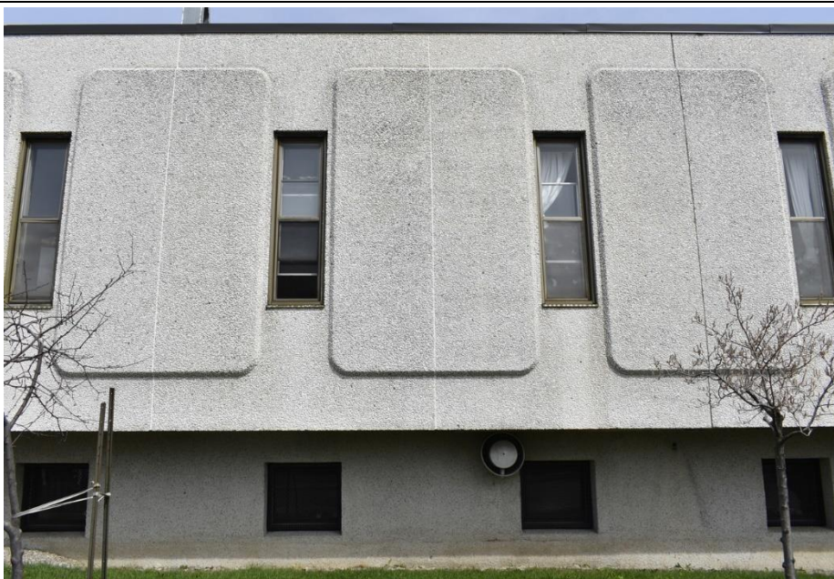
Image 4 : Détail façade, mai 2023. Source : Ville de Gatineau
