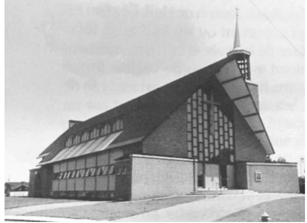
Image 2 : Façade avant / latérale gauche, vers 1985. Auteur : nc. Source : L'architecture des églises du Québec, 1940-1985
