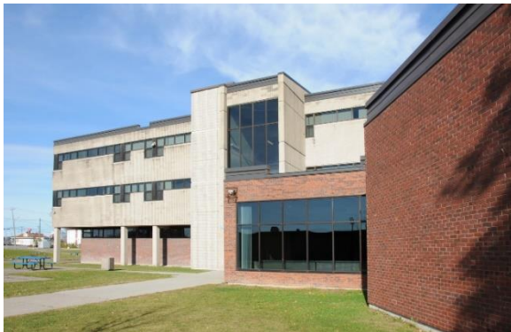
Image 7 : Détail façade, novembre 2022. Source : Ville de Gatineau
