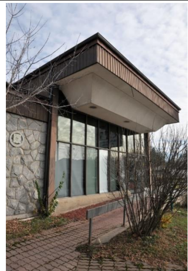
Image 4 : Détail façade, novembre 2022. Source : Ville de Gatineau
