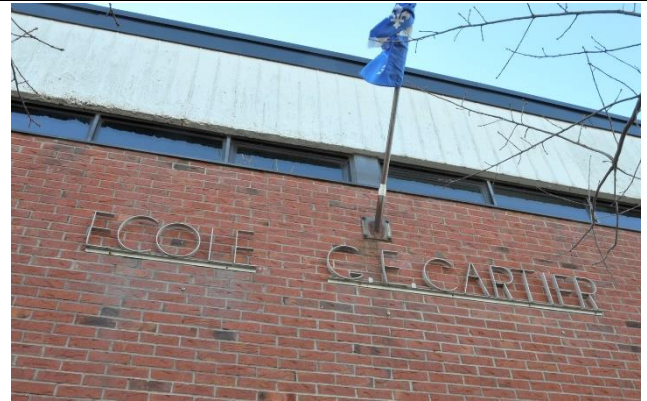
Image 4 : Détail façade, novembre 2022. Source : Ville de Gatineau
