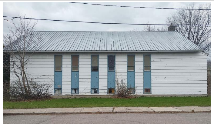
Image 5 : Façade latérale droite, avril 2022. Source : EVOQ Stratégies
