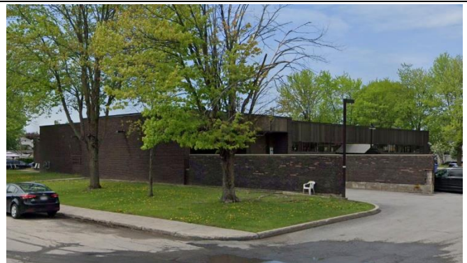
Image 5 : Façade arrière / latérale droite, mai 2022. Source : Google Street View
