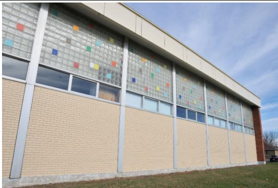
Image 4 : Détail façade, novembre 2022. Source : Ville de Gatineau
