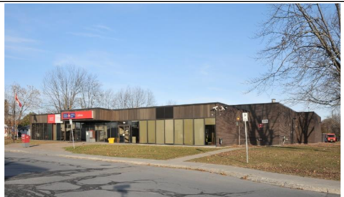
Image 3 : Façade avant / latérale droite, novembre 2022. Source : Ville de Gatineau
