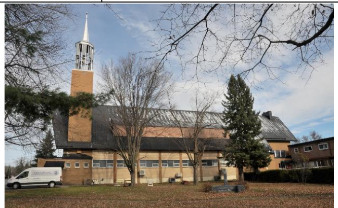
Image 4 : Façade latérale droite, novembre 2022. Source : Ville de Gatineau
