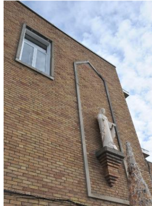
Image 3 : Détail façade, novembre 2022. Source : Ville de Gatineau
