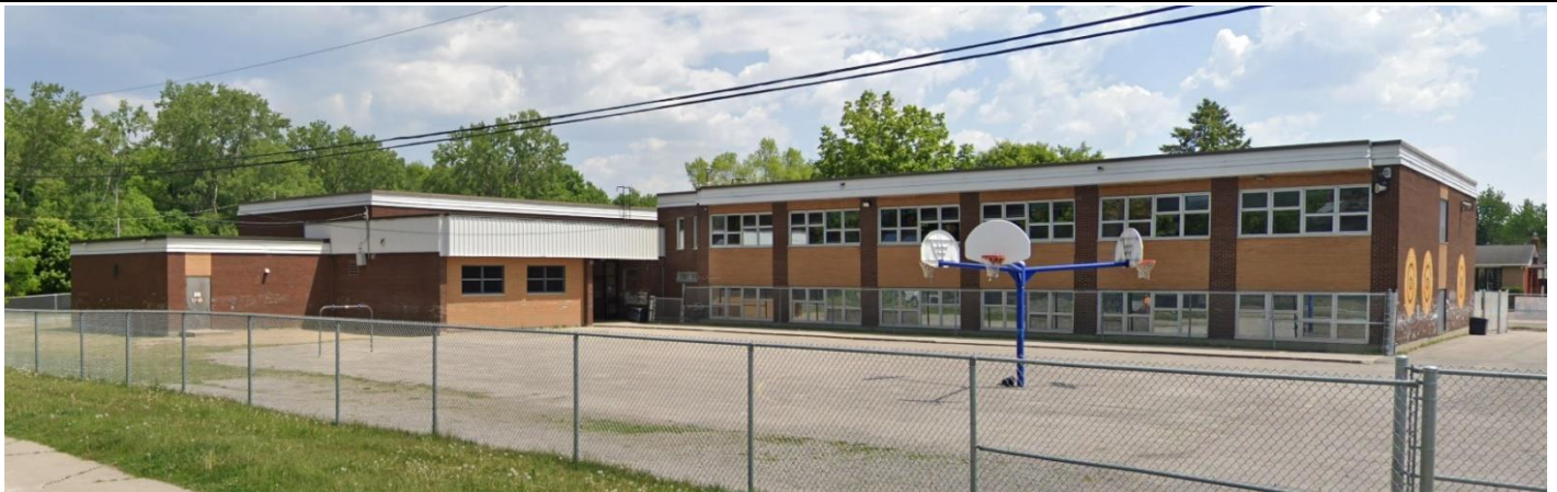
Image 5 : Façade arrière / latérale gauche, juin 2023. Source : Google Street View
