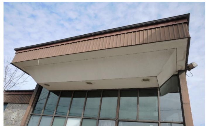
Image 2 : Détail façade, novembre 2022. Source : Ville de Gatineau
