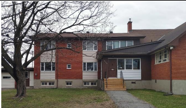
Image 5 : Façade latérale gauche (presbytère), avril 2022. Source : EVOQ Stratégies
