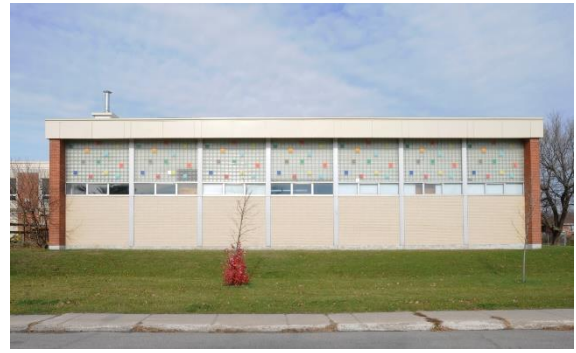
Image 3 : Façade avant, novembre 2022. Source : Ville de Gatineau
