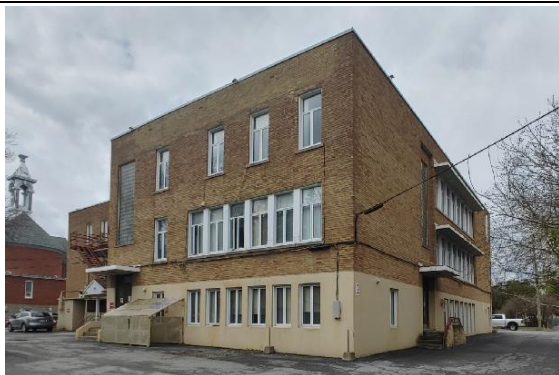
Image 7 : Façade arrière / latérale gauche, avril 2022. Source : EVOQ Stratégies
