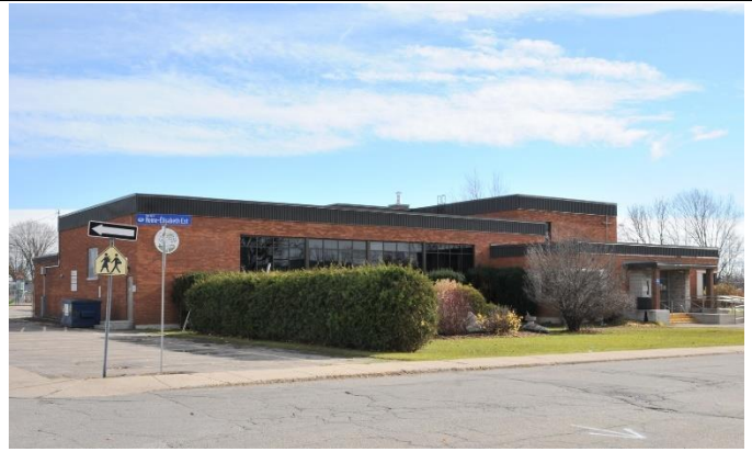
Image 2 : Façade avant, novembre 2022. Source : Ville de Gatineau
