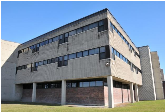
Image 5 : Détail façade, novembre 2022. Source : Ville de Gatineau
