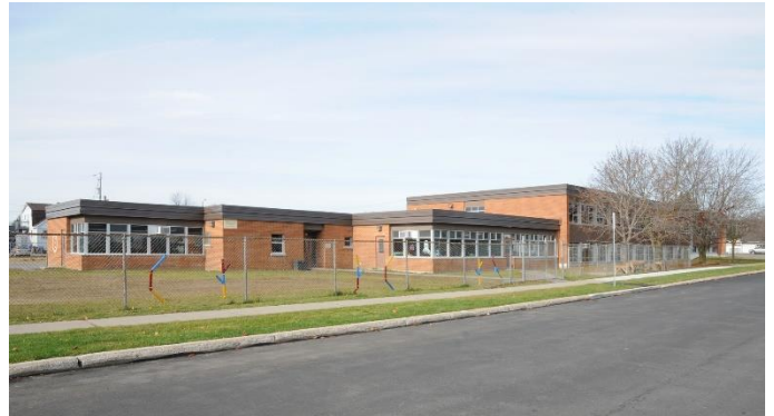
Image 3 : Façade avant / latérale gauche, novembre 2022. Source : Ville de Gatineau
