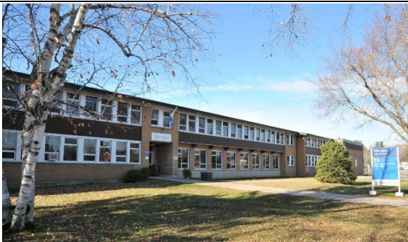
Image 3 : Détail façade, novembre 2022. Source : Ville de Gatineau
