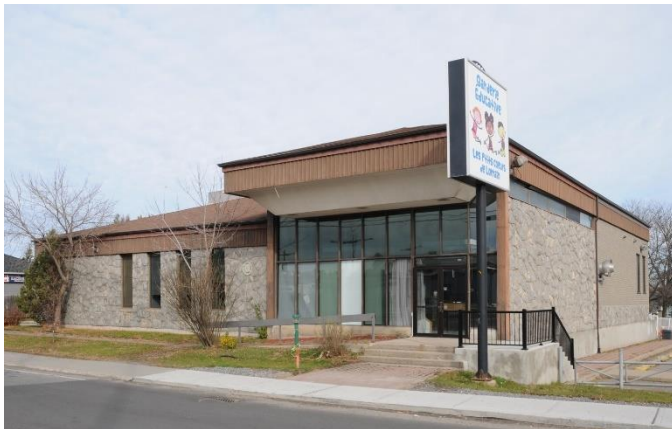
Image 1 : Façade avant / latérale droite, novembre 2022. Source : Ville de Gatineau
