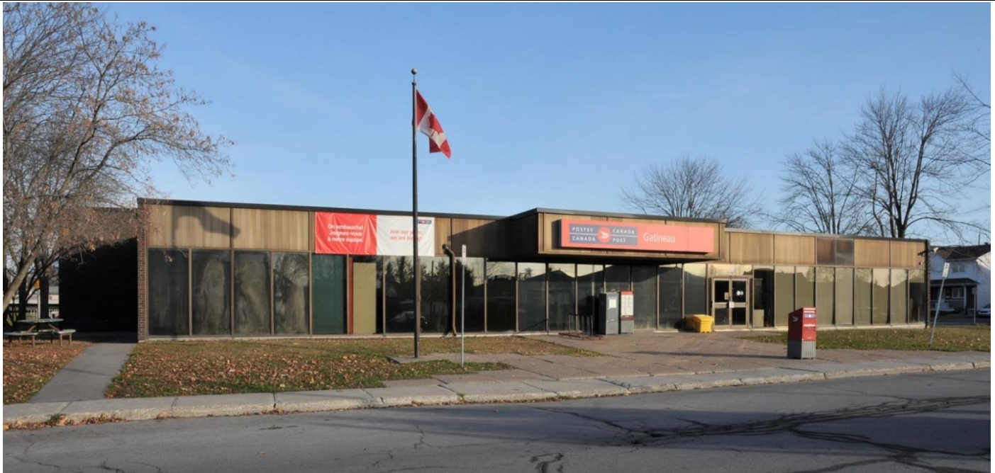
Image 1 : Façade avant, novembre 2022. Source : Ville de Gatineau
