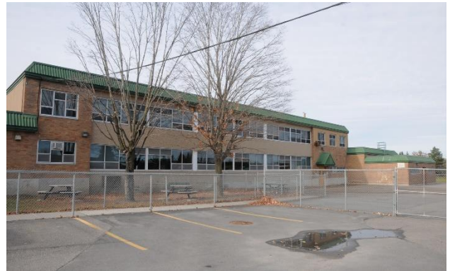
Image 5 : Façade latérale droite, novembre 2022. Source : Ville de Gatineau
