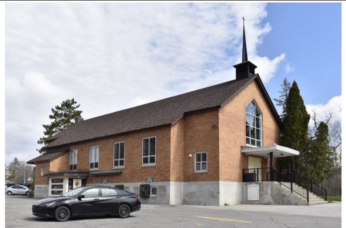
Image 2 : Façade avant / latérale droite, avril 2023. Source : Ville de Gatineau
