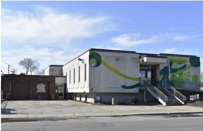
Image 1 : Façade avant / latérale gauche, avril 2023. Source : Ville de Gatineau
