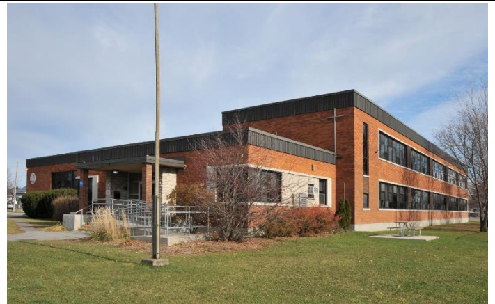
Image 4 : Façades avant / latérale droite, novembre 2022. Source : Ville de Gatineau
