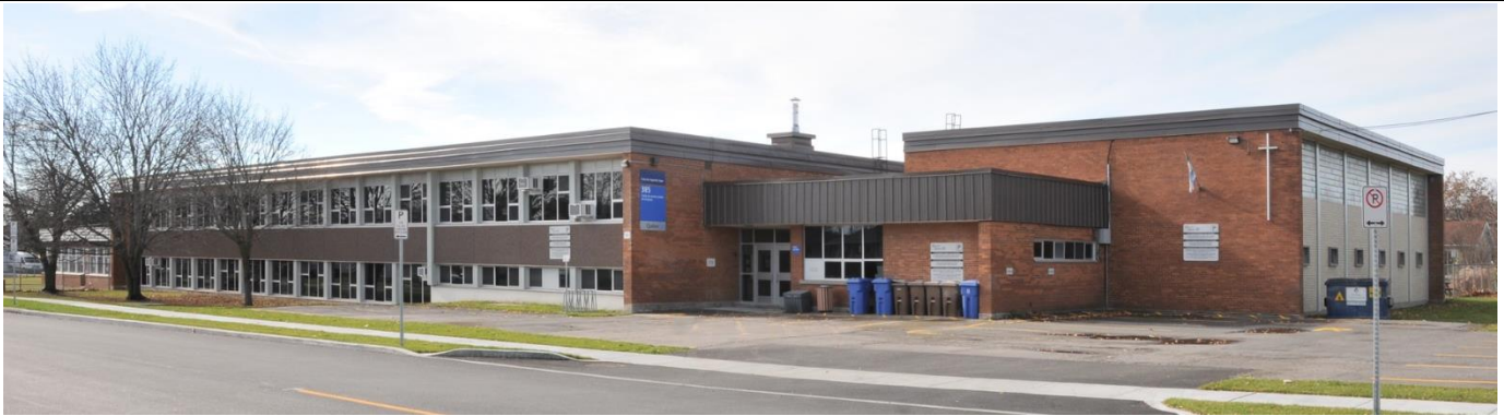
Image 1 : Façade avant / latérale droite, novembre 2022. Source : Ville de Gatineau
