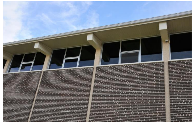
Image 3 : Détail façade, novembre 2022. Source : Ville de Gatineau
