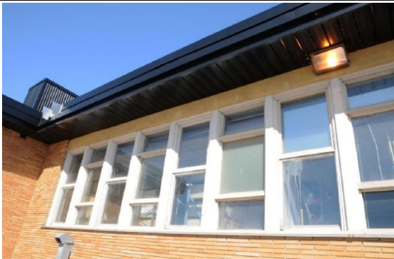
Image 7 : Façade arrière, avril 2023. Source : Ville de Gatineau
