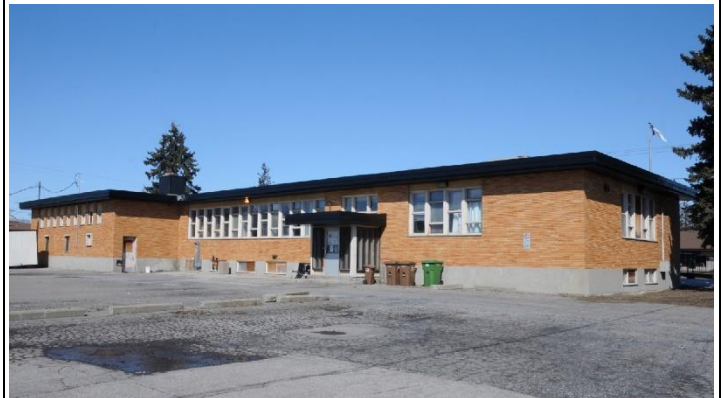
Image 6 : Façade arrière, avril 2023. Source : Ville de Gatineau
