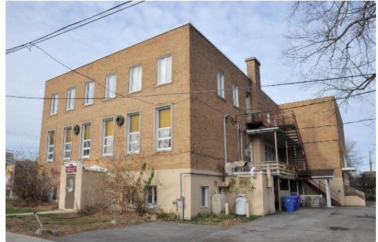
Image 6 : Façade latérale droite / arrière, novembre 2022. Source : Ville de Gatineau
