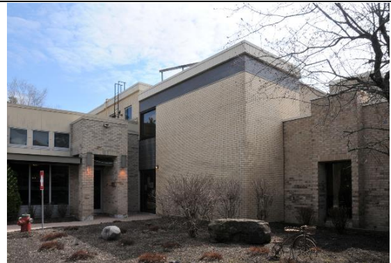
Image 6 : Façade latérale gauche, avril 2023. Source : Ville de Gatineau
