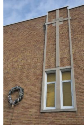
Image 4 : Détail façade, novembre 2022. Source : Ville de Gatineau
