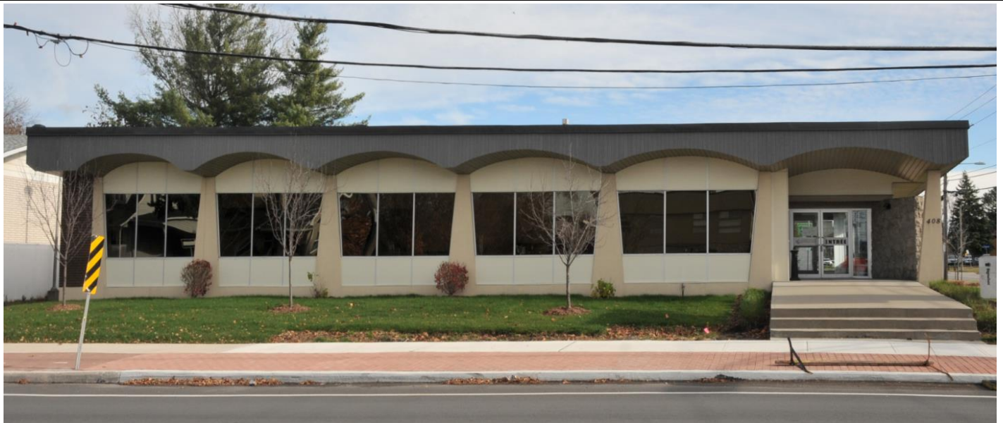
Image 1 : Façade avant, novembre 2022. Source : Ville de Gatineau
