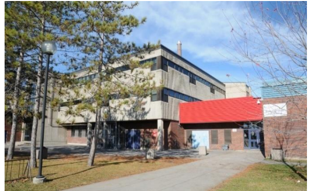
Image 8 : Détail façade, novembre 2022. Source : Ville de Gatineau
