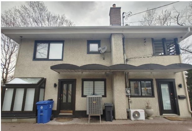
Photo 4 : Façade latérale gauche, mars 2022. Source : EVOQ Stratégies
