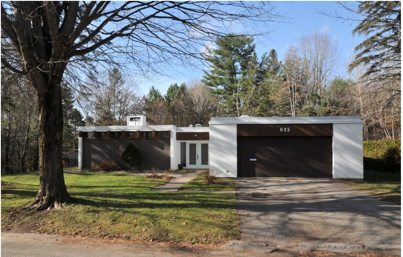
Image 1 : Façade avant, novembre 2022. Source : Ville de Gatineau
