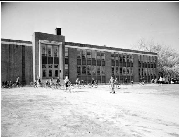
Image 2 : Façade avant, 1951. Auteur : Joseph Guibord
