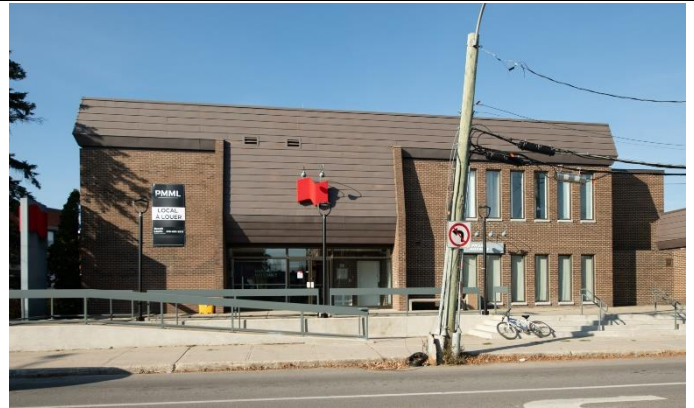
Image 3 : Façade avant, novembre 2022. Source : Ville de Gatineau
