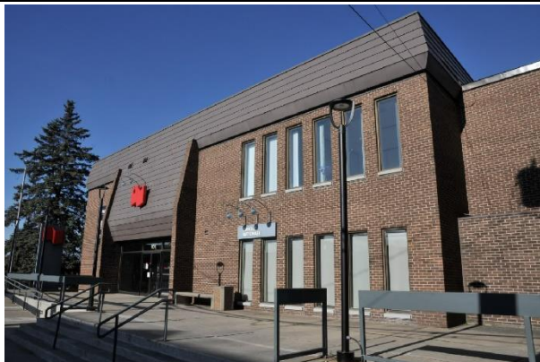
Image 4 : Façade avant, novembre 2022. Source : Ville de Gatineau
