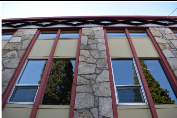
Image 5 : Détail façade, avril 2023. Source : Ville de Gatineau
