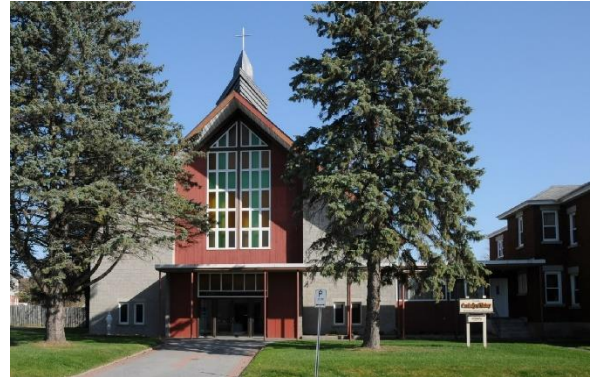
Image 2 : Façade avant, novembre 2022. Source : Ville de Gatineau
