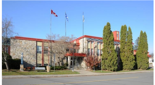
Image 2 : Façade avant, novembre 2022. Source : Ville de Gatineau
