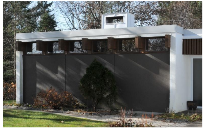
Image 3 : Détail façade, novembre 2022. Source : Ville de Gatineau
