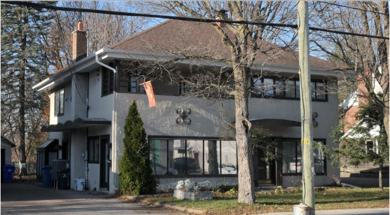
Photo 1 : Façade avant / latérale gauche, novembre 2022. Source : Ville de Gatineau
