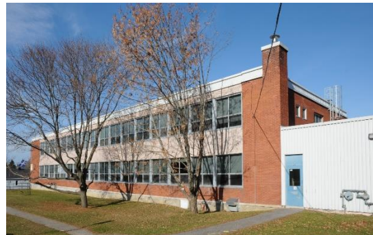
Image 8 : Façade avant, novembre 2022. Source : Ville de Gatineau
