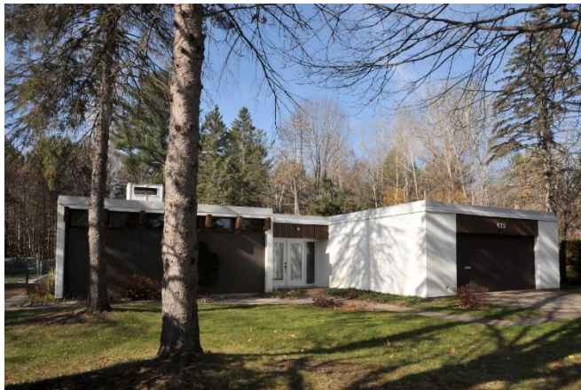
Image 2 : Façade avant, novembre 2022. Source : Ville de Gatineau
