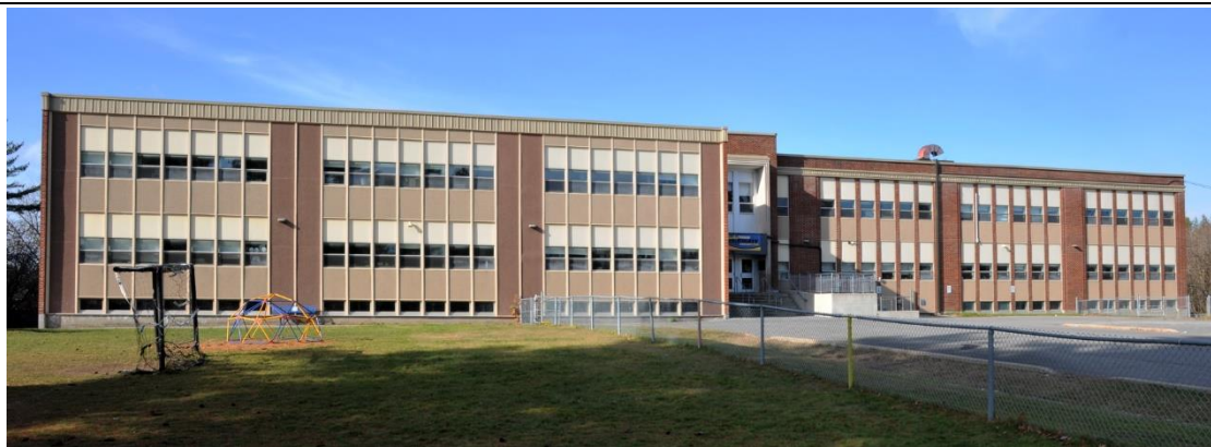
Image 2 : Façade avant, novembre 2022. Source : Ville de Gatineau
