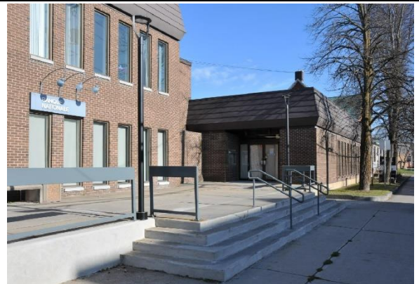
Image 5 : Façade avant, novembre 2022. Source : Ville de Gatineau
