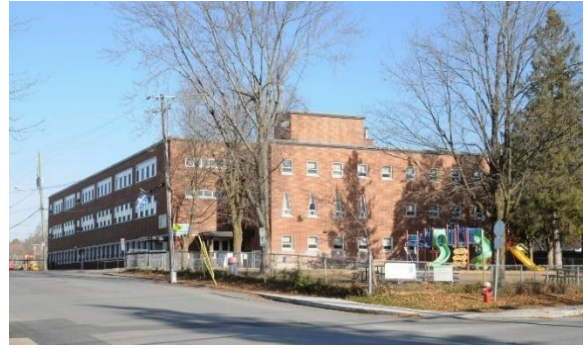
Image 2 : Façade avant, novembre 2022. Source : Ville de Gatineau
