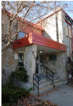
Image 3 : Détail entrée, novembre 2022. Source : Ville de Gatineau
