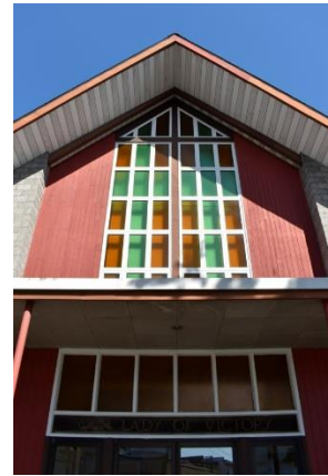
Image 4 : Détail façade, avril 2023. Source : Ville de Gatineau
