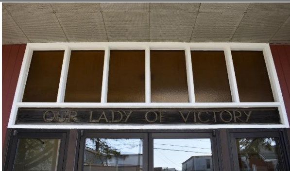
Image 5 : Détail façade, avril 2023. Source : Ville de Gatineau
