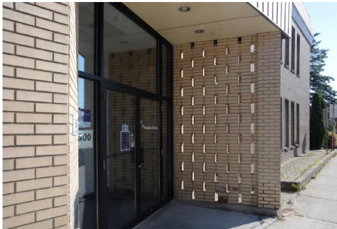
Image 3 : Détail entrée, novembre 2022. Source : Ville de Gatineau
