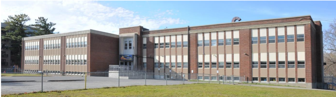
Image 1 : Façade avant, novembre 2022. Source : Ville de Gatineau
