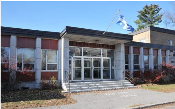
Image 4 : Détail entrée, novembre 2022. Source : Ville de Gatineau
