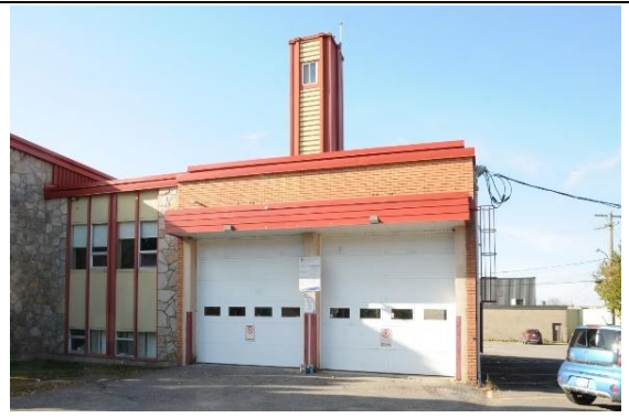
Image 6 : Façade avant, novembre 2022. Source : Ville de Gatineau
