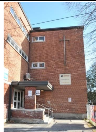
Image 6 : Détail entrée, novembre 2022. Source : Ville de Gatineau
