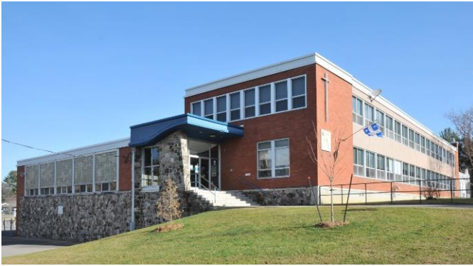
Image 1 : Façade avant / latérale gauche, novembre 2022. Source : Ville de Gatineau
