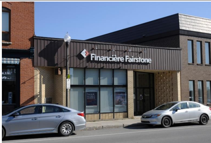
Image 1 : Façade avant, novembre 2022. Source : Ville de Gatineau
