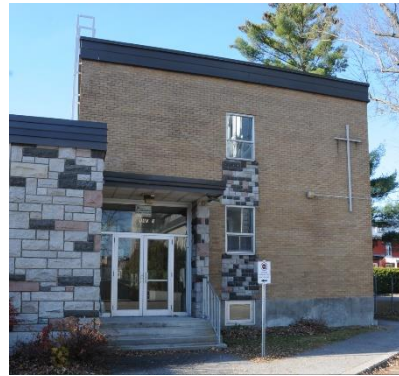
Image 3 : Façade avant, novembre 2022. Source : Ville de Gatineau
