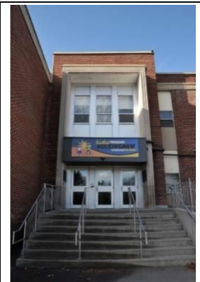
Image 3 : Détail entrée, novembre 2022. Source : Ville de Gatineau
