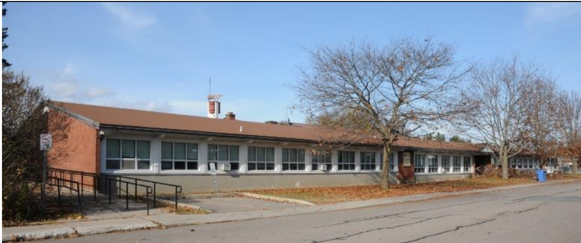
Image 2 : Façade avant, novembre 2022. Source : Ville de Gatineau
