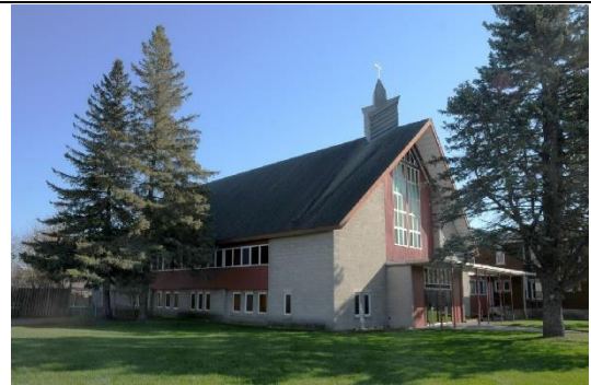
Image 6 : Façade avant / latérale gauche, novembre 2022. Source : Ville de Gatineau
