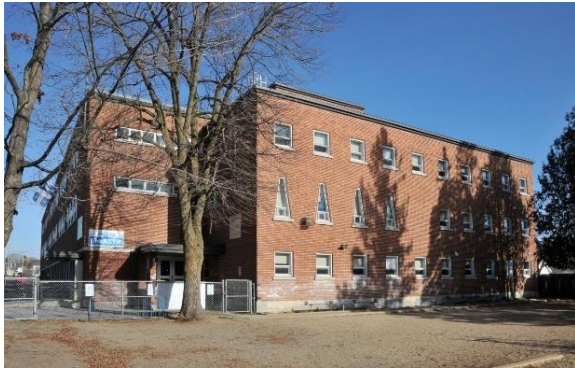
Image 3 : Façade avant, novembre 2022. Source : Ville de Gatineau
