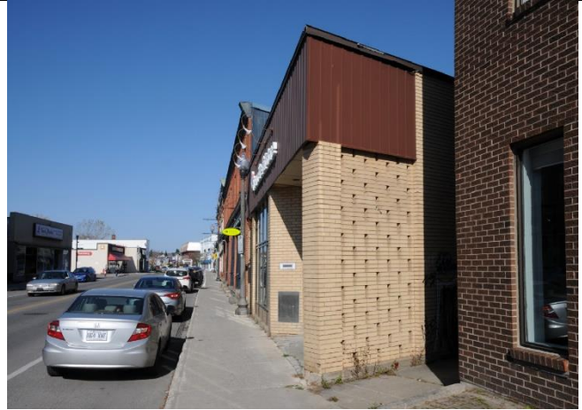
Image 2 : Façade latérale droite, novembre 2022. Source : Ville de Gatineau
