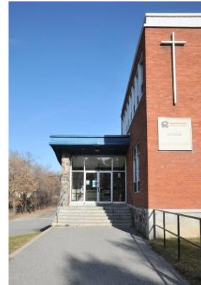
Image 2 : Détail entrée, novembre 2022. Source : Ville de Gatineau
