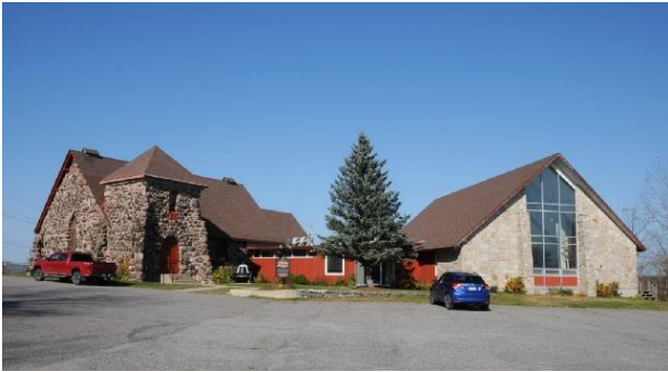
Image 2 : Façade avant, novembre 2022. Source : Ville de Gatineau
