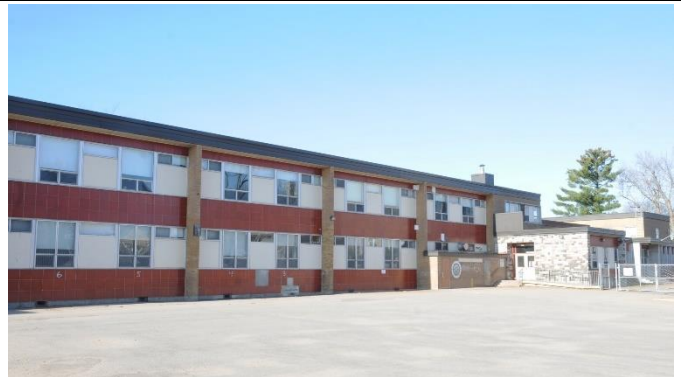
Image 5 : Façade avant, novembre 2022. Source : Ville de Gatineau
