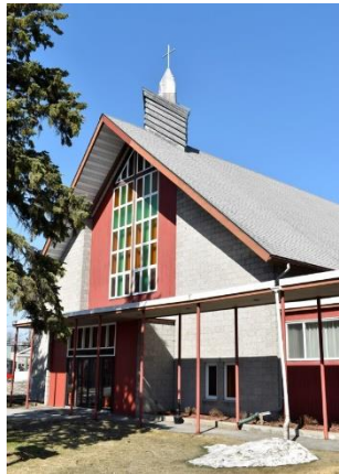
Image 3 : Façade avant, avril 2023. Source : Ville de Gatineau
