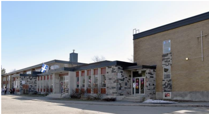
Image 2 : Façade avant, avril 2023. Source : Ville de Gatineau
