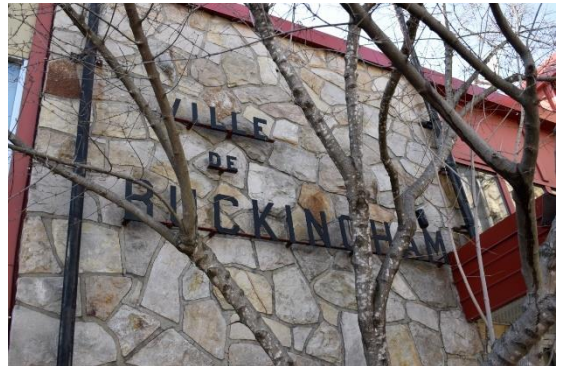
Image 4 : Détail façade, avril 2023. Source : Ville de Gatineau
