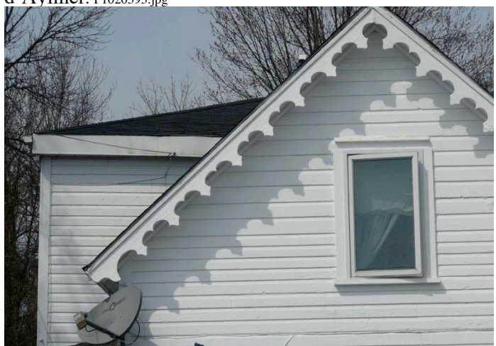
Éléments découpés en bordure du toit. Le mur est revêtu de planche à feuillure. 839, Jacques-Cartier, secteur de Gatineau. P1000734.jpg
