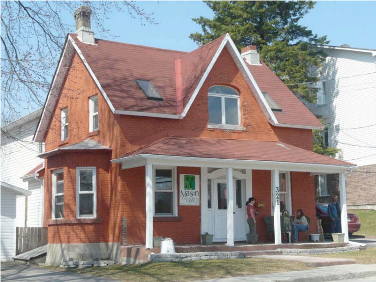
321, avenue de Buckingham, secteur de Buckingham. Un exemple d'édifice d'inspiration néogothique, reconnaissable par le gable en façade avant et la volumétrie à un niveau et demi d'occupation. P1010071.jpg
