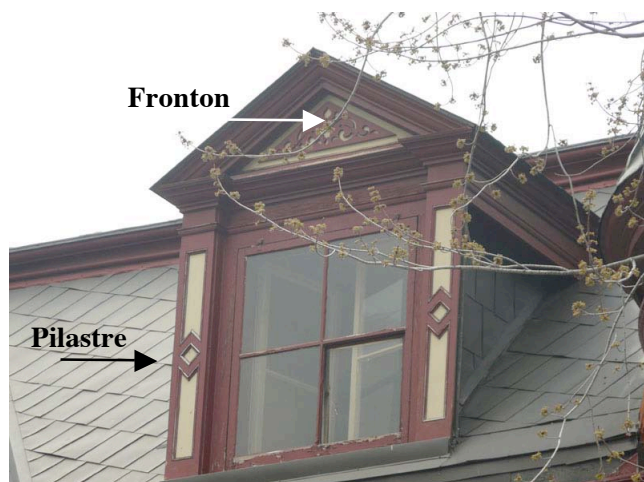
Une lucarne à fronton et pilastres. Maison Edmond-Stanislas-Aubry. 177, promenade du Portage, secteur de Hull. P1010350.jpg
