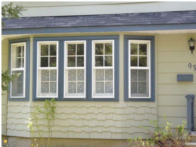
Fenêtres en saillie, revêtement de bardeau de bois. 93, rue Poplar, secteur de Gatineau. P1030148.jpg
