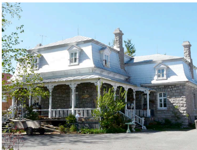
Ancien presbytère d'Angers, 245, rue du Progrès, secteur de Masson-Angers, datant de 1888. Il a conservé son ancienne cuisine d'été (à droite). Architecture second Empire. P1040904.jpg
