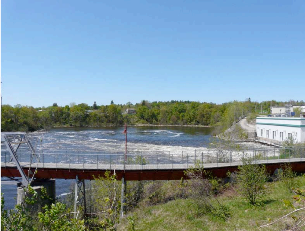
Barrage, rivière du Lièvre, secteur de Buckingham. P1040742.jpg
