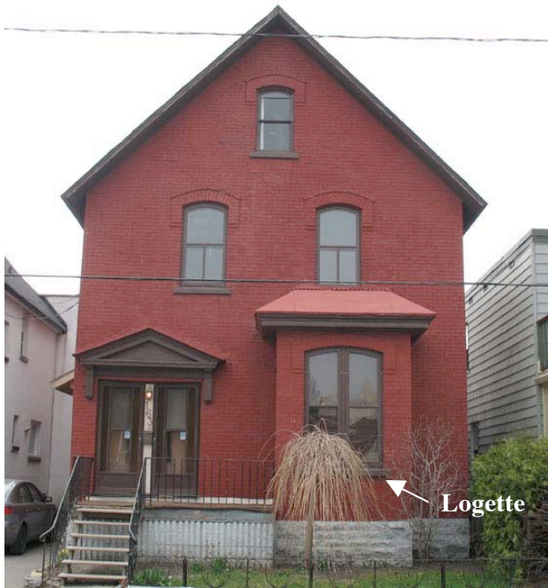
Le 163, rue Notre-Dame-de-l'Île, secteur de Hull. Au rez-de-chaussée, à droite, se trouve une logette (fenêtre en saillie d'un seul niveau). Des jeux de brique surmontent les fenêtres en arc surbaissé.
