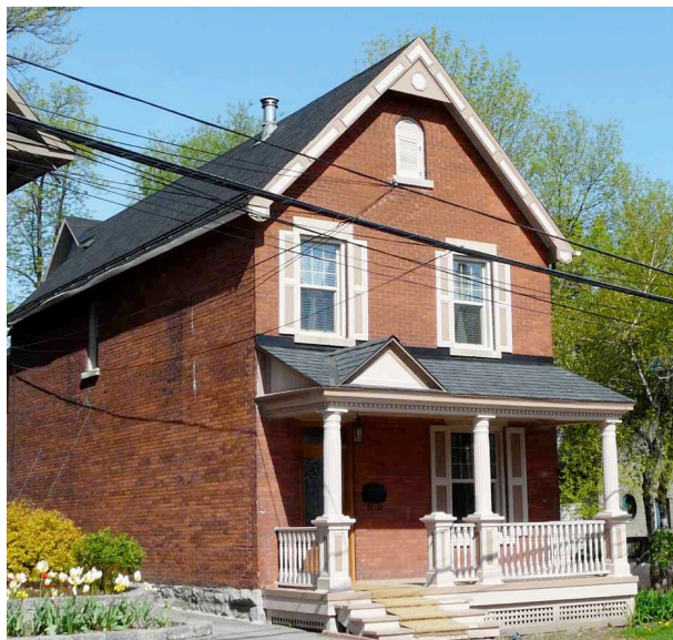
Le 25, rue Hanson en 2008, secteur de Hull. A la suite de travaux de restauration, des éléments décoratifs en bois ont été mis en place au pignon et en bordure de l'avant-toit ; on a aussi changé les
