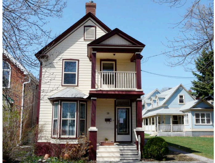
Le 16, rue Taylor, secteur de Hull. Bâtiment revêtu de planche à clin. P1010890.jpg
