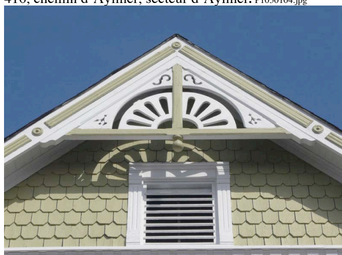
Ornement de pignon, découpé, en bois. Le revêtement est en bardeau de bois découpé. 612, avenue de Buckingham, secteur de Buckingham. P1000966.jpg
