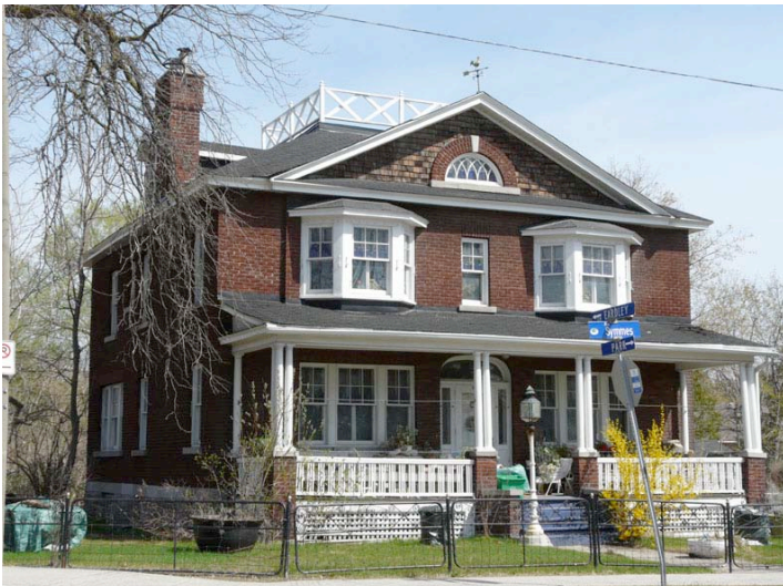
Exemple d'édifice à toit en pavillon. Outre sa forme presque carrée, ce genre d'édifice se démarque par son toit à quatre versants, aussi appelé toit en pavillon. 81, rue Symmes, secteur d'Aylmer. P1020464.jpg
