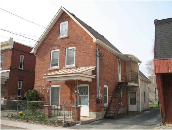
Exemple d'édifice à toit à deux versants droits à pignon sur rue (maison hulloise). Le toit à deux versants droits, l'orientation à pignon sur rue et la forme étroite du plan singularisent ce genre d'édifice. 133, rue Wright, secteur de Hull. IMG_5339.jpg
