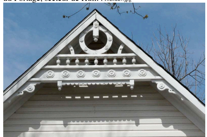
Ornement de bois, découpé, au sommet d'un pignon. 93, rue Thomas, secteur d'Aylmer. P1020583.jpg
