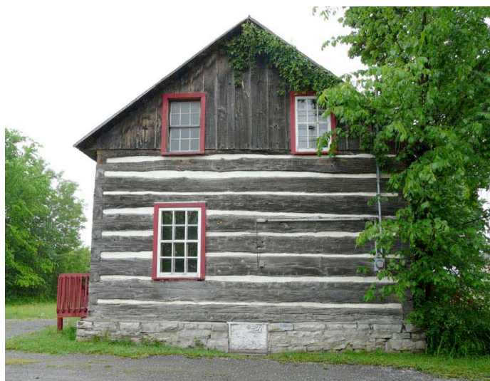
Mur pignon de la maison Maxwell, 581, boulevard de la Cité-des-Jeunes, secteur de Hull. P1050499.jpg
