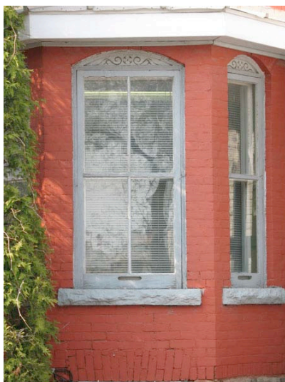
Fenêtre à guillotine à arc surbaissé, sur une logette. 137, rue Wright, secteur de Hull. IMG_5335.jpg
