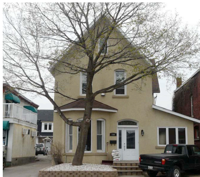
Le 156, rue Notre-Dame-de-l'Île en 2008, secteur de Hull. Le revêtement de brique a été dissimulé sous un enduit de stuc. En outre, la galerie couverte, son toit, et le garde-corps sont disparus. De plus, les fenêtres à guillotine à grands carreaux ont été modifiées à l'étage. P1010521.jpg
