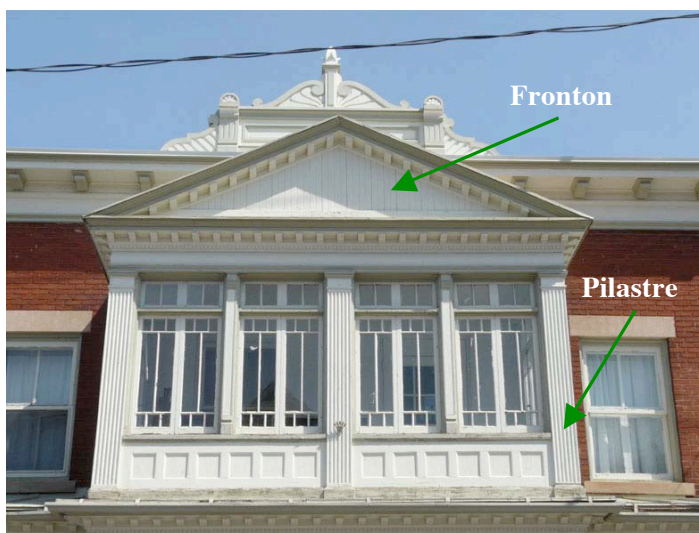
Solarium orné de pilastres et surmonté d'un fronton triangulaire. 172-174, rue Champlain, secteur de Hull. P1010923.jpg
