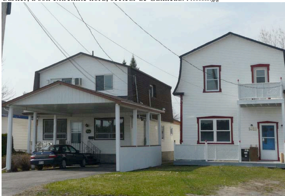
Des édifices à toit mansardé, rue Jacques-Cartier, dans le site du patrimoine Jacques-Cartier, secteur de Gatineau, dont l'état d'authenticité a été altéré.
