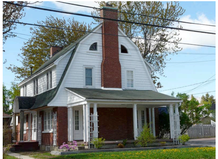
Exemple d'édifice Arts and Crafts . Le toit à versants brisés singularise ce genre d'immeuble. 150, rue Maclaren Ouest, secteur de Buckingham. P1040590.jpg
