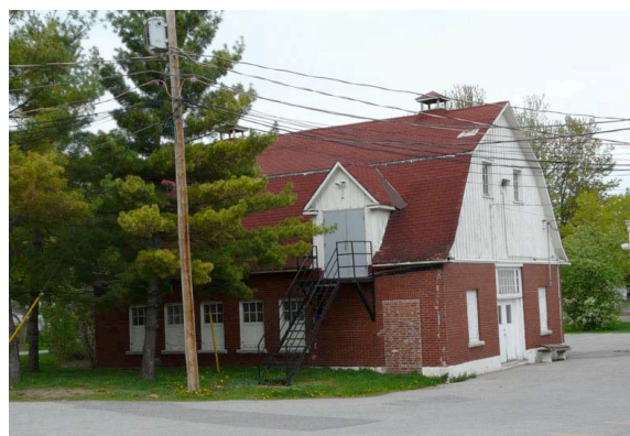
Un des bâtiments secondaires associé à l'ancien laboratoire de la ferme expérimentale de Hull. 100, rue Gamelin, secteur de Hull. P1040482.jpg
