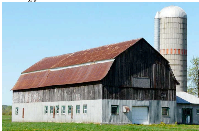
Grange-étable au toit à versants brisés. 1697, chemin de Montréal, secteur de Masson-Angers. P1040912.jpg
