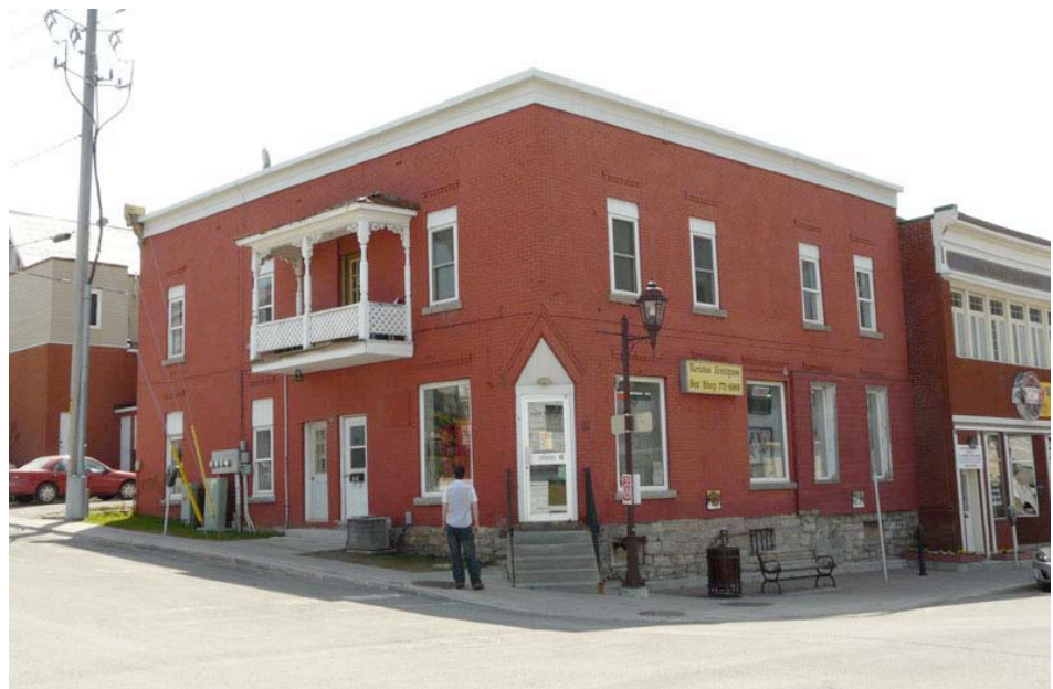
Le 62, rue Eddy, secteur de Hull, en 2008. En plus du changement de modèle de fenêtres et de portes, le dernier étage a été supprimé. Cependant, le balcon et les plates-bandes en brique au-dessus des ouvertures ont été conservés, dont celles surmontant la porte en coin. P1040204.jpg
