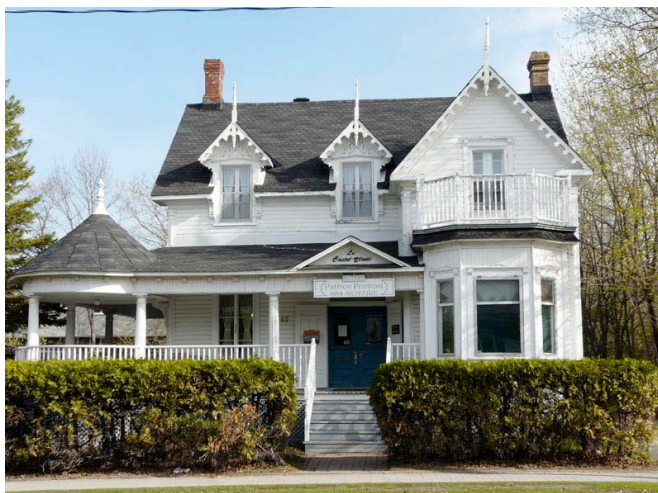
Le 43, rue Principale, secteur d'Aylmer. Un édifice au toit à deux versants droits, au plan en L à deux niveaux d'occupation. P1020256.jpg
