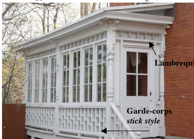
Fenêtres à six carreaux d'un solarium et garde-corps stick style , en bas, et lambrequin à la partie supérieure. 33, rue Principale, secteur d'Aylmer. P1020229.jpg
