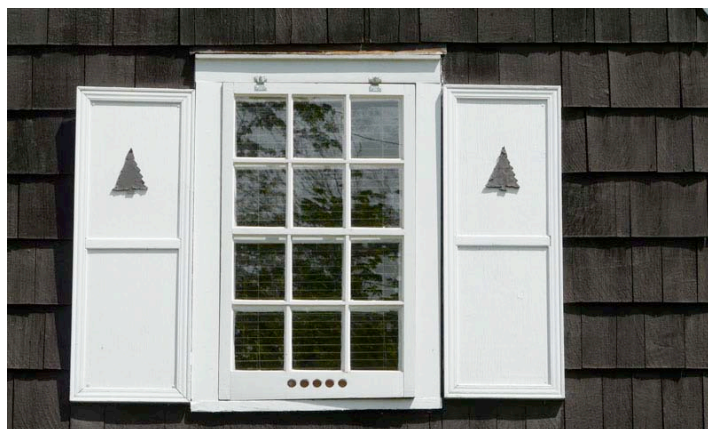
Fenêtre à guillotine à douze petits carreaux avec persiennes anciennes. 124, rue Poplar, secteur de Gatineau. P1030218.jpg
