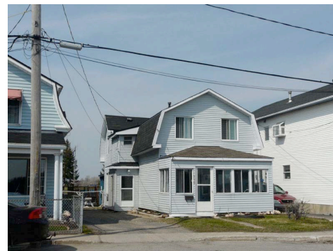
Bâtiment à toit mansardé, orienté à pignon sur rue, possédant un faible état d'authenticité, rue Jacques-Cartier, secteur de Gatineau. P1000766.jpg
