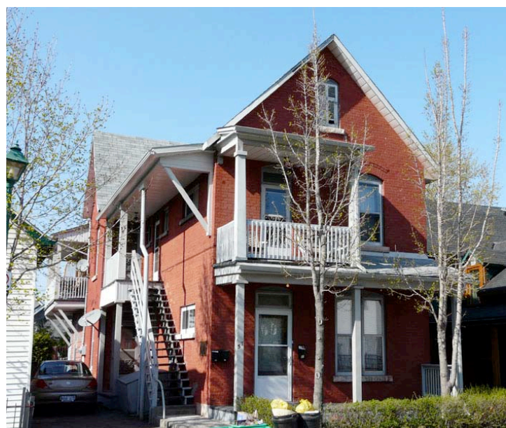
Le 57, rue Vaudreuil en 2008, secteur de Hull. L'édifice a conservé l'essentiel de ses caractéristiques, exceptions faites du garde-corps du balcon et de l'élément décoratif en bordure de la toiture du balcon (lambrequin). P1020137.jpg
