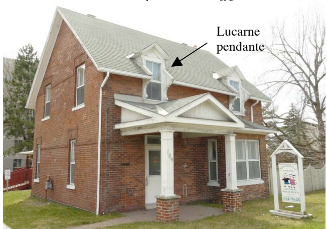
Ancien presbytère de l'église Unie d'Aylmer, secteur d'Aylmer, construit en 1900. Des lucarnes « pendantes » singularisent l'édifice. P1020616.jpg
