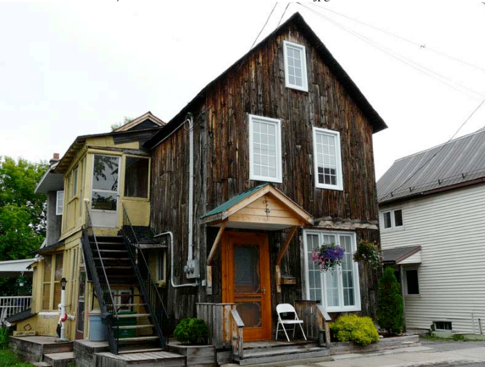
Une des seules maisons « allumettes » revêtues de madriers verticaux en bois. 1, rue Garneau, secteur de Hull. P1050561.jpg
