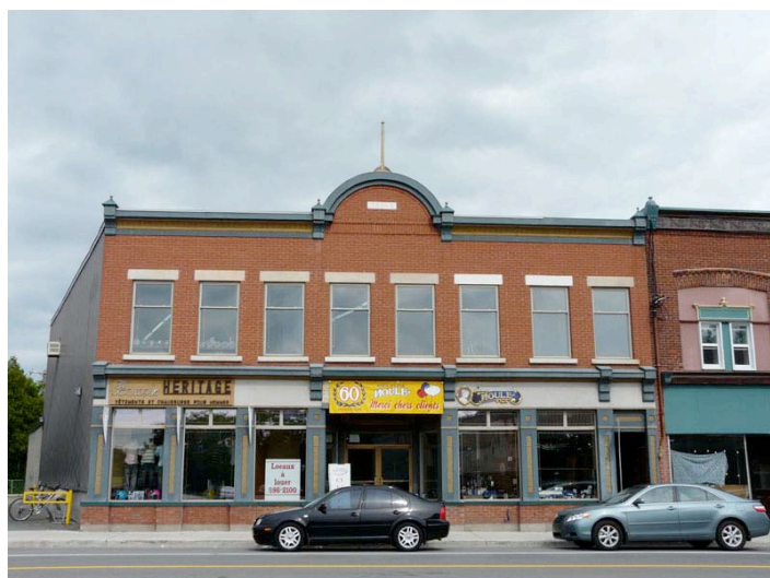
Exemple de bâtiment associé à l'architecture commerciale. L'édifice Houle, 470-476, avenue de Buckingham, secteur de Buckingham. Construit en 1917, il logeait initialement deux espaces commerciaux. L'édifice à toit plat comporte en façade avant une corniche et, au centre, un couronnement, cet élément décoratif de forme semi-circulaire où l'on retrouve une pierre gravée avec le nom de l'édifice. P1050464.jpg
