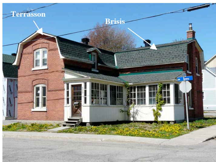
Exemple d'édifice au toit à terrasson et à brisis. Sa principale caractéristique est le toit mansardé avec son terrasson dans la partie supérieure et le brisis dans la partie inférieure. Le toit peut être sur deux versants (comme c'est le cas ici) ou sur quatre. 569, rue Kenny, secteur de Buckingham. P1040631.jpg
