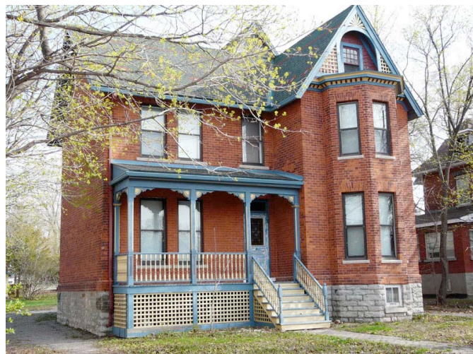
Le 45, rue Principale, secteur d'Aylmer. Un édifice en brique au toit à deux versants à pignons latéraux avec avant-corps en façade (à droite). P1020262.jpg
