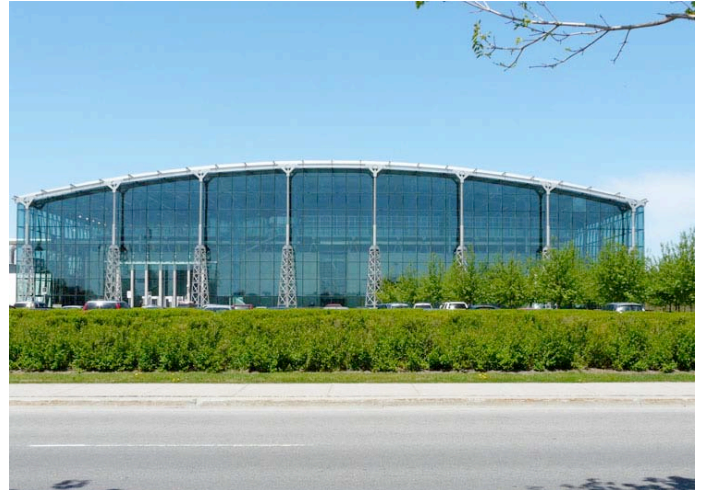
Centre de préservation de Bibliothèque et Archives Canada (BAC), secteur de Gatineau, bel exemple d'architecture moderne. P1030743.jpg
