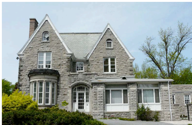
Maison Wright-Scott. 28, boulevard Alexandre-Taché, classée par le Bureau d'examen des édifices fédéraux du patrimoine. P1040370.jpg
