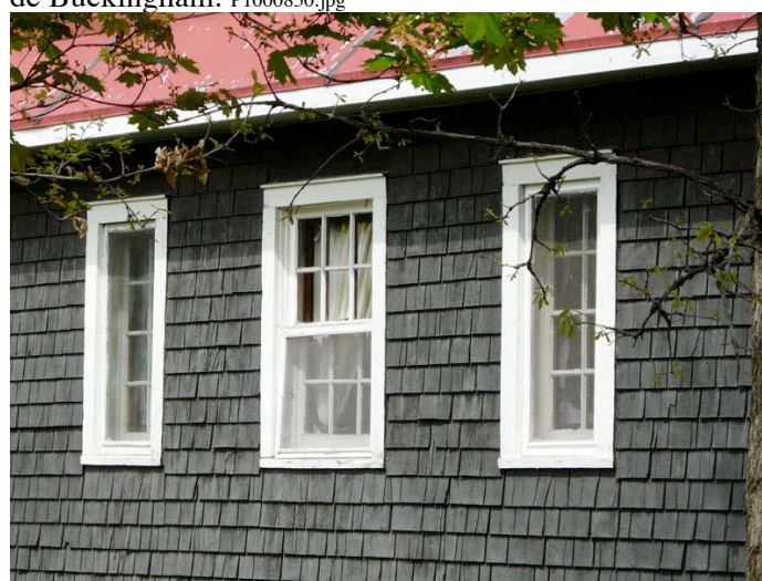
Revêtement de bardeau de bois. Ils sont probablement d'origine (1928). 175, rue James-Murray, secteur de Gatineau. P1030310.jpg
