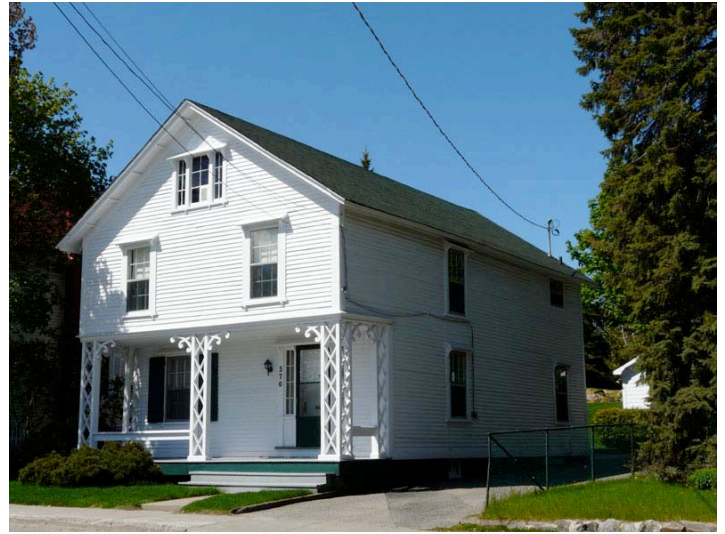
Exemple d'édifice orienté à pignon sur rue. Très proche « parente » de la maison hulloise, celle-ci s'en distingue uniquement par son plan un peu plus large. 570, rue Georges, secteur de Buckingham. P1040654.jpg
