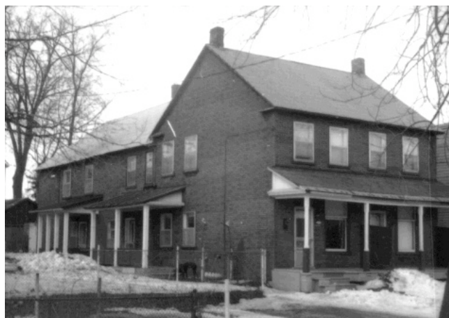
Le 20-22, rue Taylor, secteur de Hull. Date indéterminée. Parue dans : Patrimoine Outaouais, Fonds et Collections, Patrimoine bâti. http://patrimoineoutaouais.ca
