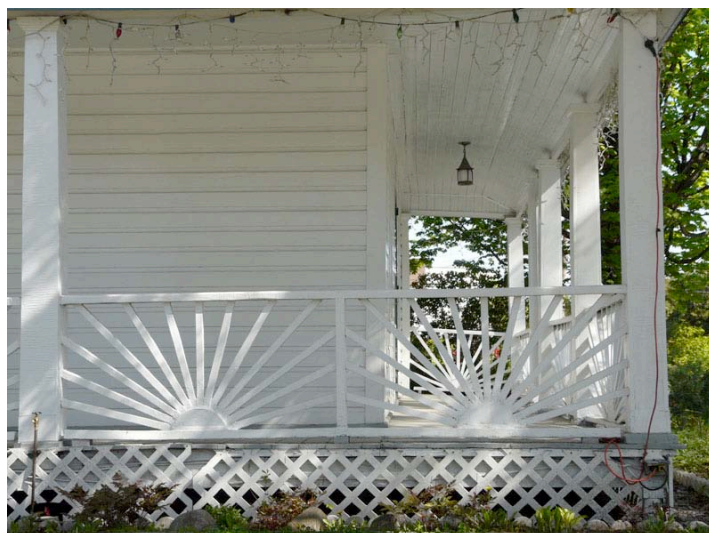
Garde-corps dont les barreaux sont à motifs rayonnants. 82, rue Saint-Antoine, secteur de Gatineau. P1030572.jpg
