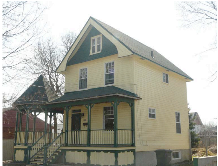
Le 345, rue Charles, secteur de Buckingham. Bâtiment revêtu de planche à feuillure. P1010257.jpg
