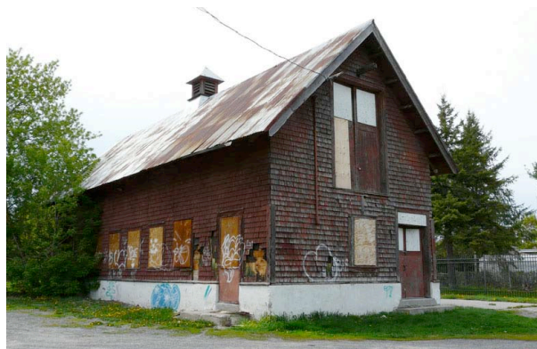
Un des bâtiments secondaires sis sur la propriété de la maison Fairview. 100, rue Gamelin, secteur de Hull. P1040463.jpg
