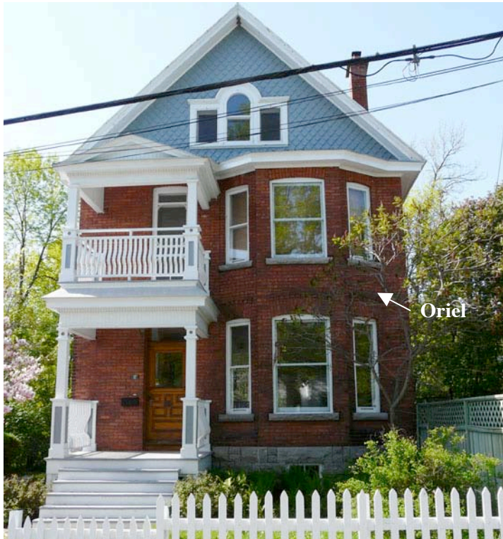
Le 6, rue Wright, secteur de Hull. Voici une variante de la maison « allumette » où un oriel (fenêtre en saillie sur deux niveaux) occupe la moitié de la façade avant. P1040024.jpg
