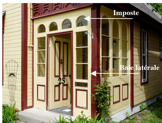
Un imposant portique orné d'impôstes en arc de cercle et de baies latérales de chaque côté de la porte. Maison John-Davis, 23, rue du Couvent, secteur d'Aylmer. P1050198.jpg
