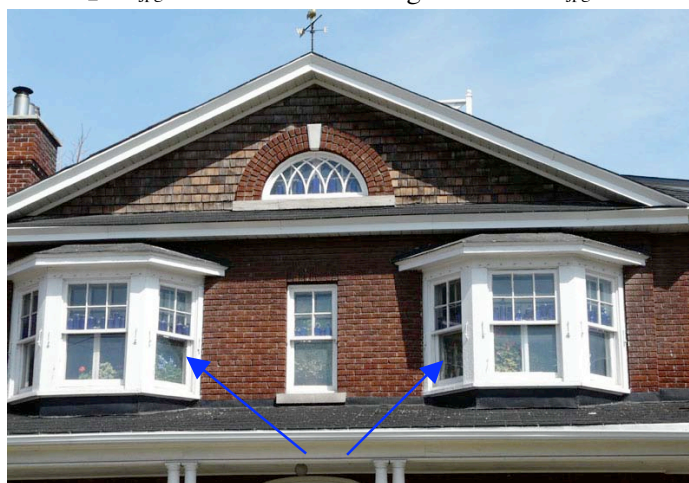
Deux fenêtres en saillie (flèches) situées entre un fronton et le toit surmontant la galerie. 81, rue Symmes, secteur d'Aylmer. P1020461.jpg
