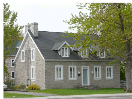
Maison Joseph-Lebel, construite vers 1830. 370, chemin d’Aylmer, secteur d’Aylmer. P1050110.jpg
