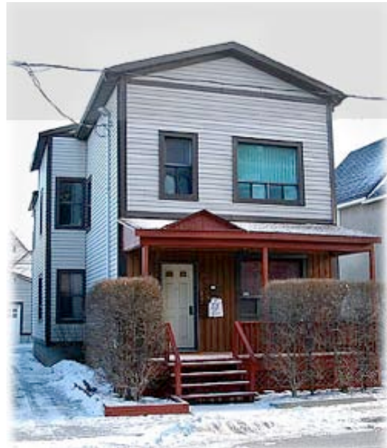
Le 260, rue Champlain, secteur de Hull en 2002. Un toit à deux versants est venu remplacer le toit plat d'origine. En outre, le modèle des fenêtres a été changé. Parue dans : http://www.civilization.ca/hist/hull
