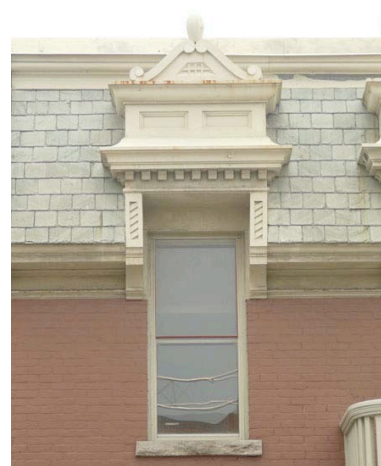
Lucarne pendante, c'est-à-dire interrompant l'avant-toit ; elle est surmontée d'un élément sculpté. 116, promenade du Portage, secteur de Hull. P1020229.jpg
