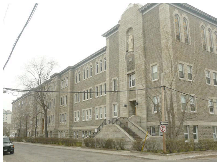
Exemple d'édifice relié à l'architecture publique. Le collège Saint-Joseph, construit en 1952. 172-174, rue Notre-Dame-de-l'Île, secteur de Hull. P1010532.jpg
