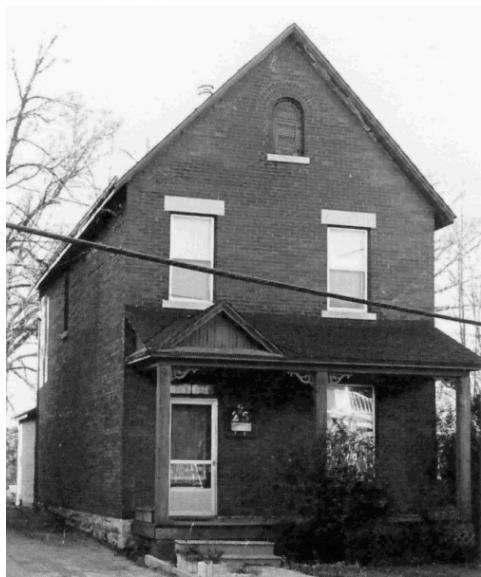
Le 25, rue Hanson, secteur de Hull. Date indéterminée. Parue dans : Patrimoine Outaouais, Fonds et Collections, Patrimoine bâti.
