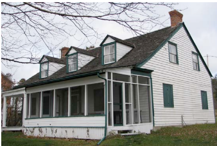
La maison du bourgeois, construite en 1845, est le plus ancien témoin bâti des comptoirs de la Compagnie de la baie d'Hudson dans l'Outaouais.
