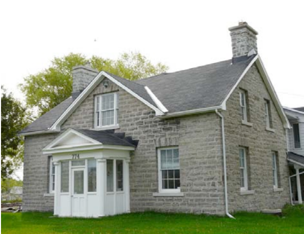
Le 774, chemin d'Aylmer, construit vers 1880. Secteur d'Aylmer de Gatineau.
