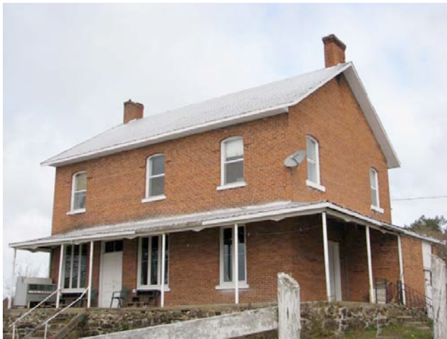
Ancien magasin général McCool construit vers 1870 sur les fondations de l'ancien magasin de la Compagnie de la baie d'Hudson.
