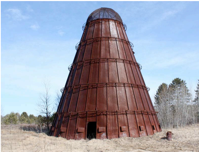
Incinérateur métallique de forme conique, avec grillage métallique à l'extrémité supérieure. Route 301, Kazabazua.
