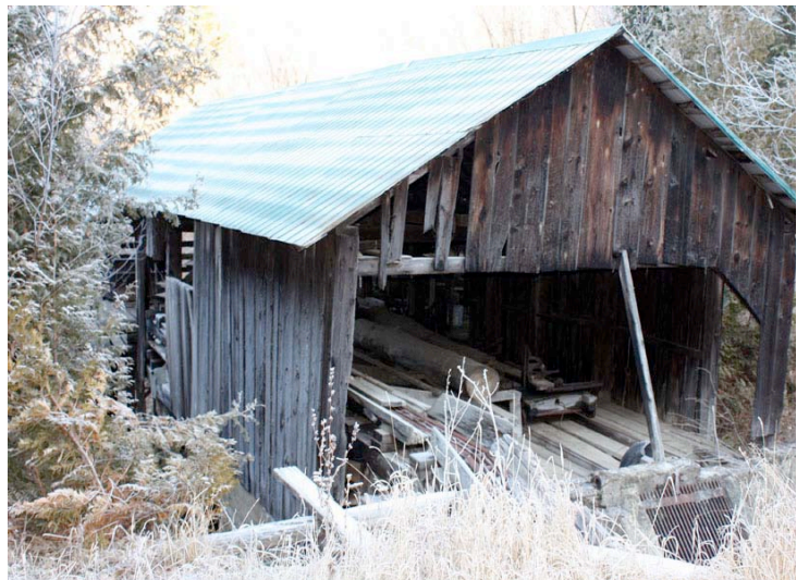
Mur-pignon du moulin de Jarnac.
