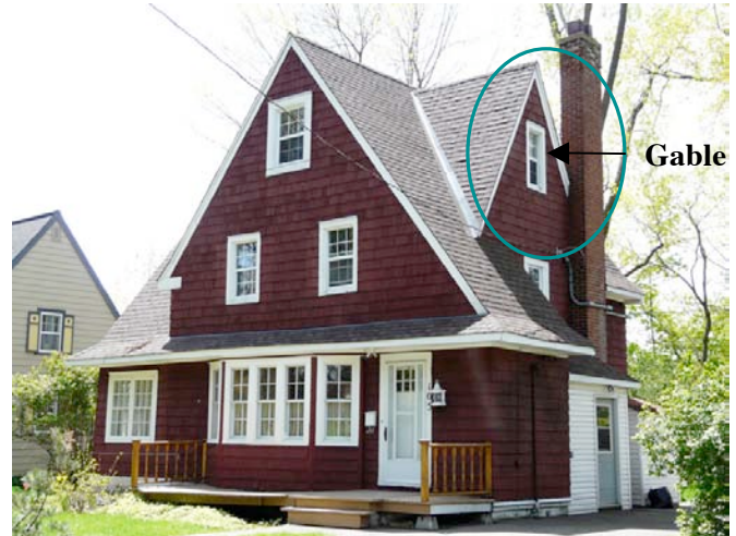
Le 105, rue Poplar, Gatineau. Il comprend deux niveaux et demi et se distingue par son orientation à pignon sur rue. Un gable (lucarne triangulaire) est localisé au mur latéral droit.
