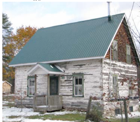
Bâtiment principal en pièce sur pièce, situé au 1223, chemin de Chapeau-Waltham à Chichester.
