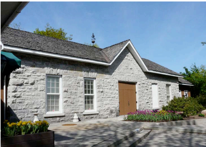
Bâtiment du premier aqueduc de Hull construit en 1886. Il abrite aujourd'hui le Théâtre de l'Île. 2, rue Wellington, secteur de Hull de Gatineau.
