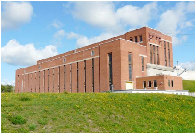
Centrale des Rapides-Farmer, construite entre 1926 et 1927. Remarquable par ses qualités architecturales de style Art déco, cette centrale est de type « au fil de l'eau ». Route 307, Gatineau.
