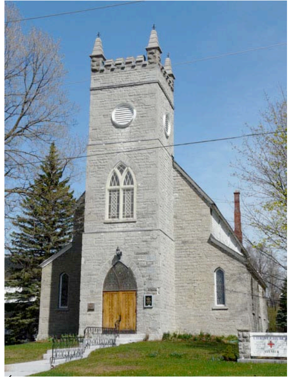
Église anglicane Christ Church, rue Symmes, secteur d'Aylmer de Gatineau. Érigée entre 1843 et 1845, elle est la plus ancienne église de la ville.
