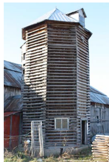
Annexé à une grange-étable, un des très rares silos en bois qui subsistent encore dans la MRC de Papineau. 801, route 317, Saint-Sixte.
