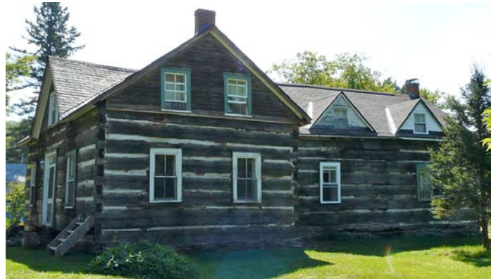
Arrière de la ferme avec un corps secondaire placé perpendiculairement.
