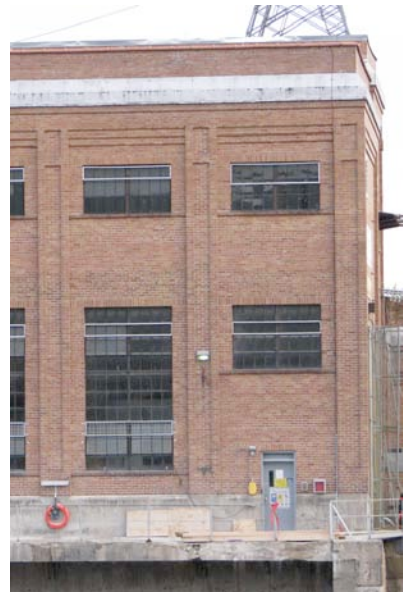
Détail des jeux de brique qui forment l'essentiel de l'ornementation de la centrale.
