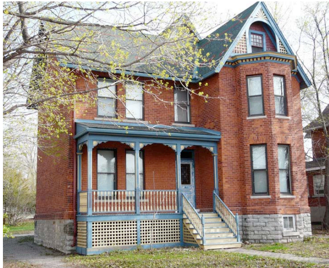
Le 45, rue Principale, secteur d'Aylmer de Gatineau. Un édifice éclectique sur lequel l'influence du style Queen Anne est perceptible à en juger par la présence de l'avant-corps et de la fenêtre en saillie (à droite). La partie supérieure est ornée d'éléments en bois découpés.
