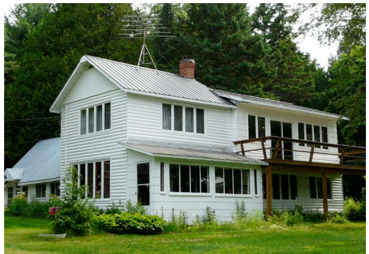
Maison Michel-Jolicœur, 29, chemin Lac-McGregor, Val-des-Monts. Un édifice en pièce sur pièce qui aurait été construit vers 1825.
