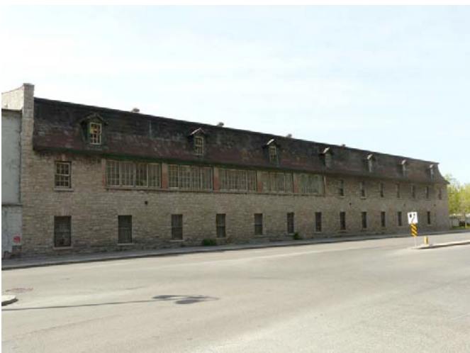
Édifice E.-B.-Eddy. dont la construction s'est amorcée en 1892. Il sert alors d'entrepôt à la nouvelle manufacture de papier d'E. B. Eddy. 6, boulevard Alexandre-Taché, secteur de Hull de Gatineau.
