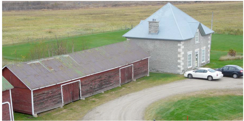
Dépendance et maison du comptable.
