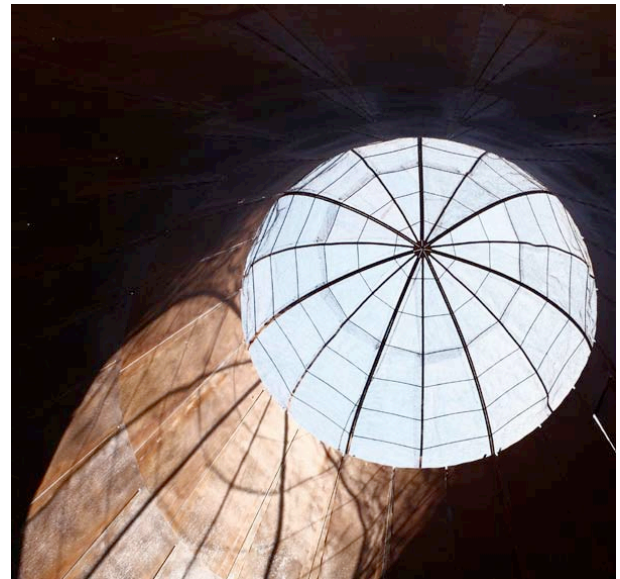
Vue de l'intérieur de l'incinérateur : le grillage métallique à l'extrémité supérieure.
