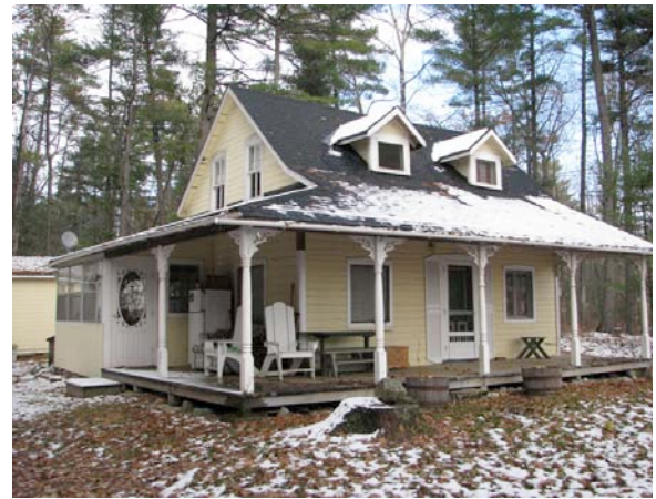
Résidence secondaire érigée vers 1895, l'une des plus vieilles de la région. 16, rue Graham, Bristol.
