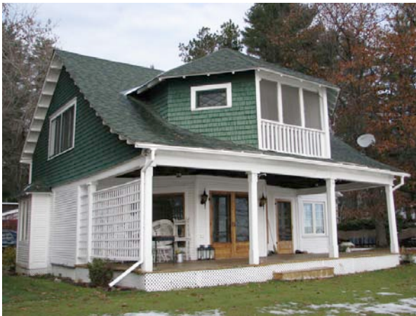
Résidence secondaire érigée vers 1910, aux abords de la rivière des Outaouais. 21, rue Graham, Bristol.
