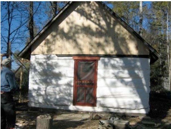
Ancien poste de traite de la Compagnie de la baie d'Hudson construit vers 1850, aujourd'hui transformé en chalet. Île Roy, Déléage.
