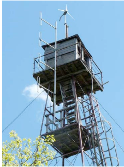
Le mirador ou cabine du gardien de la tour de feu de Pontiac. Photo : CCN.
