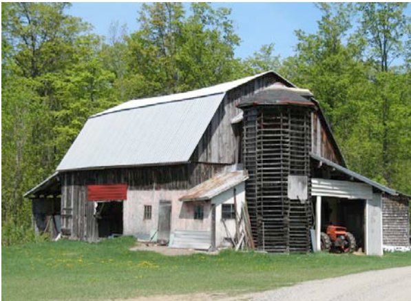
Silo de bois annexé au mur-pignon d'une grange-étable. 524, chemin Pierre-Laporte, L'Ange-Gardien.
