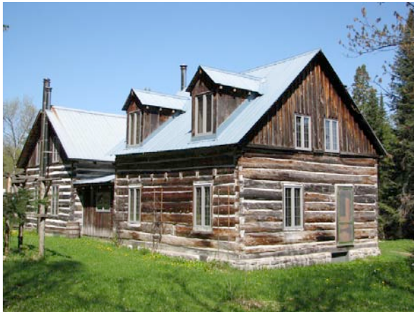
Bâtiment en pièce sur pièce qui se démarque par un très bon état physique. 4405, chemin River, L'Ange-Gardien.
