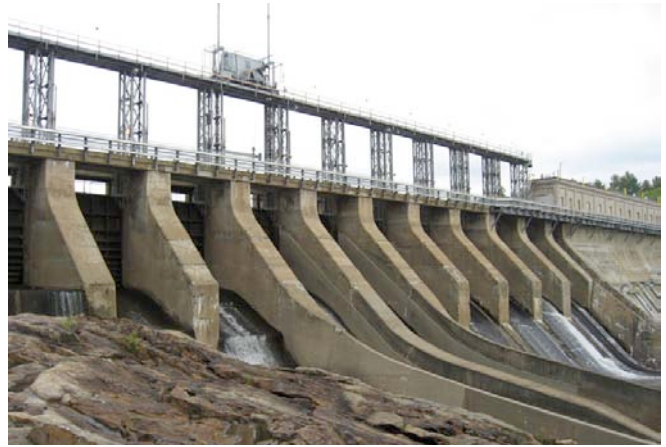
Construit entre 1926 et 1927, le barrage Mercier a permis la création du réservoir Baskatong, un imposant lac artificiel d'une superficie de 316 041 980 m 2 13 . Une centrale hydroélectrique y a été mise en service en 2008. Grand-Remous.
