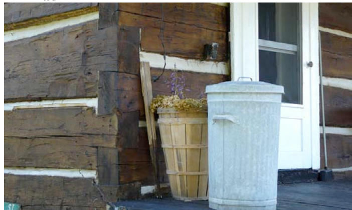
Détail de la structure en pièce sur pièce et du procédé d'assemblage à queue d'aronde.
