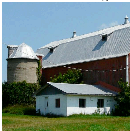
Silo en béton, à couronnement polygonal, indépendant de la grange-étable. 1287, chemin Taber, Pontiac.
