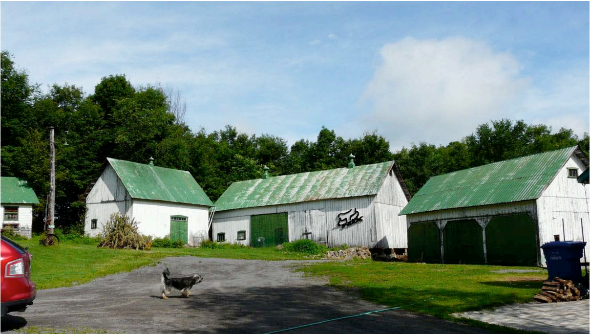
Ensemble de ferme composé de plusieurs bâtiments secondaires au 691, montée de la Source, Cantley. P1150715.jpg
