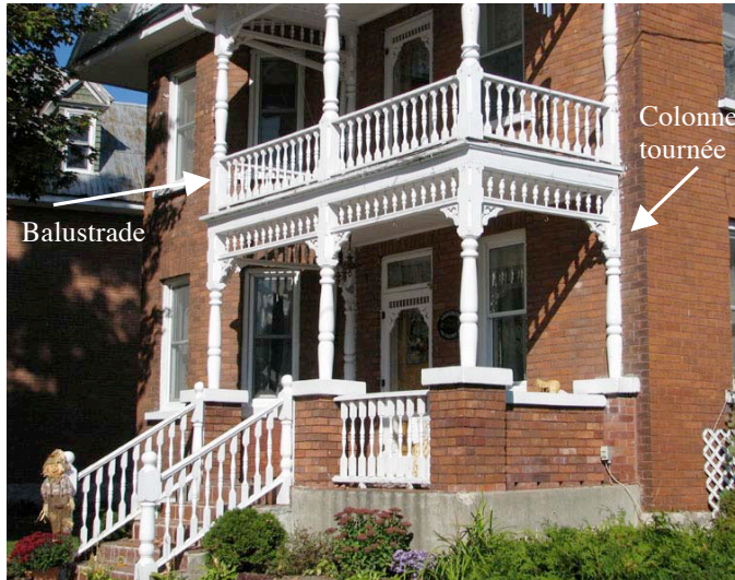
Balustrades (garde-corps formé de balustres) et aisseliers chantournés au sommet de colonnes tournées. 189, chemin Calumet, Shawville.
