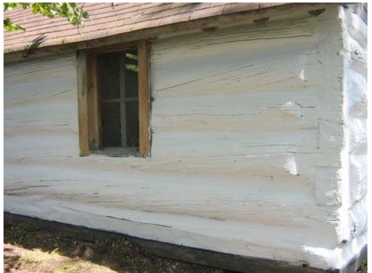
Détail du mur de l'ancien poste de traite de la Compagnie de la baie d'Hudson, formé d'imposantes pièces de bois assemblées à queue d'aronde.
