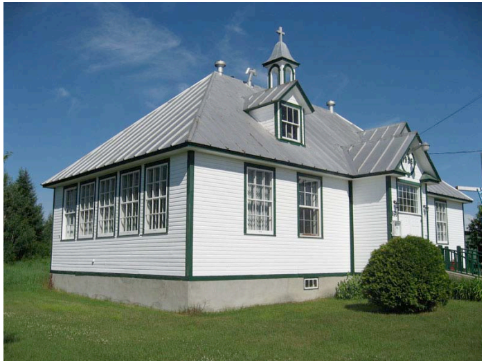
Une ancienne école qui se démarque par la qualité de son authenticité. Elle date de 1935. 189, chemin de Lytton à Montcerf-Lytton.
