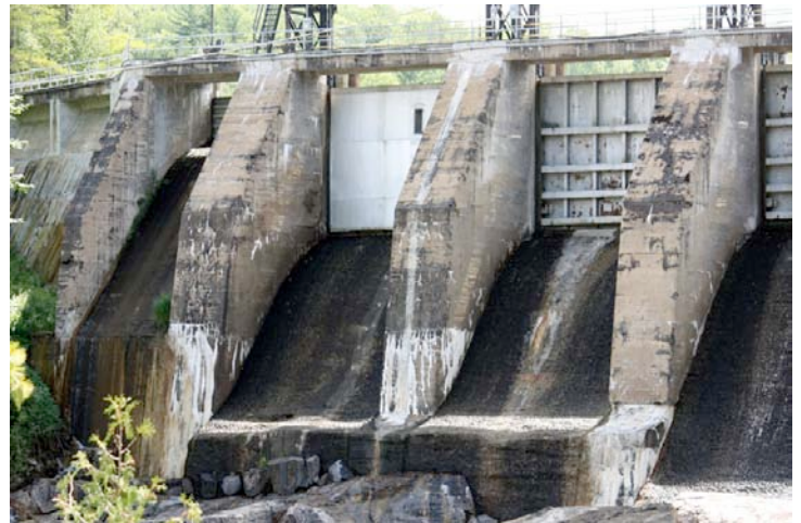
Détail des immenses évacuateurs de crue, barrage High Falls, Bowman.
