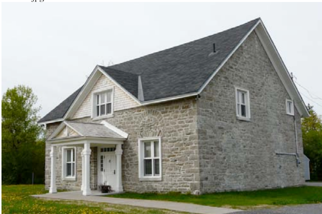
Ancienne chapelle méthodiste du canton de Hull, datant de 1827. 495, chemin d'Aylmer, secteur d'Aylmer de Gatineau.
