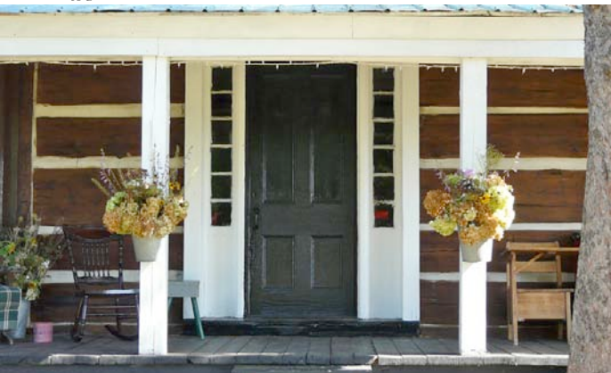
Porte principale, à panneaux et à baies latérales, de la façade avant.
