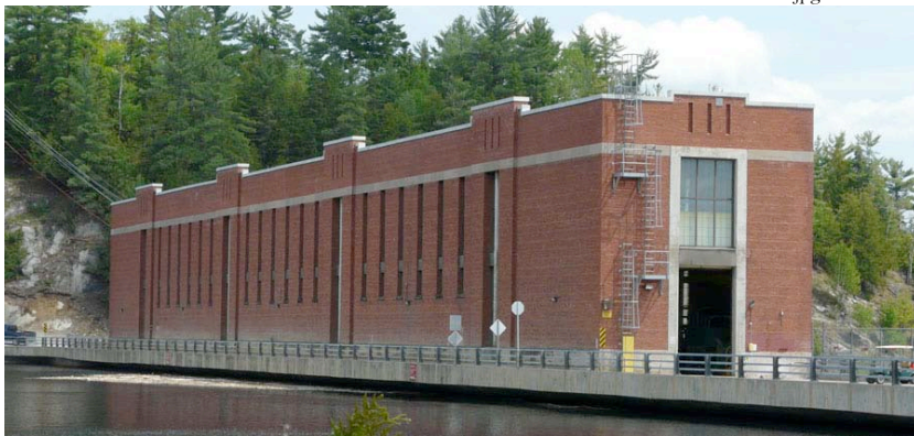
La centrale hydroélectrique érigée en 1928 au barrage Paugan à Low, lui-même construit entre 1927 et 1928.
