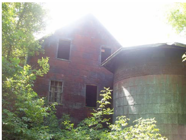
Mur-pignon du moulin et silo.
