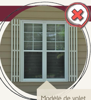
Modèle de volet non traditionnel et mal intégré à l'ouverture.
