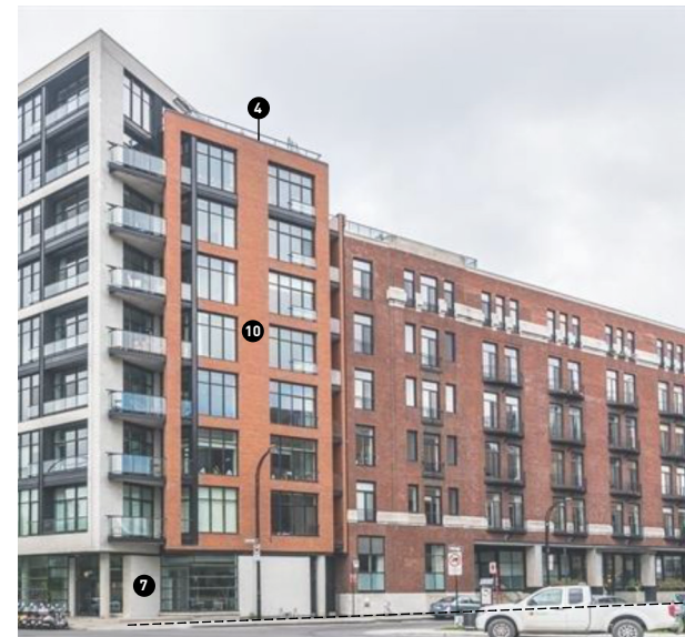
20 rue des sœurs Grises, Cardinal Hardy, Montréal, Québec (Canada), crédit photo : PRAA
