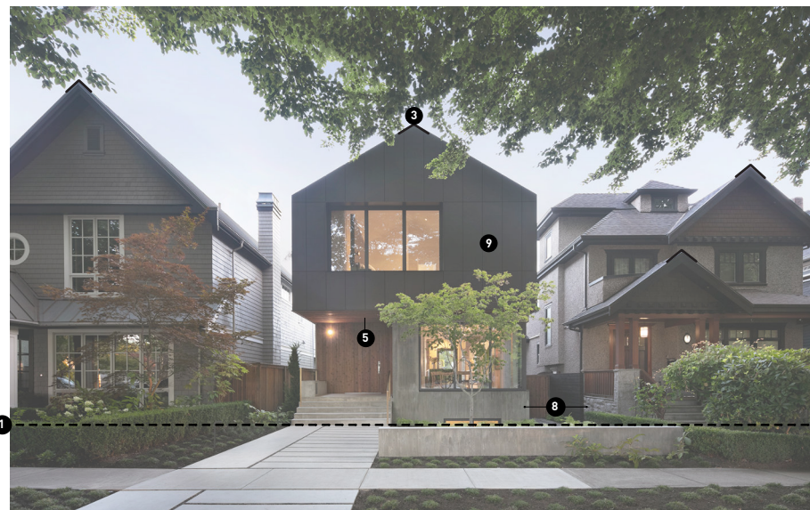
Rift house, Clinton Cuddington + Piers Cunnington, Vancouver, Colombie britannique (Canada), crédit photo : Ema Peter
