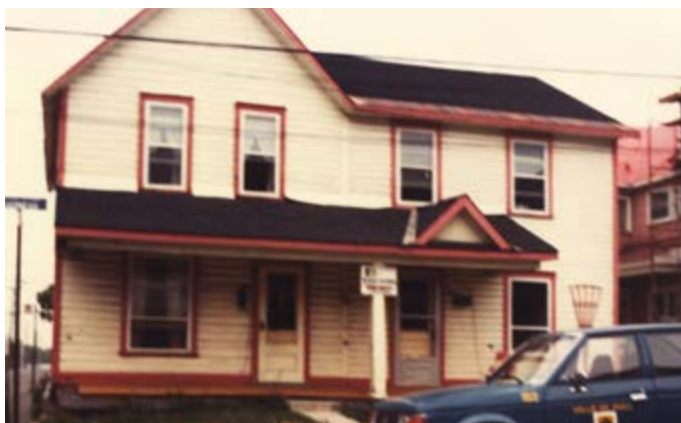
168. Maison de 2 étages, annexe au toit à deux versants, ajoutant un logement. 13, rue Garneau.
