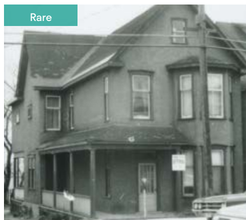
257. Plusieurs saillies sont présentes : un oriel de deux niveaux (à droite sur la façade avant) et une galerie couverte. 172, boulevard Saint-Joseph.
