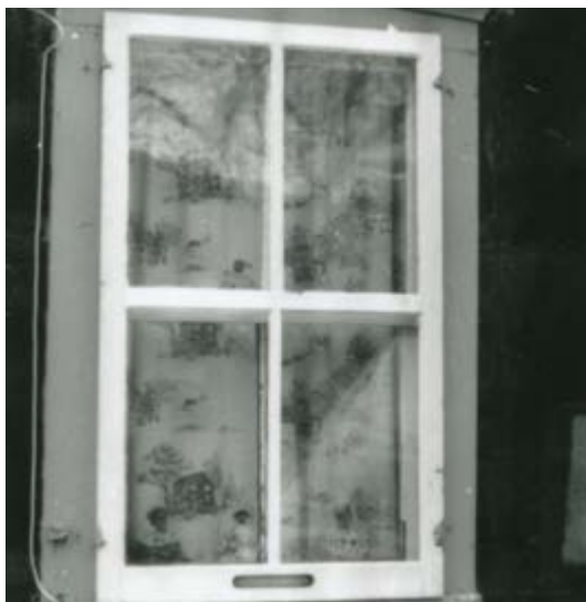
113. Contre-fenêtre à 4 carreaux. 228, rue Notre-Dame-de-l'Île.
