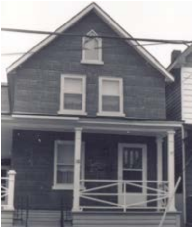
201. Composition symétrique, les baies de l'étage sont rapprochées. 13, rue Pilon.
