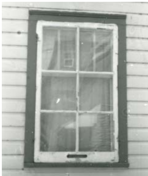
219. Contre-fenêtre à 6 carreaux. 6, rue Garneau.
