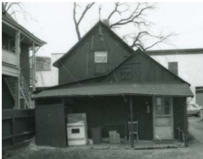
49. Maison d'un étage et demi en bois avec un corps secondaire, vu de la cour arrière. 55, rue Vaudreuil.
