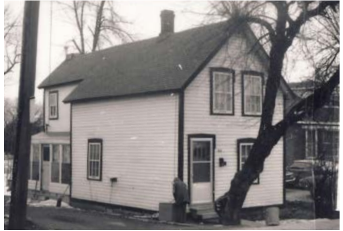
67. Maison avec un corps secondaire de deux niveaux, en retrait et au toit à mur pignon. 66, rue Hanson.
