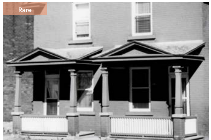
339. Perrons et auvents à fronton sur les deux entrées. 148-150, rue Notre-Dame-de-l'Île.
