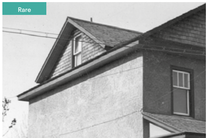
266. Lucarne-pignon latérale. 71, rue Jeanne d'Arc.
