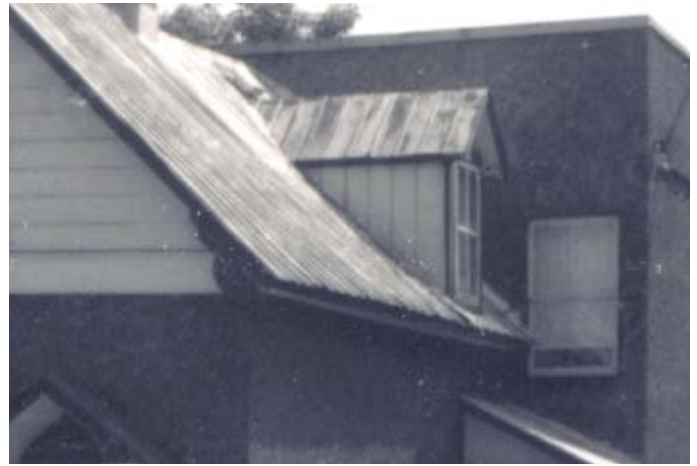
136. Lucarne à pignon. 24, rue Saint Henri.
