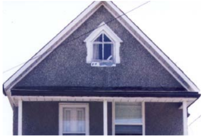
237. Fenêtre à carreaux, surmontée d'un arc en mitre. 132, rue Saint-Jacques.
