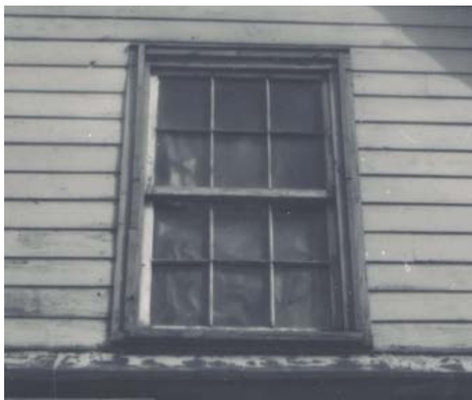
224. Fenêtre à guillotine à 12 carreaux. 164, rue Montcalm.
