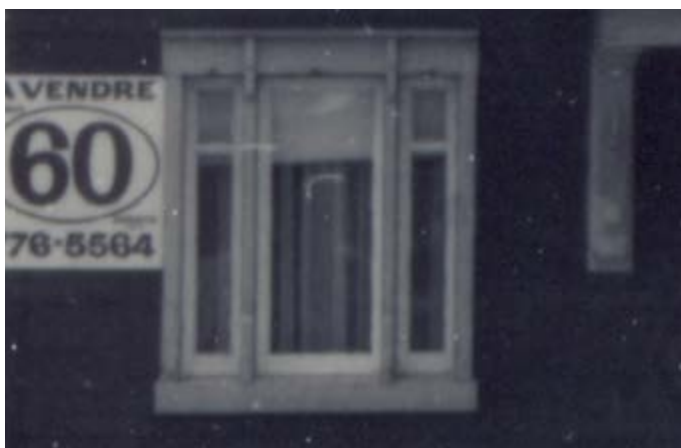
121. Fenêtre en triplet, avec un piédroit ouvragé. 80, rue Saint-Hyacinthe.
