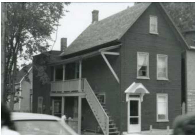
254. Escalier latéral, surmonté d'un auvent en appentis. 197, rue Saint-Rédempteur.
