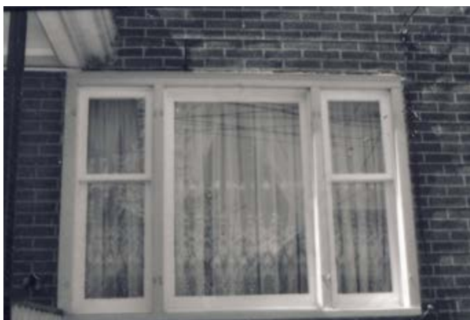
230. Fenêtre en triplet. 165, rue Dollard-des-Ormeaux.
