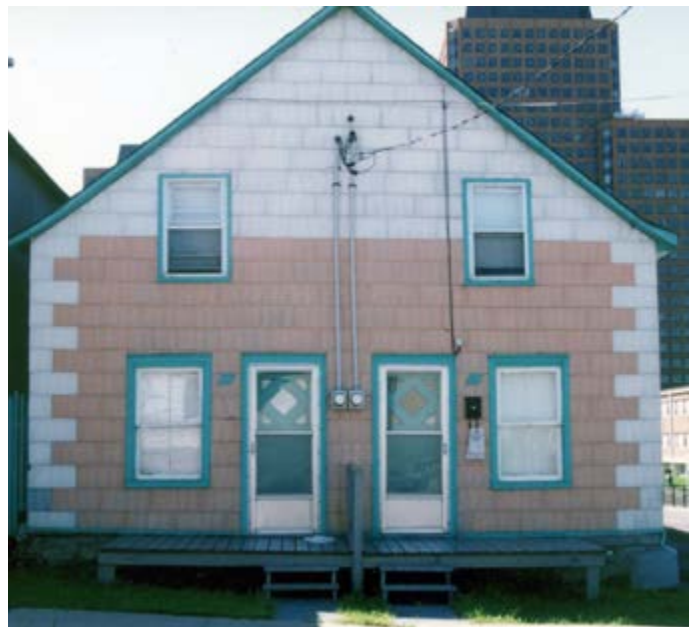
394. Revêtement en tuiles d'amiante. 10, rue Vaudreuil.
