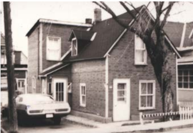
68. Maison avec un corps secondaire de deux niveaux, décalé et au toit en appentis. 227, rue Notre-Dame-de-l'Île.
