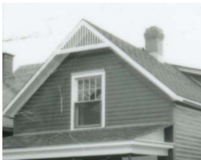
152. Gâble simple sous le pignon. 61, rue Vaudreuil.
