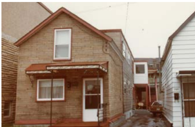
81. Toiture à pente faible. 18, rue Kent.
