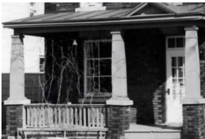
373. Garde-corps en barreaux droits en bois. 278, boulevard Maisonneuve.
