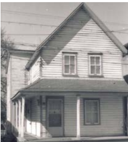
250. Galerie sur les façades avant et latérale. 265, rue Champlain.
