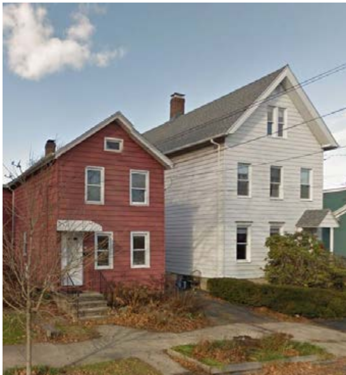
431. Maison de deux étages et demi en bois. 58, rue Anderson.
