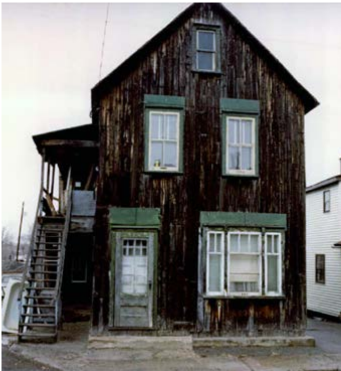
403. Baie agrandie au rez-de-chaussée, avec des meneaux anciens. 1, rue Garneau.
