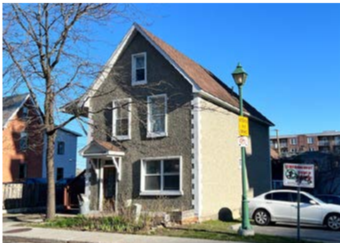
391. Revêtement ancien et non traditionnel en agrégats, avec chaînes d'angle. 75, rue Vaudreuil.
