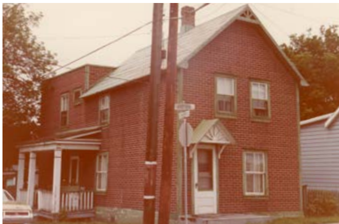
156. Maison de 2 étages, corps secondaire de 2 niveaux, aligné et au toit plat. 89, rue Dollard-de-Ormeaux.
