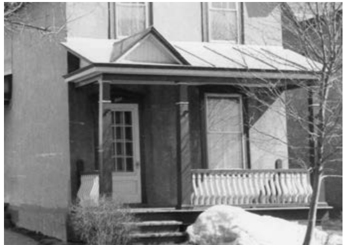
182. Toit de l'auvent en tôle pincée. 308, rue Champlain.
