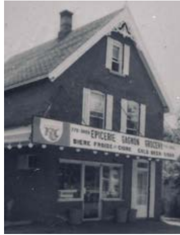
356. Cheminée au centre de la maison. 417, boulevard Alexandre Taché.
