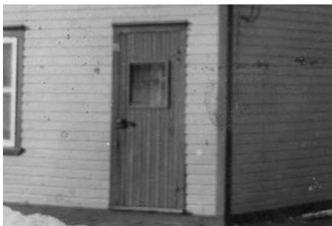
217. Contre-porte fenestrée en bois. 71, rue Charlevoix.
