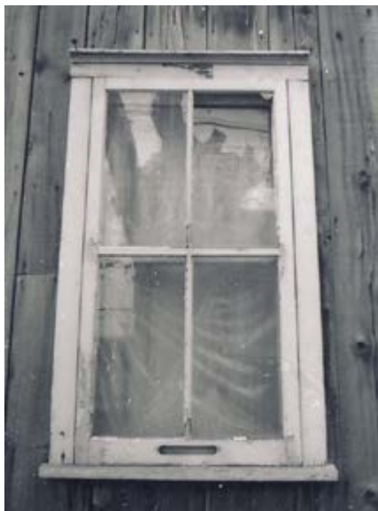
218. Contre-fenêtre à 4 carreaux. 328, rue Champlain.
