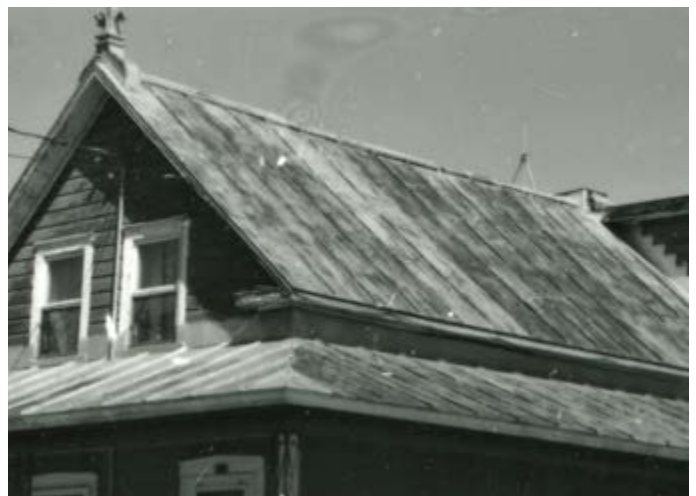
86. Toit en tôle pincée. 83, rue Frontenac.
