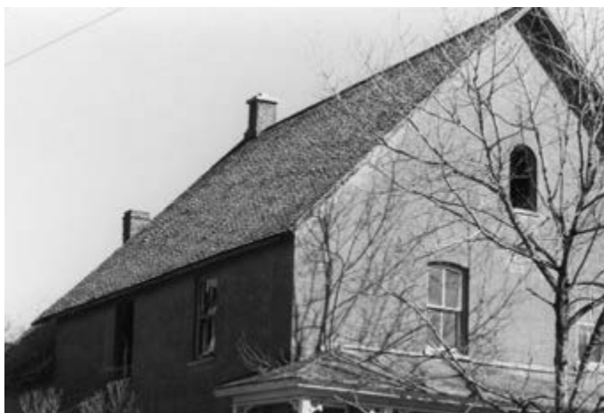
302. Toit en bardeaux de cèdre. Emplacement inconnu.
