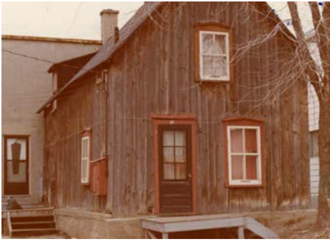
91. Parement en planches verticales brutes à couvre-joint. 90, rue Charlevoix.
