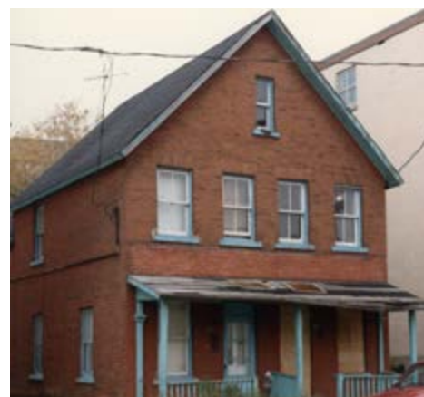
318. Composition symétrique, avec quatre ouvertures alignées aux deux niveaux. Rue Champlain.
