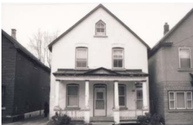
317. Composition symétrique, avec une porte centrée et une autre décentrée. 73, rue de l'Hôtel-de-ville.
