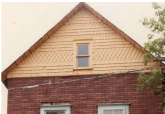
274. Ornement sur le pignon, en bardeaux de bois taillés. 271, rue Notre-Dame-de-l'Île.
