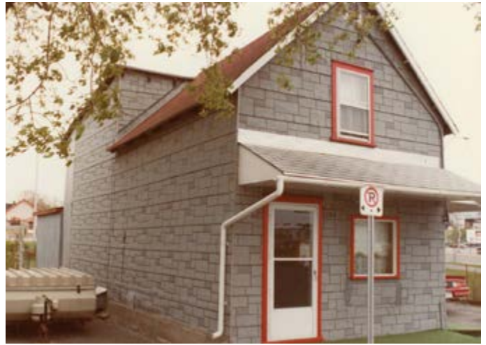
96. Parement en papier brique. 120, rue Dollard-des-Ormeaux.
