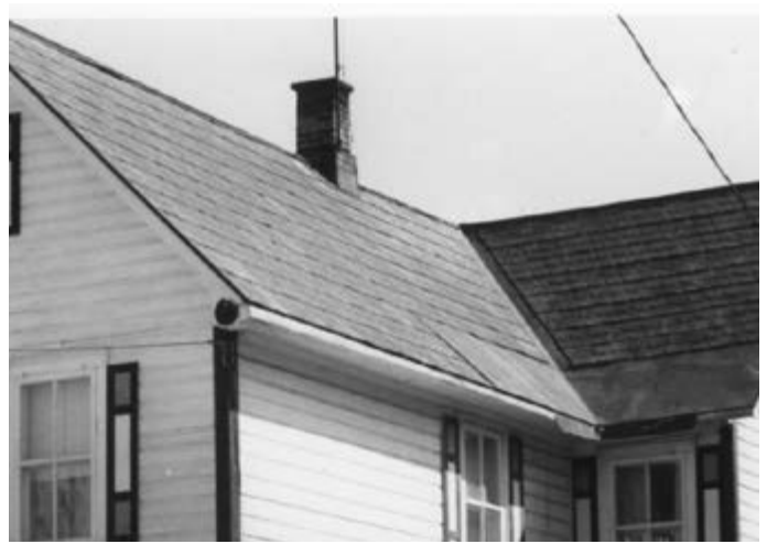
180. Toit en tôle embossée. 254, rue Champlain.
