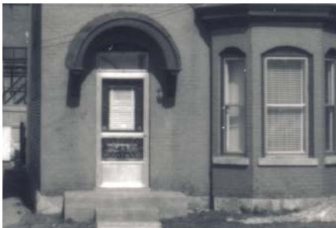
338. Auvent en plein cintre, sans colonnes (à gauche). 31, rue Wright.
