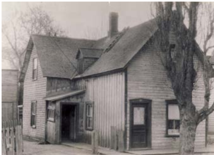
87. Combinaison de plusieurs parements : planches à feuillure ou à gorge, planches à couvre-joint, bardeaux de bois et planches brutes verticales. Emplacement inconnu.
