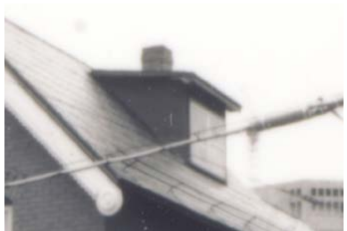
364. Lucarne rampante. 62, rue de l'Hôtel-de-ville.
