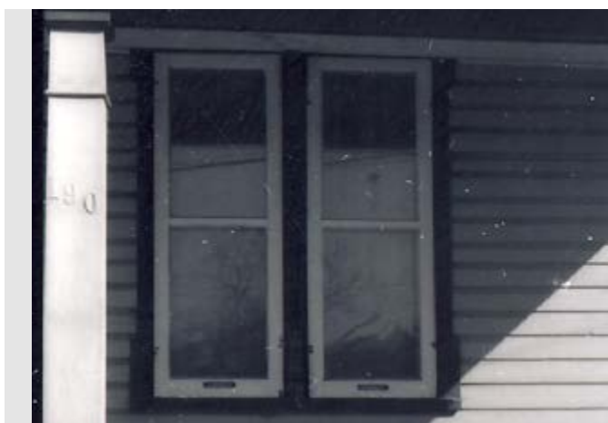
227. Fenêtre jumelée à carreaux. 190, rue Champlain.
