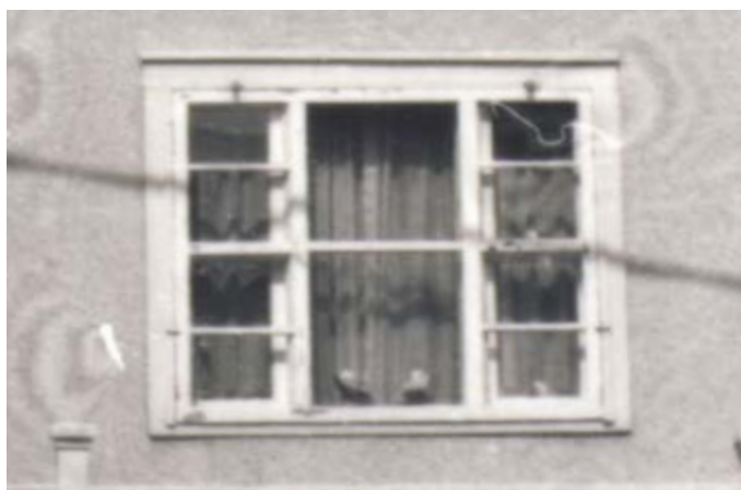
122. Fenêtre panoramique en triplet. 37, rue Hélène-Duval.
