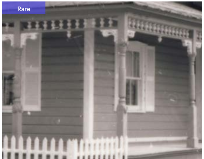
148. Aisseliers aux coins des colonnes et lambrequins sous la toiture de la galerie. 174, rue Leduc.
