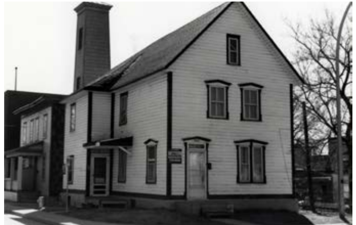
202. Composition symétrique, les baies de l'étage sont rapprochées et la baie est élargie au rez-de-chaussée. 218, rue Notre-Dame-de-l'Île.
