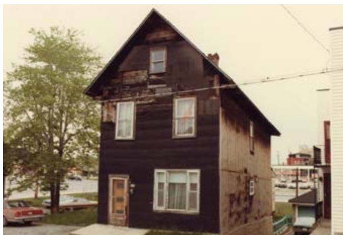
196. Parement en papier kraft. 108, rue Dollard-des-Ormeaux.
