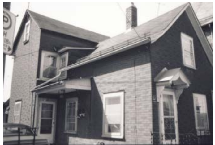
75. Maison avec un corps secondaire de deux niveaux et demi, décalé et au toit à deux versants. 65, rue Kent.
