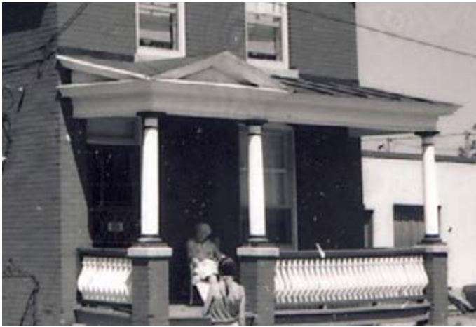
340. Galerie à fronton sur la façade avant. 251, rue Champlain.
