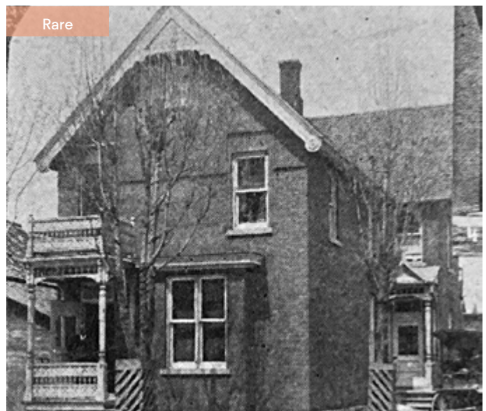
349. Plusieurs saillies sont présentes : un balcon au-dessus de la porte principale et un oriel (à droite). 69, rue Vaudreuil.
