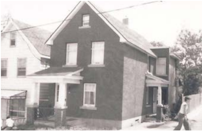
290. Maison avec un corps secondaire de deux niveaux décalé, au toit en appentis. 56, rue Dollard-des-Ormeaux.
