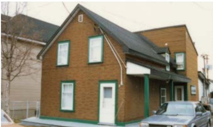
104. Composition asymétrique, avec deux ouvertures éloignées et centrées à l'étage. La porte est décentrée au rez-de-chaussée. 8, rue Saint-Florent.
