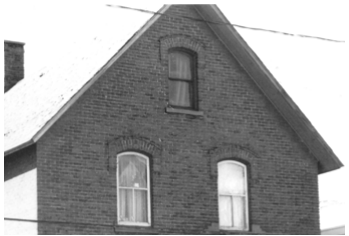
329. Fenêtre rectangulaire à arc surbaissé. 163, rue Notre-Dame-de-L'Île.
