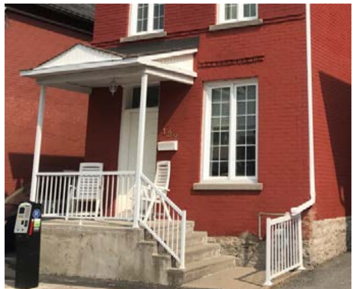
411. Auvent ancien, avec des colonnes non traditionnelles. 129, rue Wellington.
