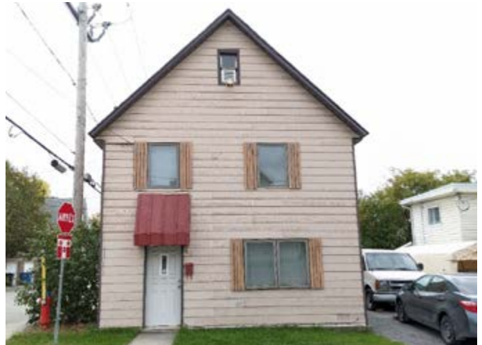
406. Baie élargie au rez-de-chaussée, baies raccourcies aux étages et menuiseries contemporaines en aluminium. 42, rue Garneau.
