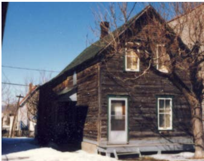
89. Parement en planches de bois horizontales non-traitées. 317, rue Champlain.
