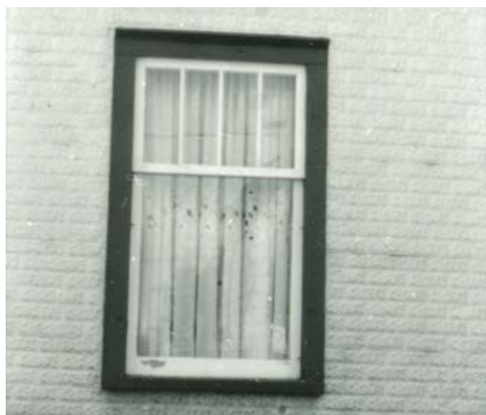
223. Fenêtre à carreaux en partie supérieure. 20, rue des Braves-du-Coin.
