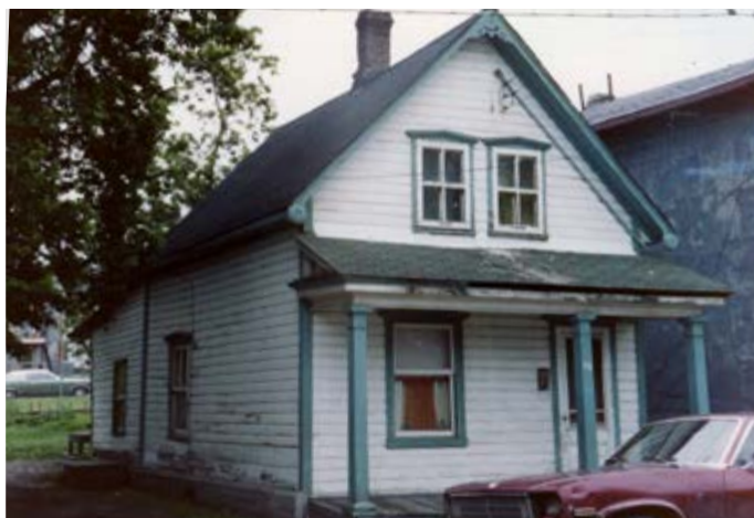
63. Maison avec un corps secondaire d'un niveau, aligné et au toit en appentis. 72, rue Dollard-des-Ormeaux.
