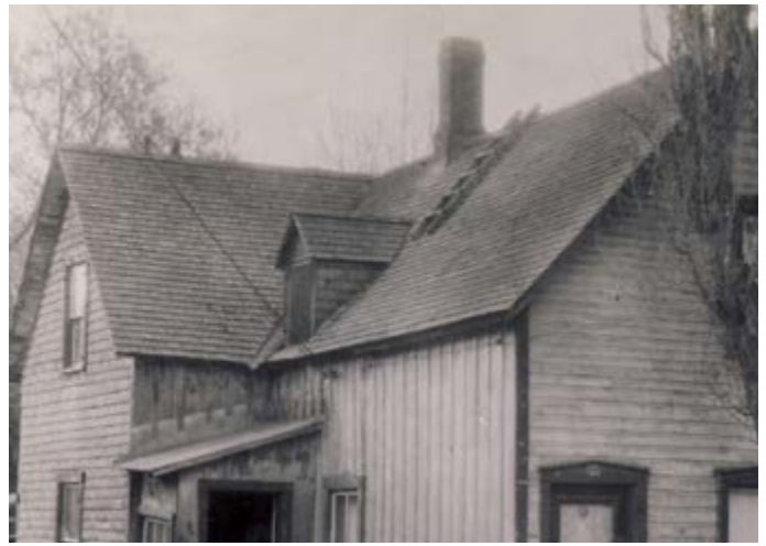
84. Toit en bardeaux de bois. Emplacement inconnu.
