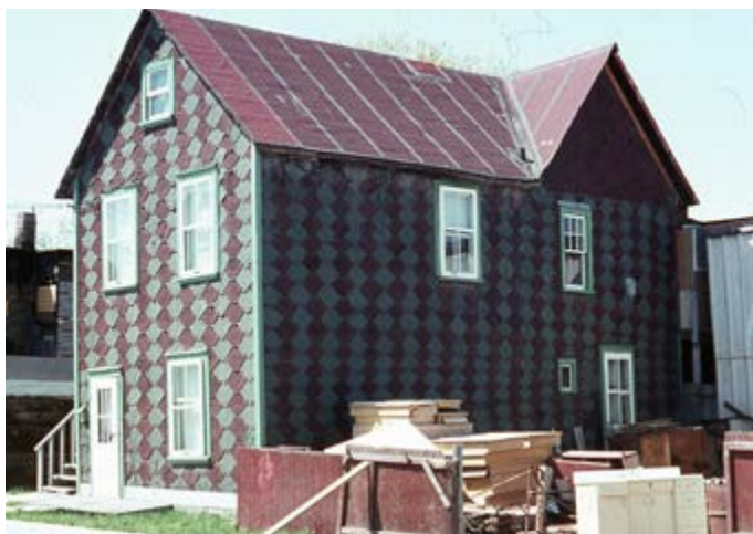
390. Revêtement coloré en papier brique. Emplacement inconnu.
