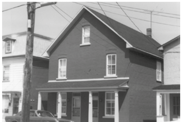
299. Toiture à pente faible. 92, rue Saint-Jacques.
