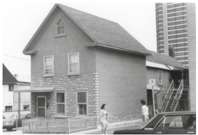
159. Maison de 2,5 étages, corps secondaire de deux niveaux, en retrait et au toit à mur pignon. 76, rue Laval.
