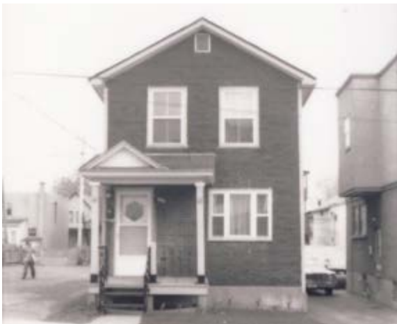
175. Toiture à pente faible. 185, rue Dollard-des-Ormeaux.
