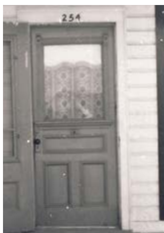
213. Contre-porte et porte en bois, à panneaux et fenestrée. 254, rue Champlain.
