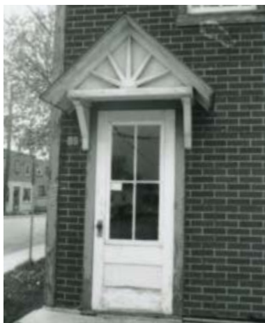
244. Auvent à fronton au motif rayonnant, sans colonnes. 89, rue Dollard-des-Ormeaux.
