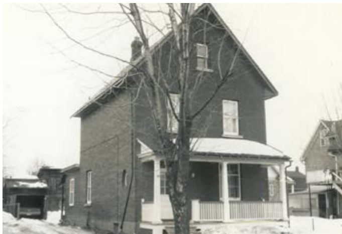
357. Cheminée en brique à l'arrière de la maison. 19, rue Connaught.
