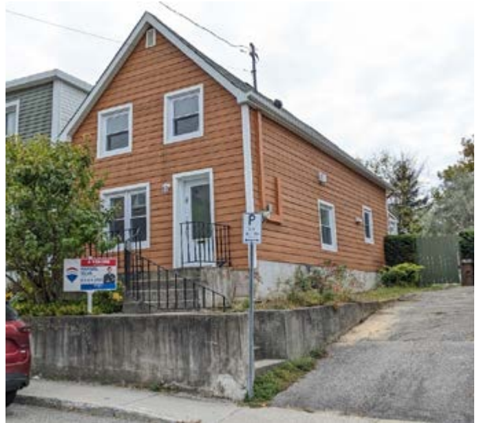
449. Maison allumette en bois restaurée avec un parement de type Maibec. 20, rue Garneau.
