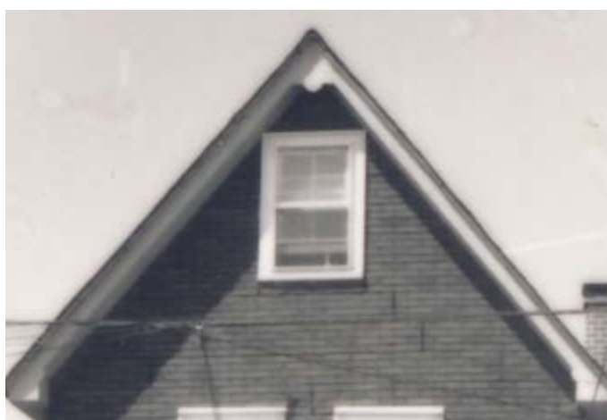
233. Fenêtre rectangulaire à carreaux. 179, rue Dollard-des-Ormeaux.
