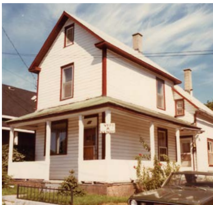
272. Chambranles et planches de coin peintes d'une couleur contrastante. 298, boulevard des Allumettières.
