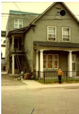
388. Corps secondaire rehaussé d'un étage. 121, rue Saint-Henri
