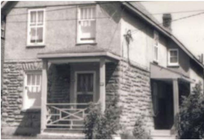
246. Perron et auvent en appentis sur les façades avant et latérale. 3, rue des Braves-du-Coin.
