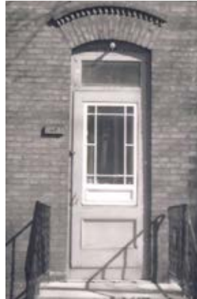
319. Contre-porte en bois fenestrée et à panneaux. L'ouverture est surmontée d'une imposte et d'un arc surbaissé ouvragé. 154, rue Champlain.
