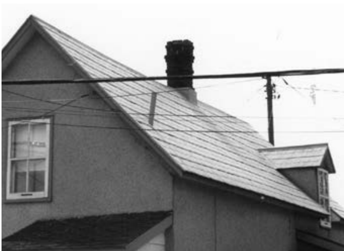
85. Toit en tôle embossée. 43, rue Carillon.
