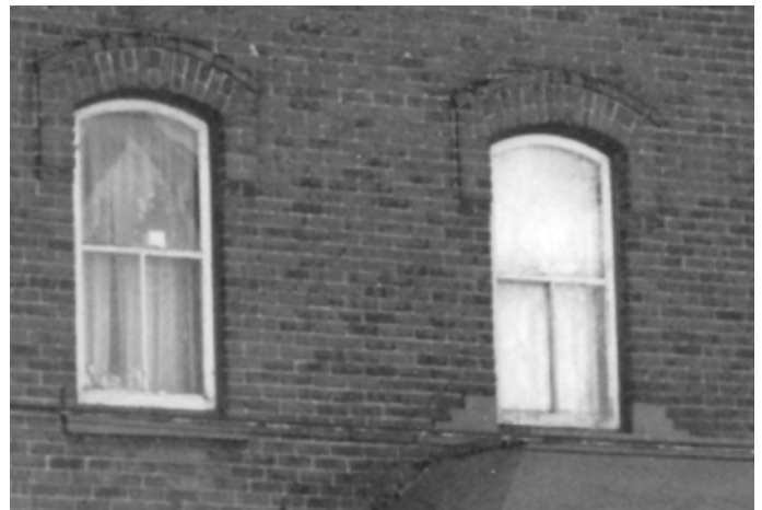
366. Plate-bande en arc surbaissé et appareillage de brique. 163, rue Notre-Dame-de-l'Île.
