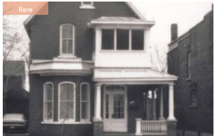
347. Plusieurs saillies sont présentes : une galerie latérale, une logette au-dessus de la porte principale et un oriel (à gauche). 156, rue Notre-Dame-de-l'Île.
