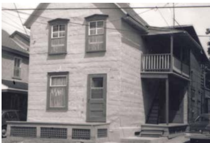
191. Parement en tôle embossée. 109, rue Garneau.
