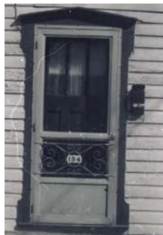
270. Chambranle ouvragé à arc en mitre autour d'une porte. 184, rue Champlain.
