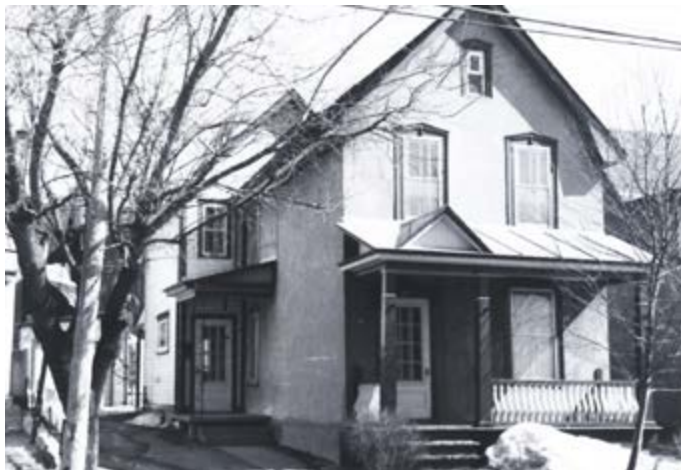
160. Maison de 2,5 étages, corps secondaire de 2 niveaux, décalé et au toit à mur pignon. 308, rue Champlain.
