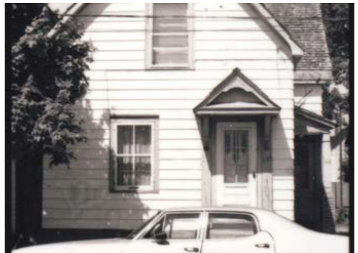
124. Perron et auvent à fronton, sans colonnes, sur la façade avant. 175, rue Kent.
