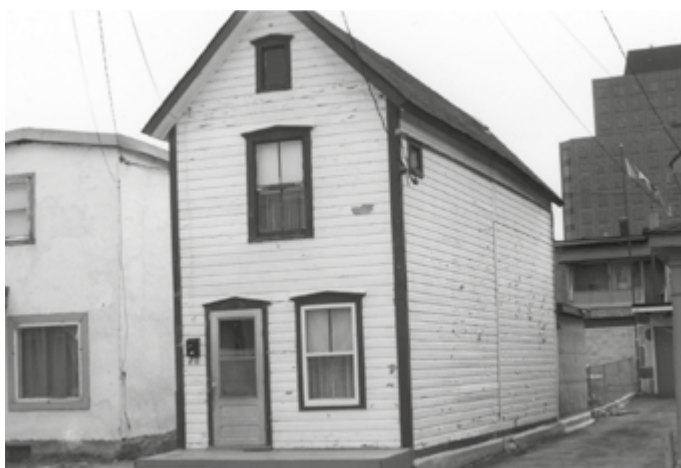
187. Parement en planches à feuillure ou à gorge. 14, rue Vaudreuil.
