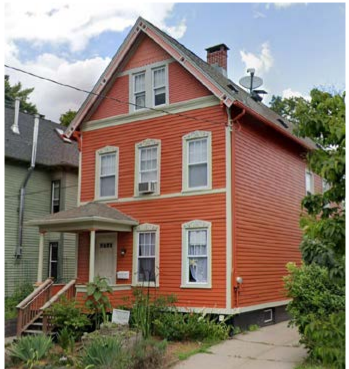
433. Maison de deux étages et demi en bois, ornementée. 43, rue Avon.
