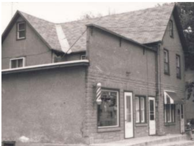
383. Maison allumette de deux étages et demi en bois, à laquelle s'est ajoutée une annexe commerciale. 193-195, rue Laval.
