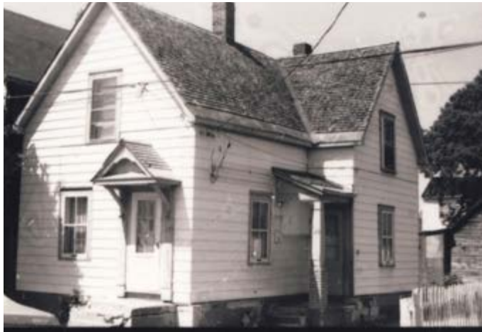
72. Maison au plan en L, avec un corps secondaire d'un niveau et demi, décalé et au toit à deux versants. 175, rue Kent.
