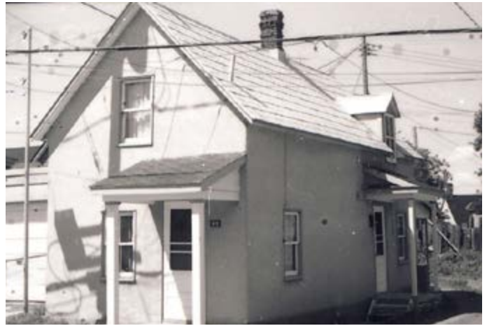
131. Cheminée en brique au centre de la maison. 45, rue Carillon.
