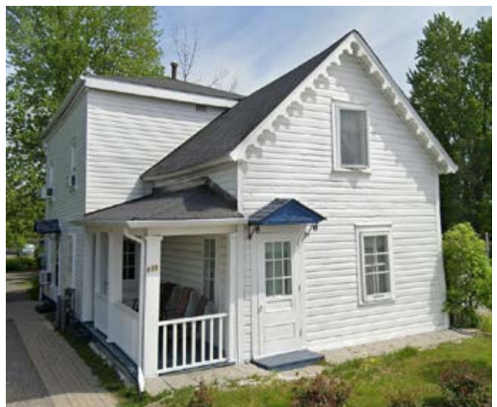
425. Maison de bois avec ornements au niveau du pignon. 839, rue Jacques-Cartier (secteur Gatineau).
