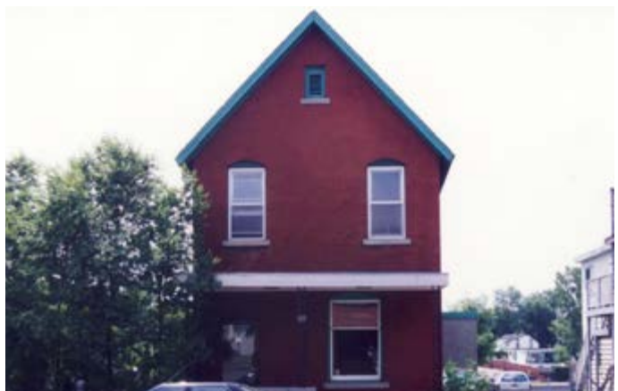
312. Composition symétrique, les ouvertures de l'étages sont éloignées. 99, rue Montcalm.
