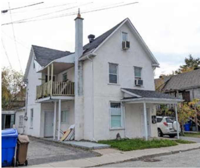
408. Cheminée non traditionnelle en béton, et balcon non traditionnel sur la façade latérale. 62, rue Charlevoix.
