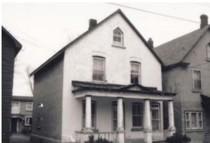
294. Maison de deux logements sans corps secondaire. 73, rue de l'Hôtel-de-ville.
