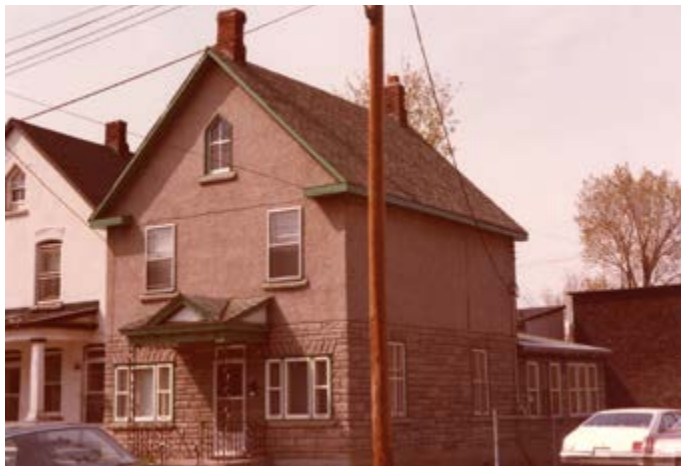
259. Cheminée sur les pignons avant et arrière. 75, rue de l'Hôtel-de-Ville.
