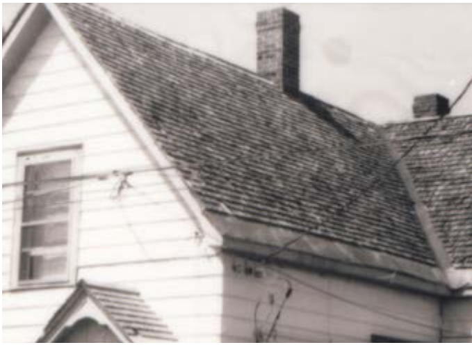
83. Toit en bardeaux de bois. 175, rue Kent.
