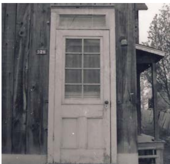
216. Contre-porte à panneaux, fenestrée et avec imposte. 328, rue Champlain.
