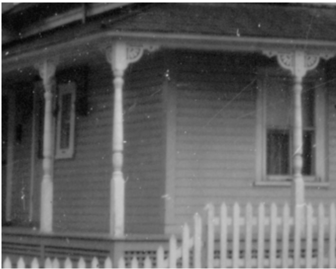
147. Aisseliers entre les colonnes et la toiture de la galerie. 114, rue Saint-Jacques.
