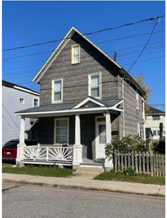
393. Revêtement ancien non traditionnel en papier brique. 57, rue Falardeau.
