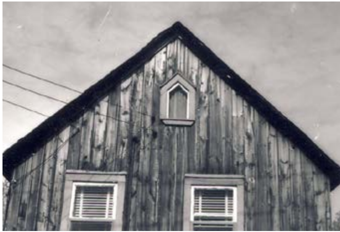
236. Fenêtre surmontée d'un arc en mitre. 73, rue Dollard-des-Ormeaux.
