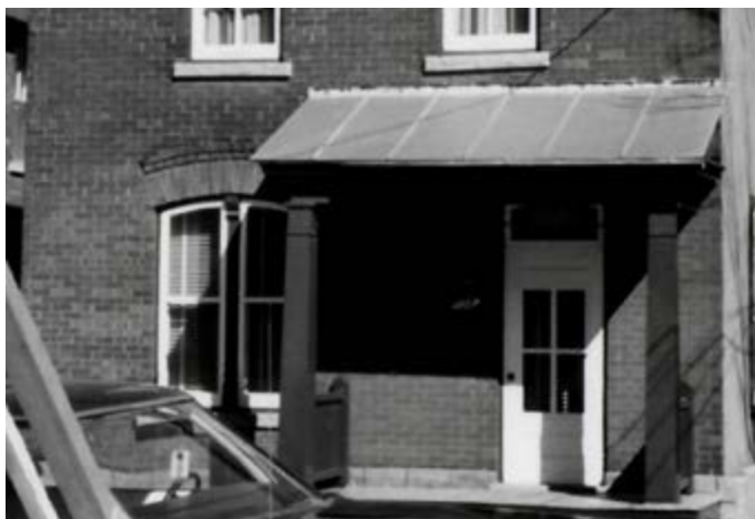
336. Perron en bois et auvent sur la façade avant. 138, rue Notre-Dame-de-l'Île.
