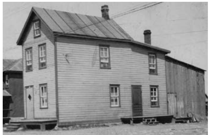
157. Maison de 2,5 étages, corps secondaire de 2 niveaux, aligné et au toit en appentis. Emplacement inconnu.
