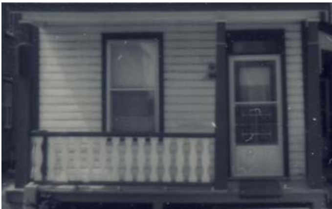
277. Garde-corps en bois scié. 127, rue Dollard-des-Ormeaux.
