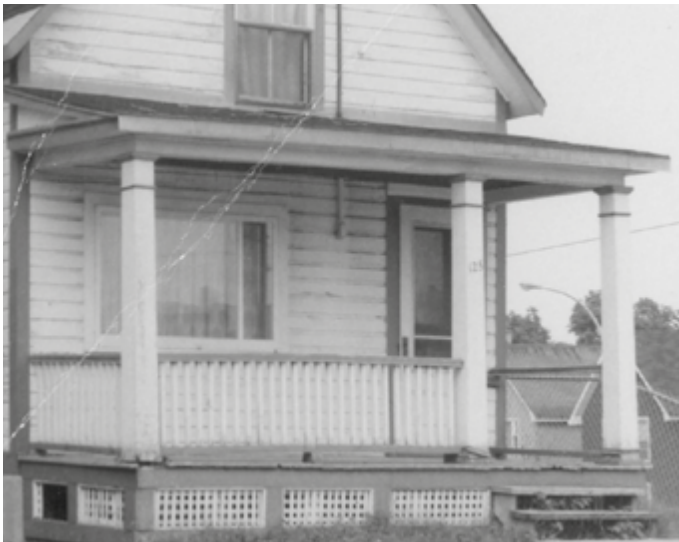
145. Garde-corps à barreaux droits. 82, rue Frontenac.
