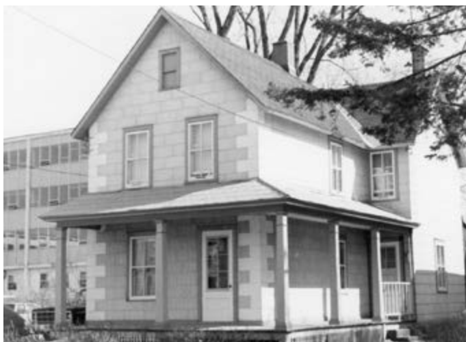
392. Revêtement en tuiles d'amiante. 274, rue Notre-Dame-de-l'Île.
