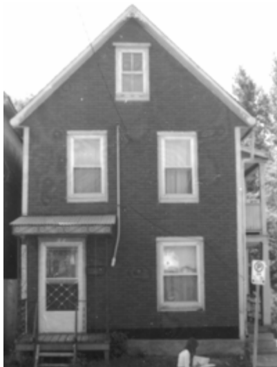
197. Composition symétrique, les fenêtres sont alignées et la porte est décentrée. 18, rue des Braves-du-Coin.
