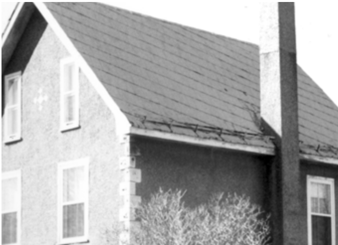
181. Toit de tôle en plaque, à la canadienne. 245, rue Papineau.
