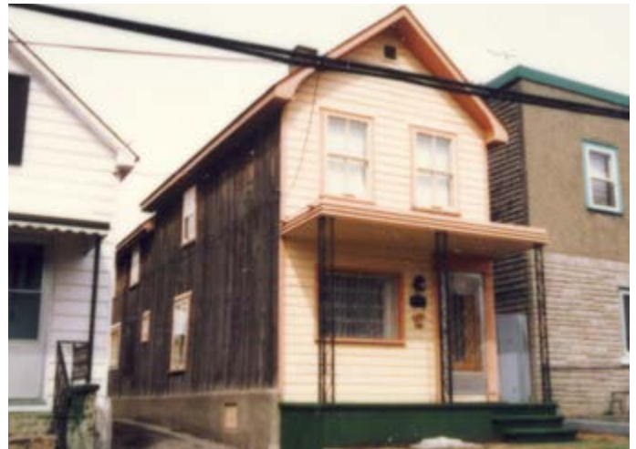
184. Combinaison de plusieurs parements : planches à feuillure ou à gorge et planches à couvre-joint. 19, rue Pilon.
