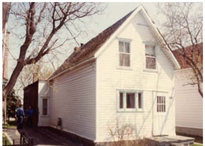
80. Toiture à pente forte. 150, rue Kent.
