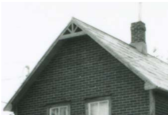
283. Gâble simple et ornement à l'endroit de la corniche. 89, rue Dollard-des-Ormeaux.
