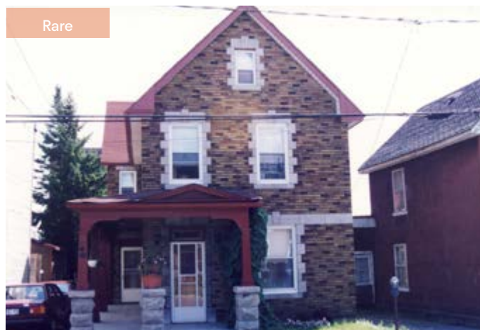
307. Parement en brique brune. 40, rue Wright.
