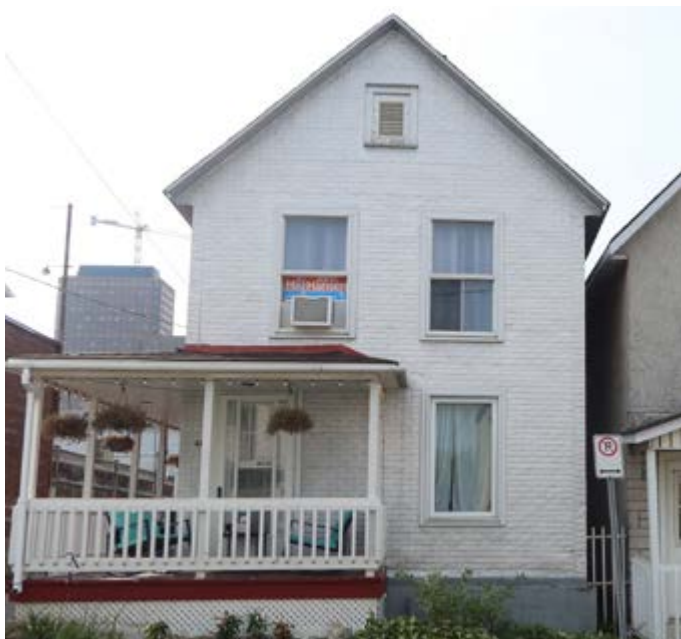
400. Revêtement ancien et préservé en tôle embossée. 20, rue des Braves-du-Coin.
