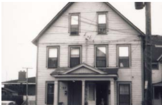
208. Composition symétrique, avec quatre baies à l'étage et deux sur le pignon. 57-59, rue Saint-Etienne.
