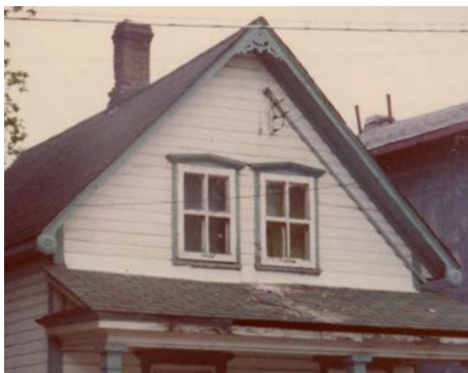
151. Gâble ouvragé et ornement à l'endroit de la corniche. 72, rue Dollard-de-Ormeaux.
