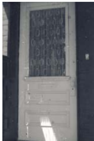
321. Porte en bois fenestrée et à panneaux. 169, rue Champlain.
