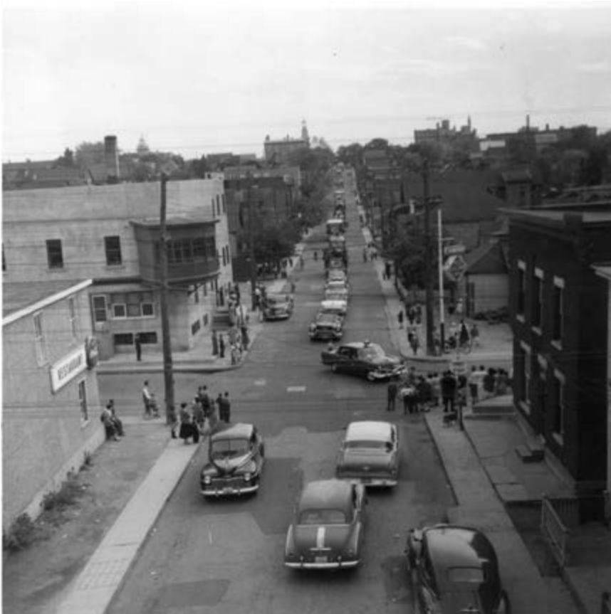
15. Photographie du boulevard Maisonneuve avant son élargissement.
