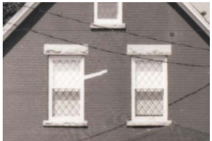
368. Linteaux bosselés en béton. 157, rue Laurier.
