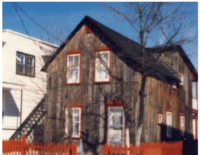
90. Parement en planches verticales brutes. 27, rue Mance.
