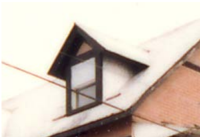
361. Lucarne à fronton. 123, rue Wellington.
