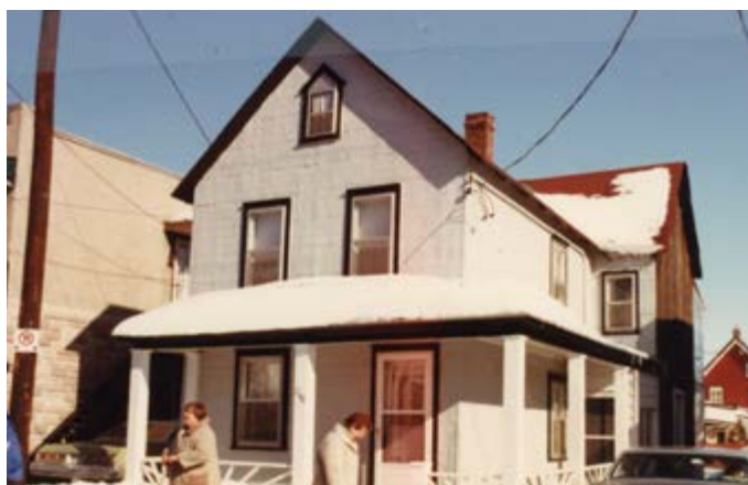
192. Parement en tôle embossée et en planches de bois verticales non traitées à l'arrière. 240, rue Notre-Dame-de-l'Île.
