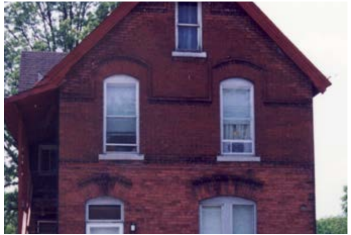
370. Frises en briques. 121, rue Montcalm.
