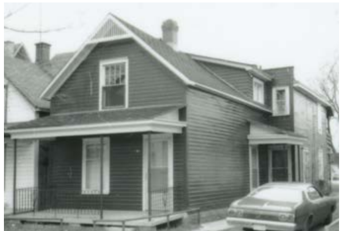
69. Maison avec un corps secondaire de deux niveaux, décalé et au toit plat. 61, rue Vaudreuil.
