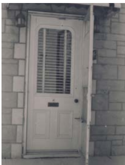
214. Porte en bois, fenestrée et à panneaux. 64, rue Frontenac.
