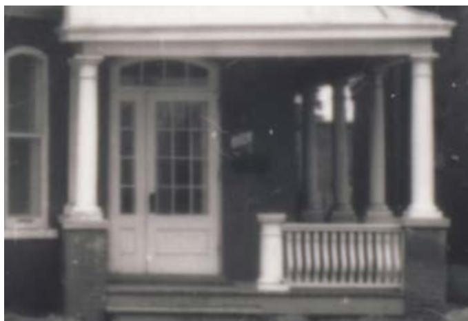
374. Garde-corps en barreaux en bois scié. 156, rue Notre-Dame-de-L'Île.
