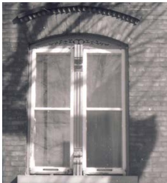
326. Fenêtre jumelée avec un piédroit ornementé, surmontée d'un arc surbaissé et d'une plate-bande ouvragé 154, rue Champlain.
