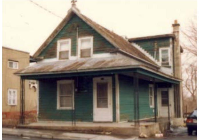
128. Galerie couverte sur les façades avant et latérale (les colonnes en fer ne sont pas d'origine). 83, rue Frontenac.
