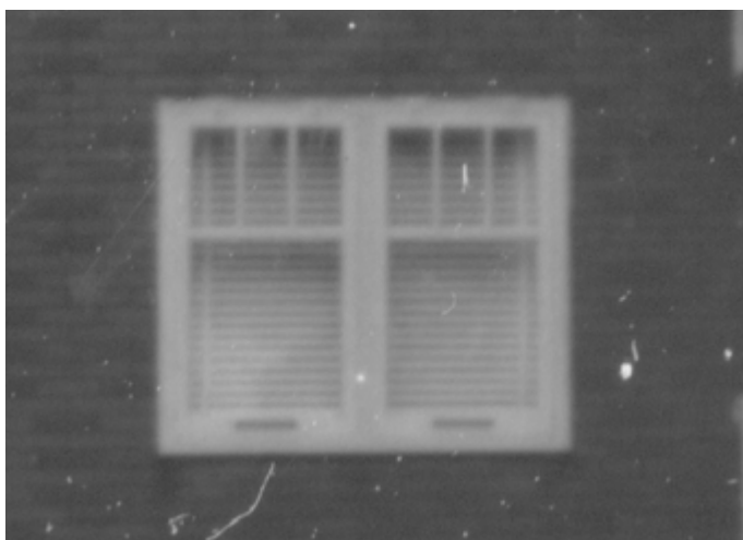
119. Fenêtre jumelée à meneaux en partie supérieure. 232, rue Notre-Dame-de-l'Île.
