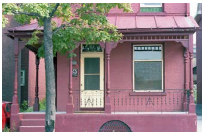
376. Aisseliers aux coin des colonnes et lambrequins sous la toiture de la galerie. 125, rue Wellington.
