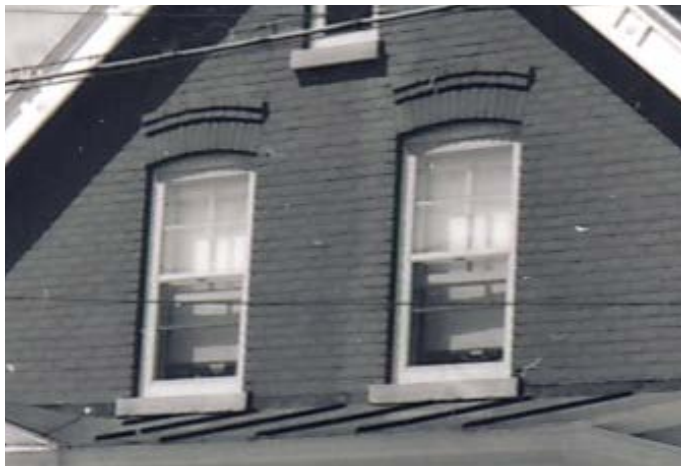
365. Plate-bande en arc surbaissé et appareillage de brique. 251, rue Champlain.
