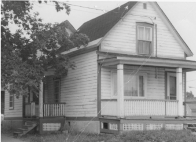
127. Galerie couverte sur la façade avant, perron et auvent à l'entrée secondaire. 125, rue Saint-Etienne.
