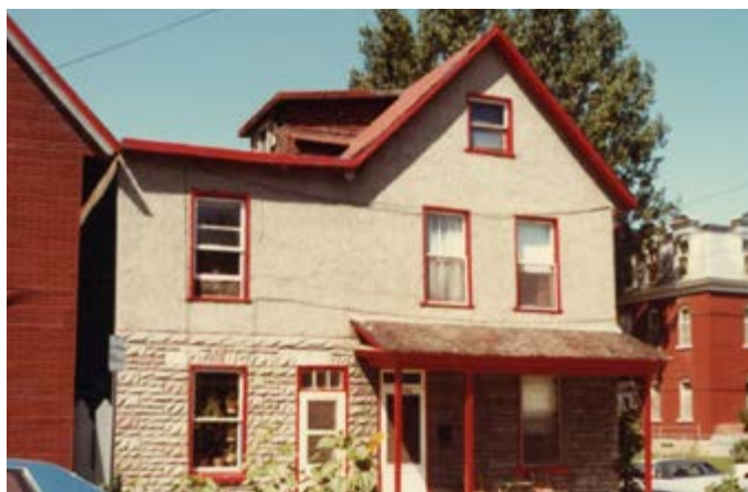
169. Maison de 2,5 étages, annexe au toit plat, ajoutant un logement. 199, rue Saint-Rédempteur.
