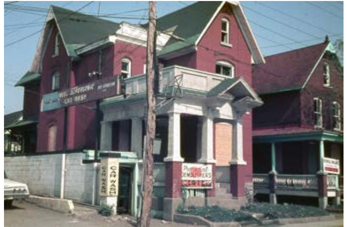
16. Maisons démolies lors de l'aménagement du boulevard Maisonneuve.
