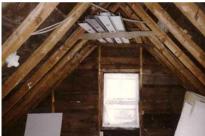
46 Intérieur de combles non aménagés. 71, rue Kent.
