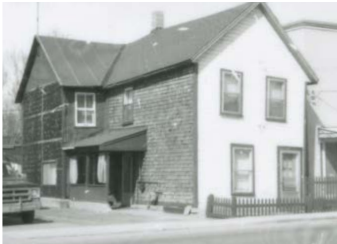
183. Combinaison de plusieurs parements : planches à feuillure ou à gorge, bardeaux de bois et papier kraft. 149, rue Papineau.
