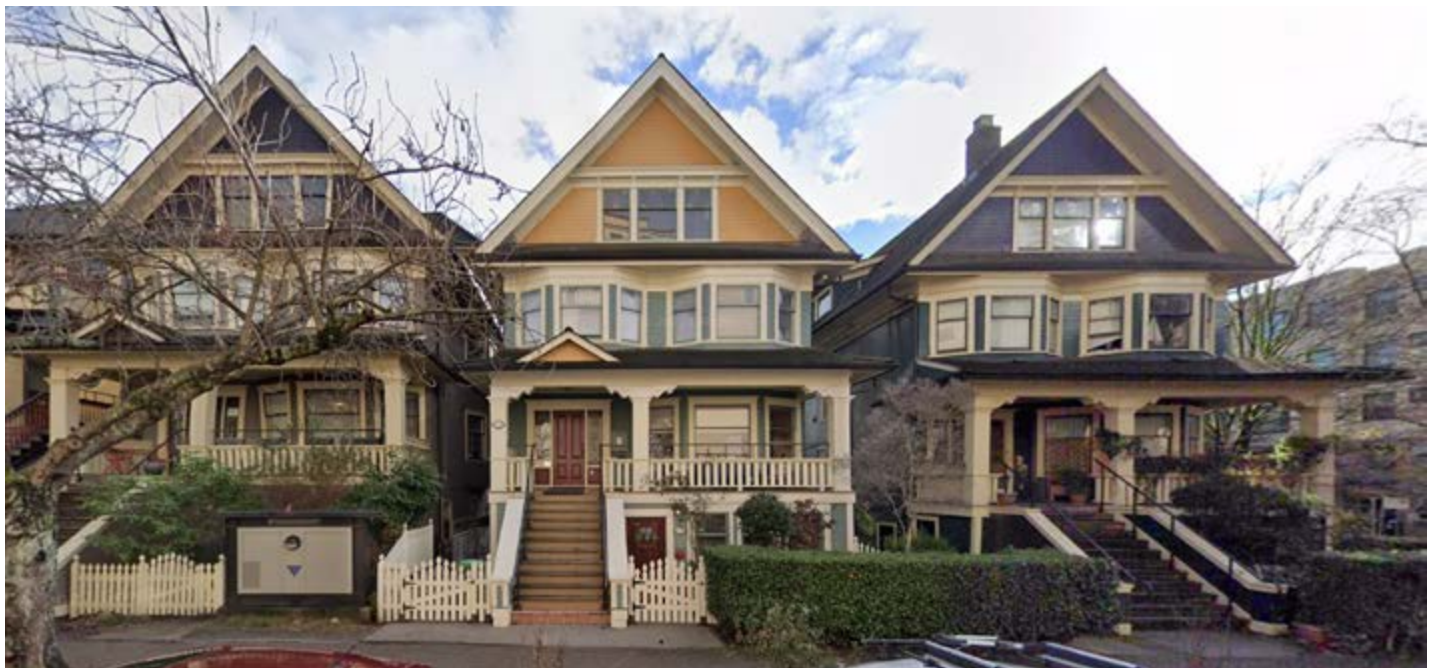
430. Alignement de maisons de deux étages et demi très ornementées en bois, avec plusieurs saillies. 1110 à 1122, rue Bute.
