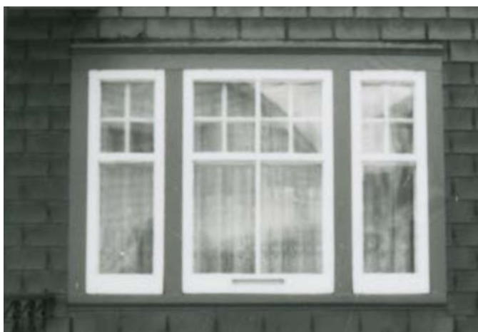
229. Fenêtre en triplet à carreaux. 92, rue Charlevoix.
