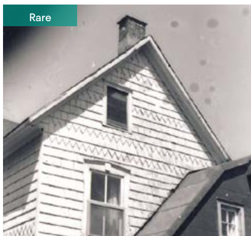
190. Parement en bardeaux de bois taillés en motifs (façade arrière). 254, rue Champlain.
