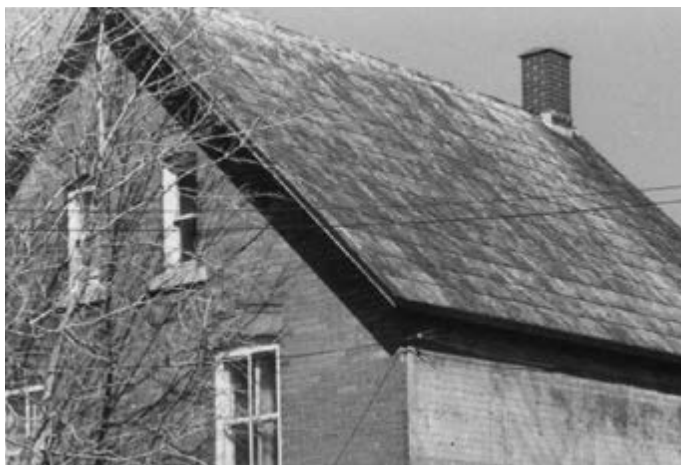
304. Toit en tôle embossée. 192, rue Champlain.
