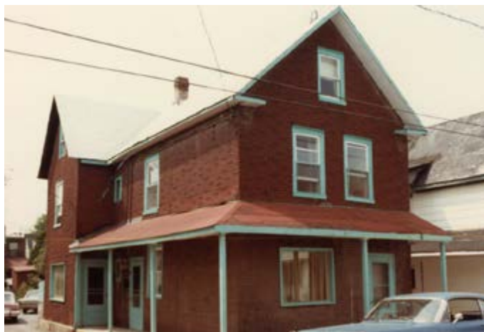
194. Parement en papier brique 39, rue Saint-Hyacinthe.
