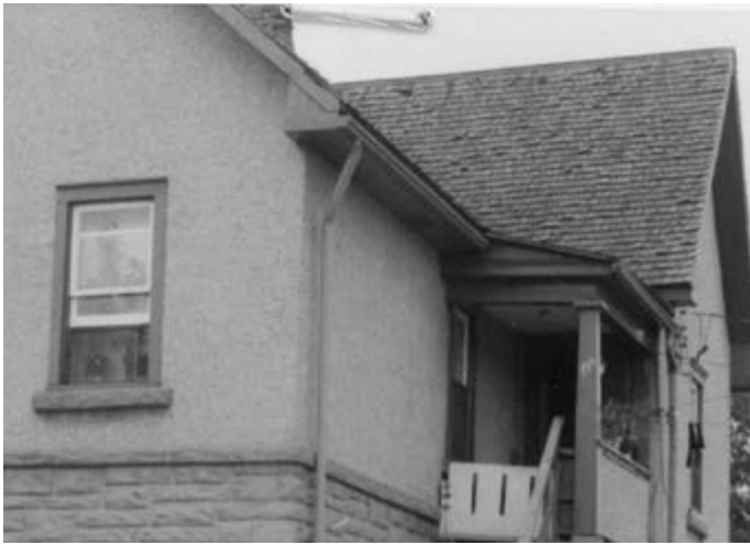
179. Toiture en bardeaux de bois. 29, rue Verdun.
