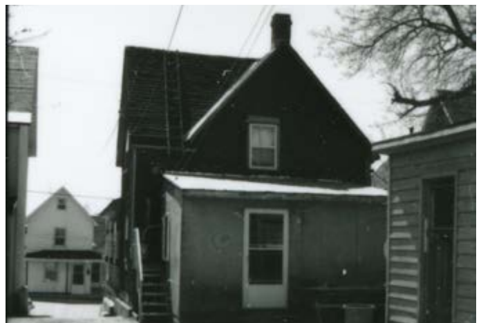
133. Cheminée dans le pignon de la façade arrière. 29, rue Papineau.
