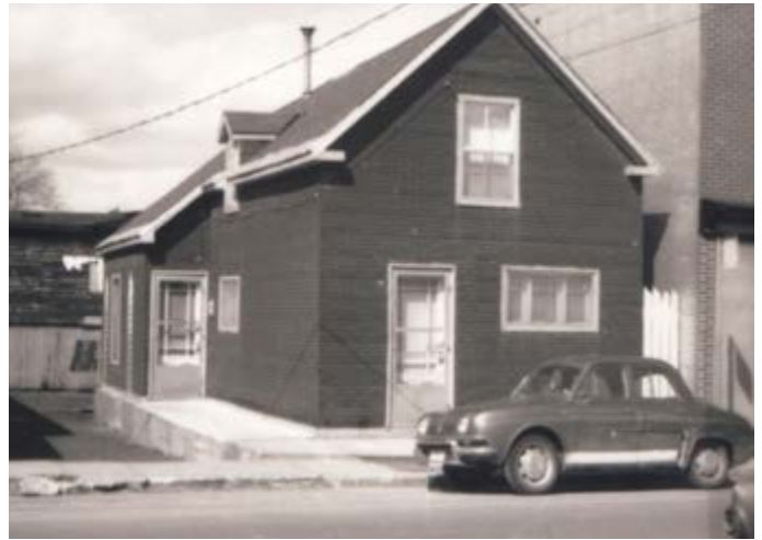
78. Pente de toit typique. 71, rue Frontenac.
