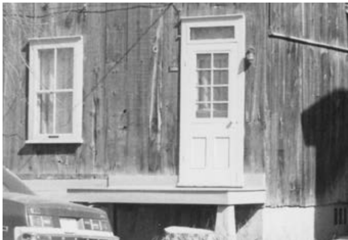
242. Perron en bois sur la façade avant. 328, rue Champlain.
