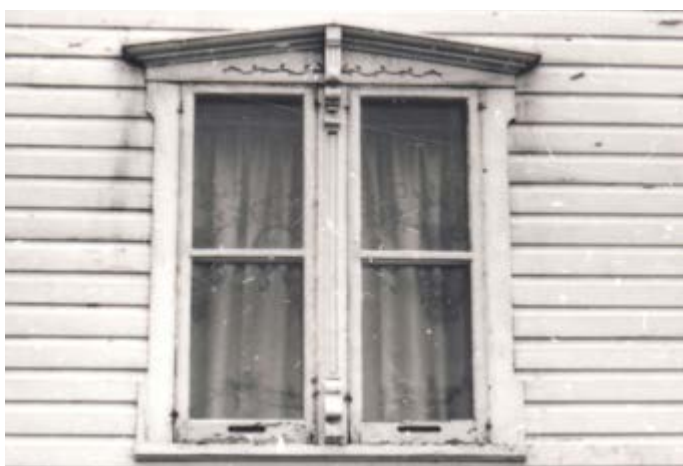
226. Fenêtre jumelée avec un piédroit ouvragé. 218, boulevard Maisonneuve.
