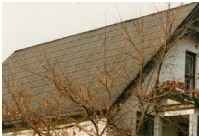
305. Toit en tôle embossée. Rue Notre-Dame-de-l'Île.
