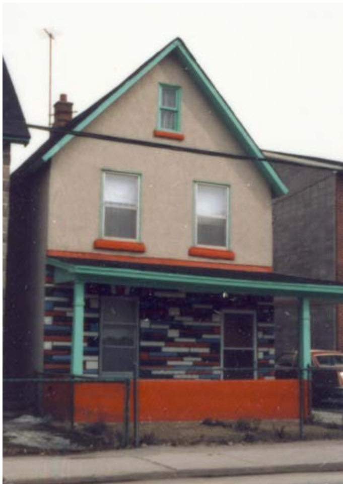
395. Revêtement d'agrégats et imitant la pierre au rez-de-chaussée. 212, rue Saint-Rédempteur.
