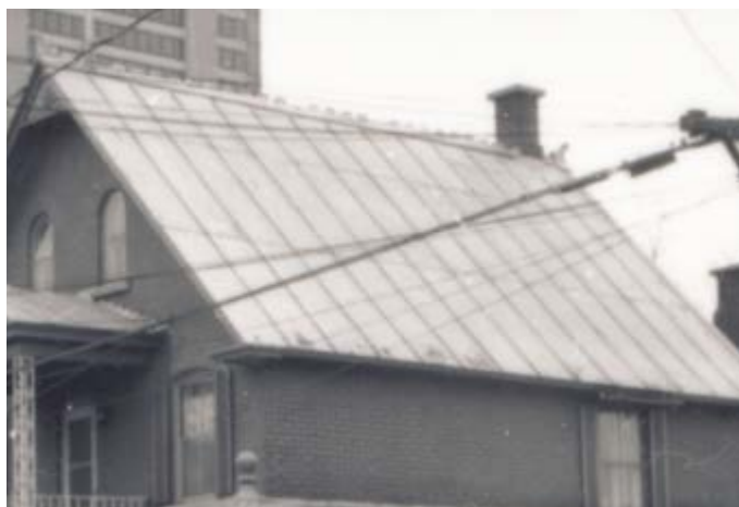
303. Toit en en tôle pincée. 133, rue Notre-Dame-de-l'Île.
