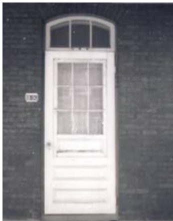
320. Contre-porte en bois fenestrée et à panneaux. L'ouverture est surmontée d'une imposte. 151-153, rue Champlain.
