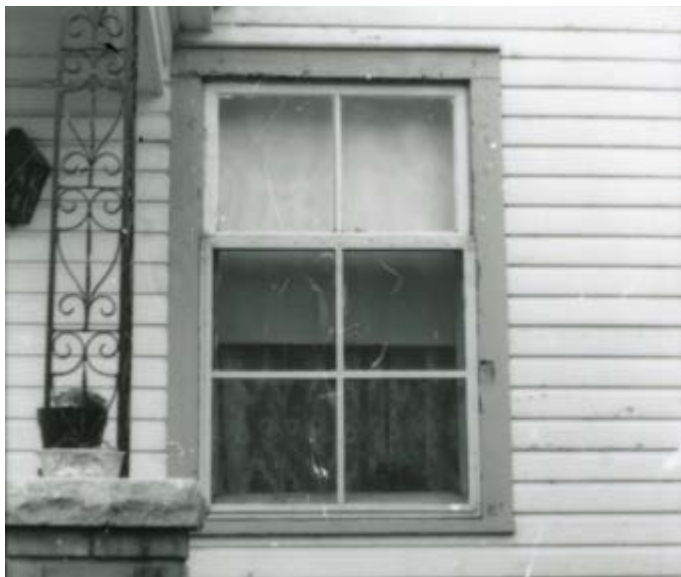
220. Fenêtre à guillotine à 6 carreaux. 85, rue Saint-Henri.
