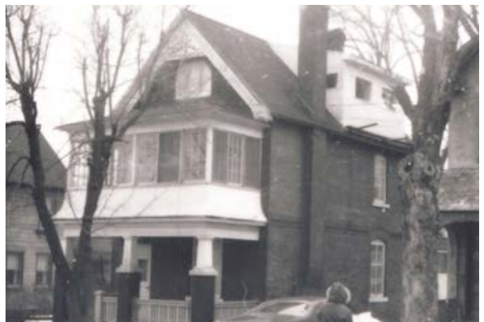
360. Cheminée en brique hors-murs. 28, rue Hanson.
