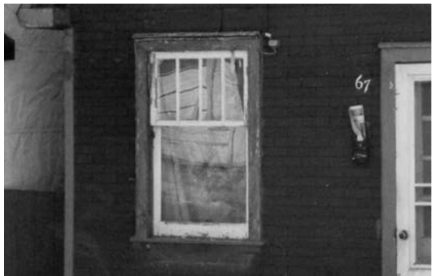
116. Fenêtre à guillotine avec des meneaux en partie supérieure. 67, rue Morin.
