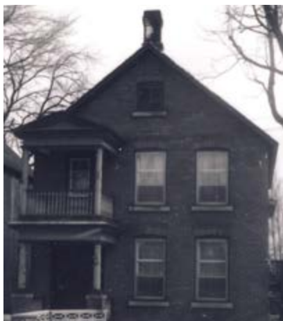
359. Cheminée décorative en brique sur le pignon. 24, rue Hanson.
