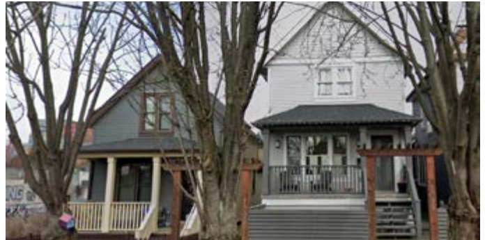
428. Maison d'un étage et demi en bois. 1020, rue Keefer.
