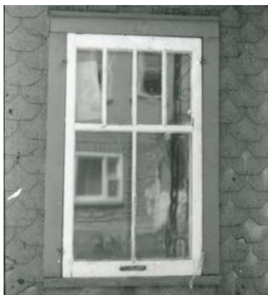
222. Contre-fenêtre à carreaux. 10, rue Garneau.
