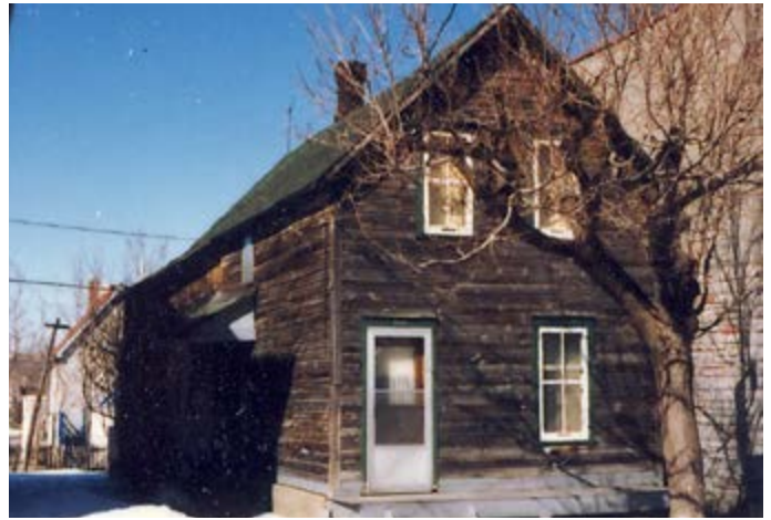
103. Composition symétrique, avec deux ouvertures centrées à l'étage. La porte est décentrée au rez-de-chaussée. 317, rue Champlain.
