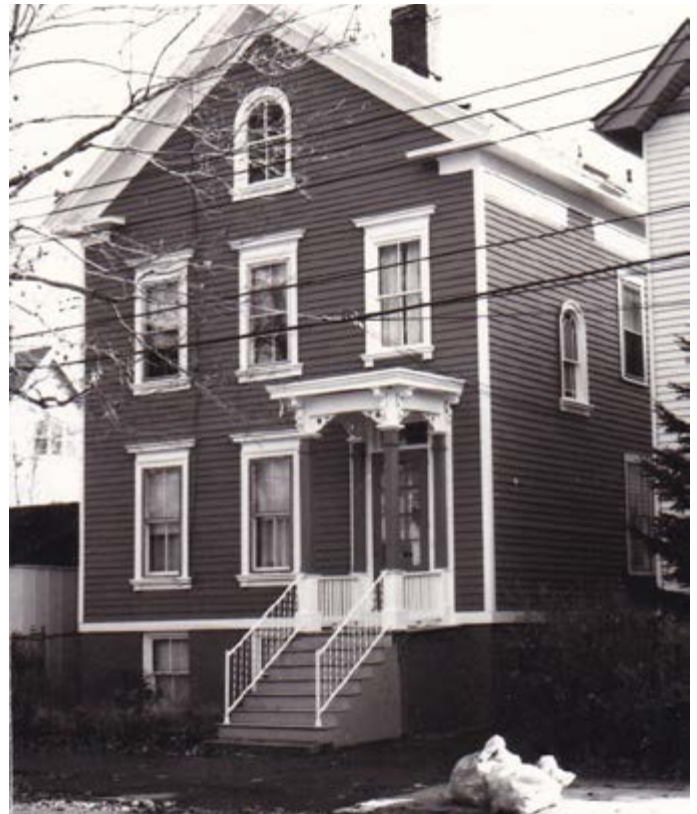
432. Maison de deux étages et demi en bois, ornementée. 21, rue Anderson.
