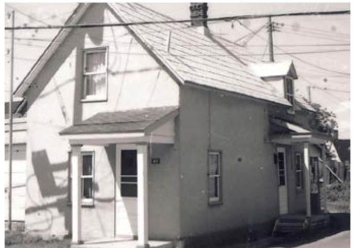
126. Perrons et auvents en appentis sur les deux entrées. 45, rue Carillon.
