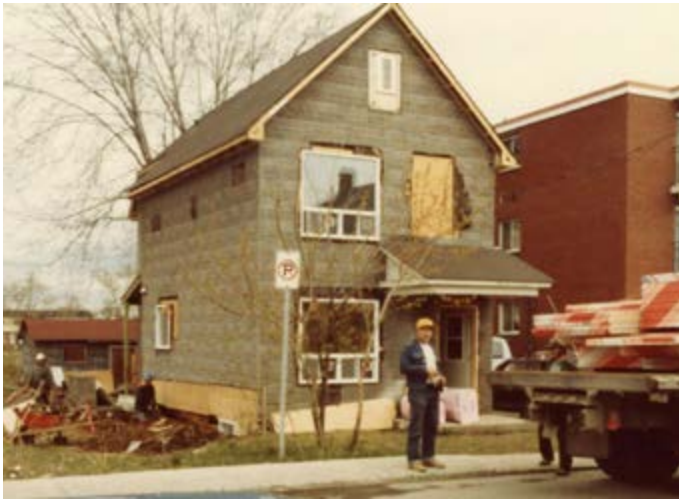
405. Travaux d'agrandissement des ouvertures en cours. 72, rue Saint-Henri.
