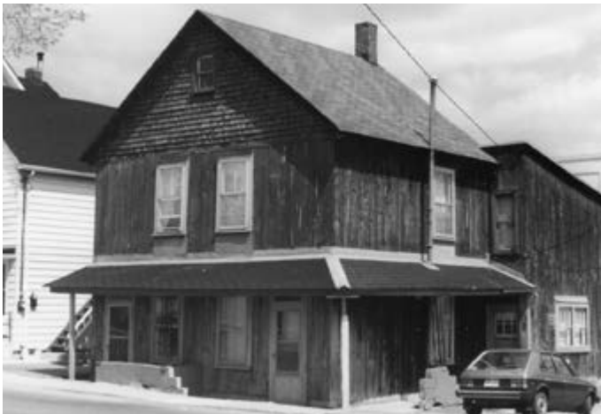
172. Maison de deux logements, corps secondaire de deux niveaux, décalé et au toit en appentis. 128, rue Saint-Rédempteur.
