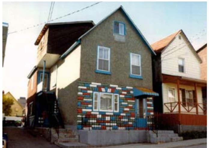
396. Revêtement d'agrégats et imitant la pierre au rez-de-chaussée. 86, rue Charlevoix.
