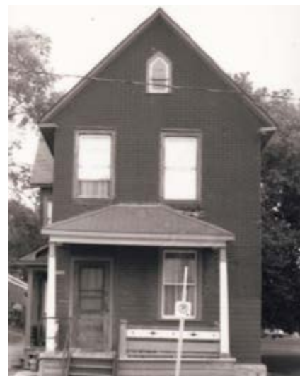
200. Composition asymétrique, les ouvertures de l'étage et du rez-de-chaussée sont alignées. 227, rue Saint-Rédempteur.
