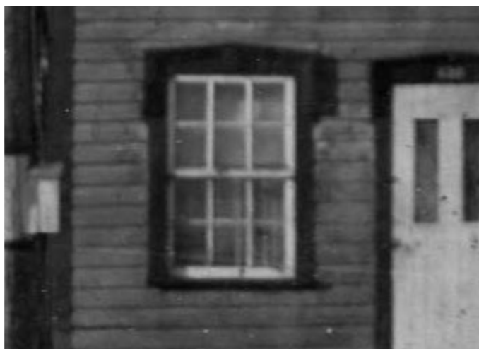
118. Fenêtre à guillotine à 12 carreaux. 128-130, rue Saint-Laurent.
