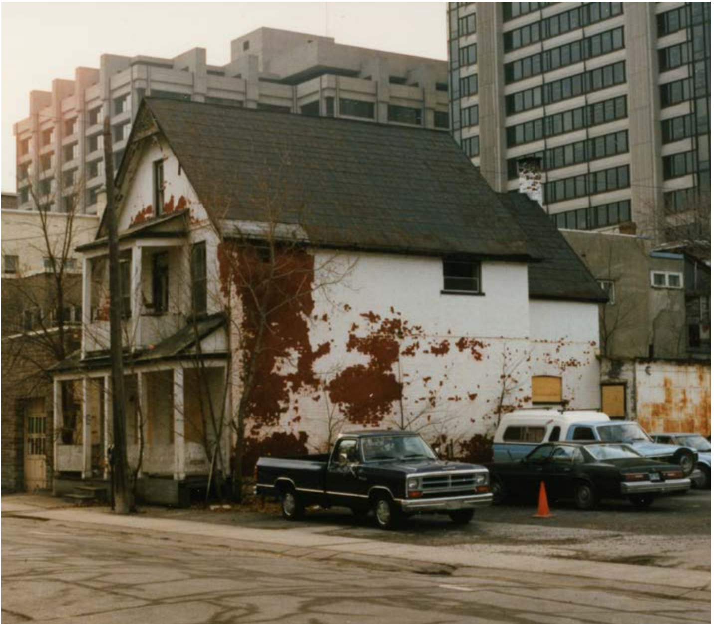
17. Maison abandonnée sur la rue Notre-Dame-de-l'Île, démolie dans les années 1990 et remplacée par un stationnement.
