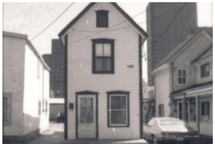
204. Composition symétrique, avec une seule baie à l'étage. 14, rue Vaudreuil.
