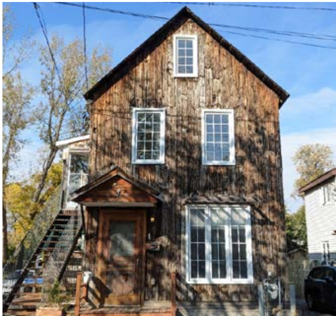
398. Revêtement ancien et préservé en planches de bois verticales. 1, rue Garneau.
