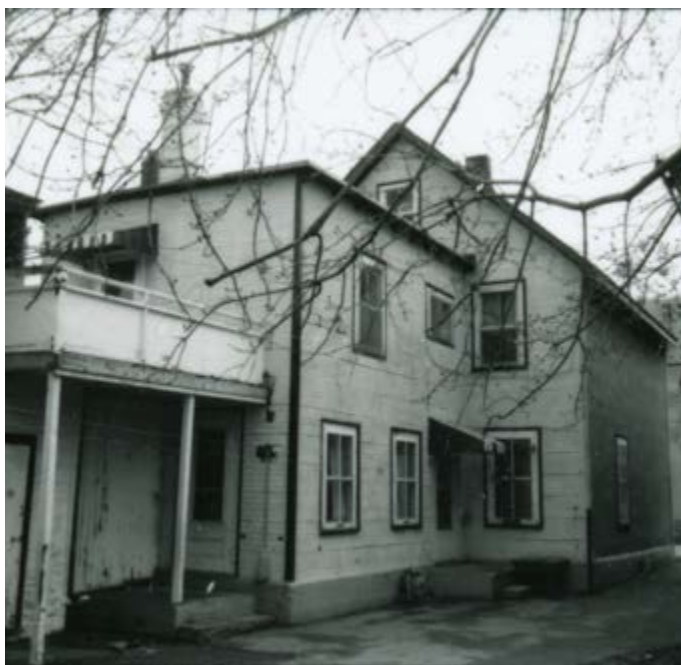
48. Maison de deux étages et demi en bois avec un corps secondaire, vu de la cour arrière. 73, rue de l'Hôtel-de-ville.
