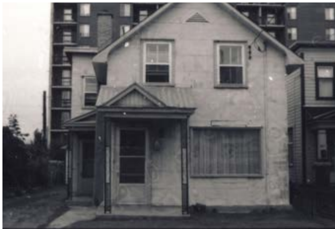
125. Perron et auvent à fronton sur la façade avant (les colonnes en fer ne sont pas d'origine). 88, rue Saint-Henri.
