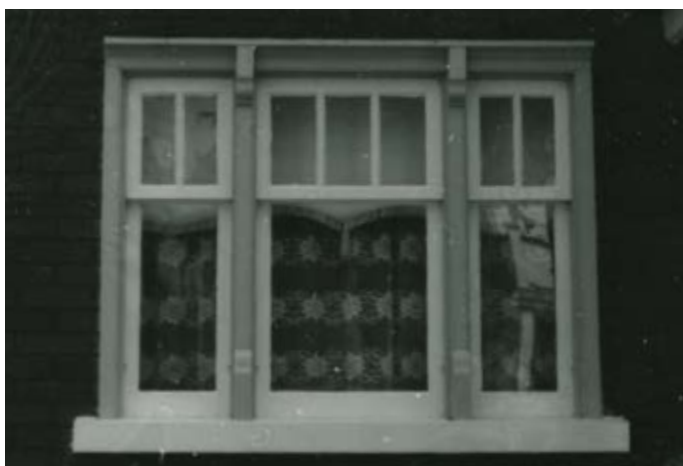
228. Fenêtre en triplet à carreaux, avec des piédroits ouvragés. 54, rue Sainte-Hyacinthe.
