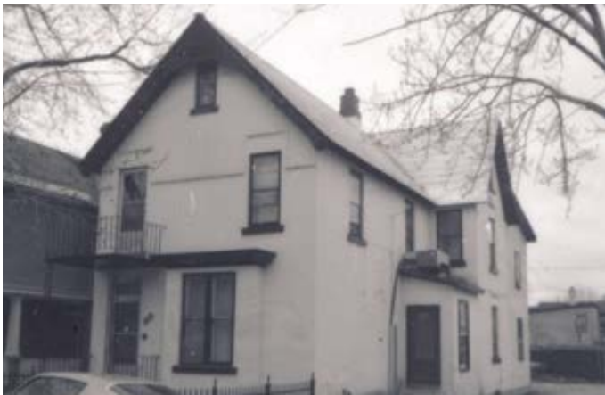
292. Maison au plan en L avec un corps secondaire de deux niveaux, aligné et au toit en appentis. 69, rue Vaudreuil.
