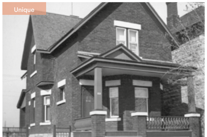
301. Toiture atypique. 73, rue Boucherville.
