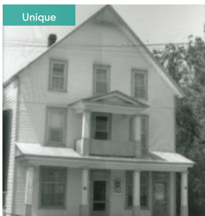
211. Volume symétrique, avec trois ouvertures à l'étage et sur le pignon. 161, rue Laurier.
