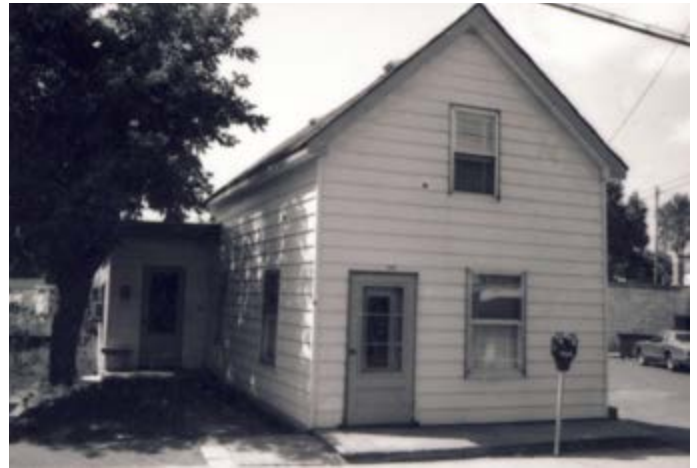
99. Composition asymétrique, avec une ouverture centrée à l'étage. La porte est décentrée au rez-de-chaussée. 149, rue Eddy.
