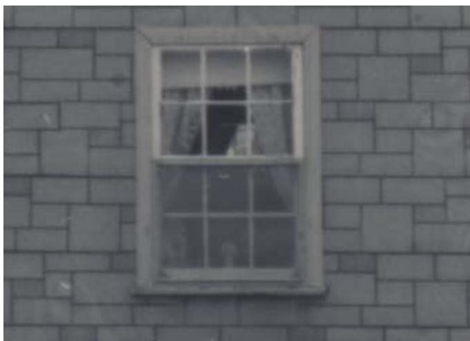
117. Fenêtre à guillotine à 12 carreaux. 43, rue Saint-Henri.
