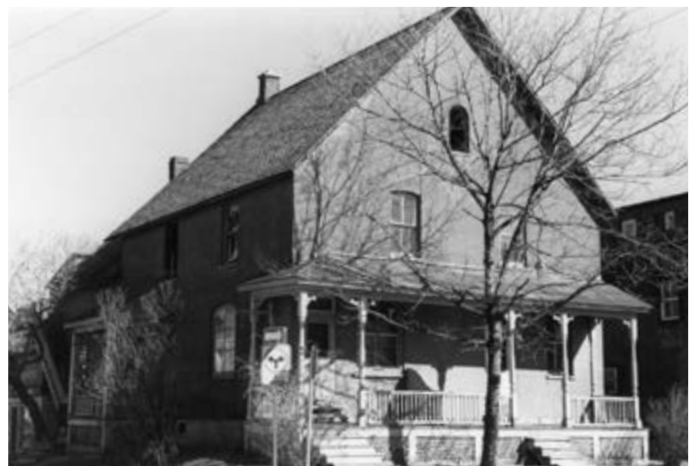
358. Deux cheminée en brique. Emplacement inconnu.
