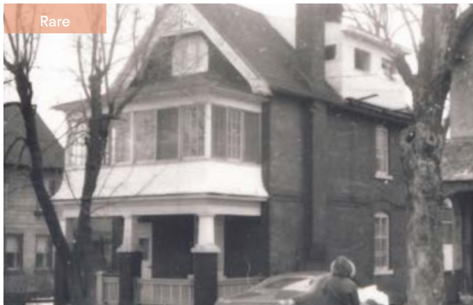
346. Plusieurs saillies sont présentes : une galerie et une véranda en encorbellement. 28, rue Hanson.
