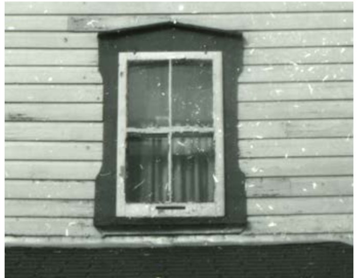
142. Chambranle à arc en mitre. 39, rue Kent.
