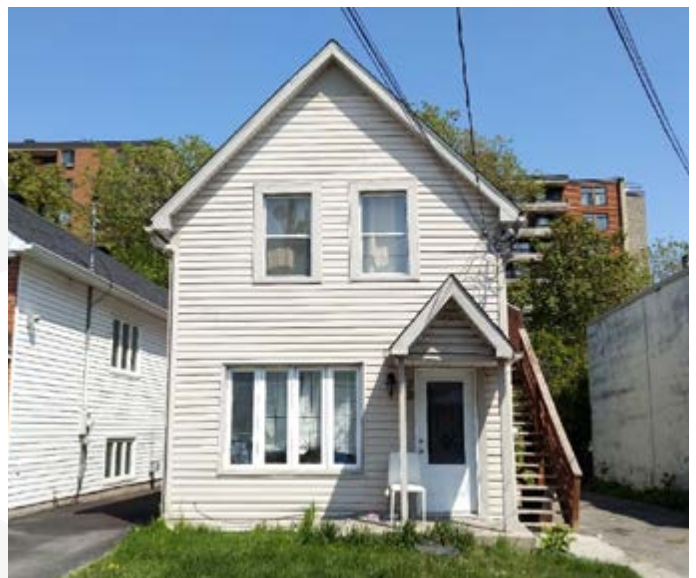
407. Baie élargie au rez-de-chaussée et menuiseries contemporaines en PVC. 78, rue Saint-Henri.
