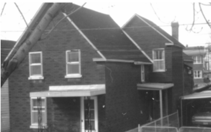
70. Maison avec un corps secondaire de deux niveaux, décalé et au toit à mur pignon. 43, rue Kent.
