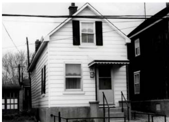
101. Composition symétrique, avec une ouverture centrée à l'étage. 17, rue Pilon.
