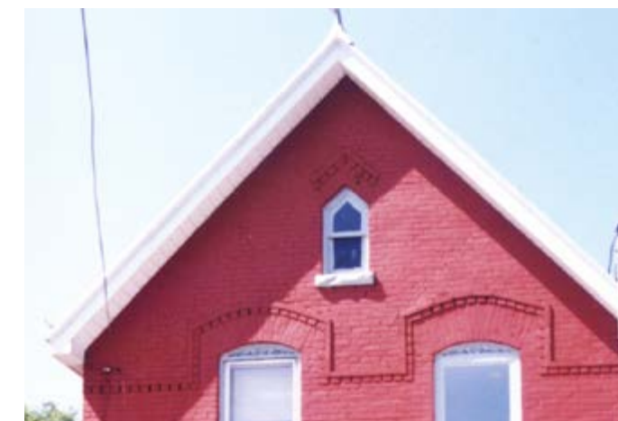
331. Fenêtre avec un arc en mitre. 137, rue Wright.
