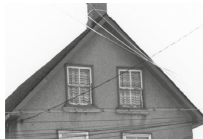
234. Deux fenêtres rectangulaires à carreaux. 68, rue Papineau.
