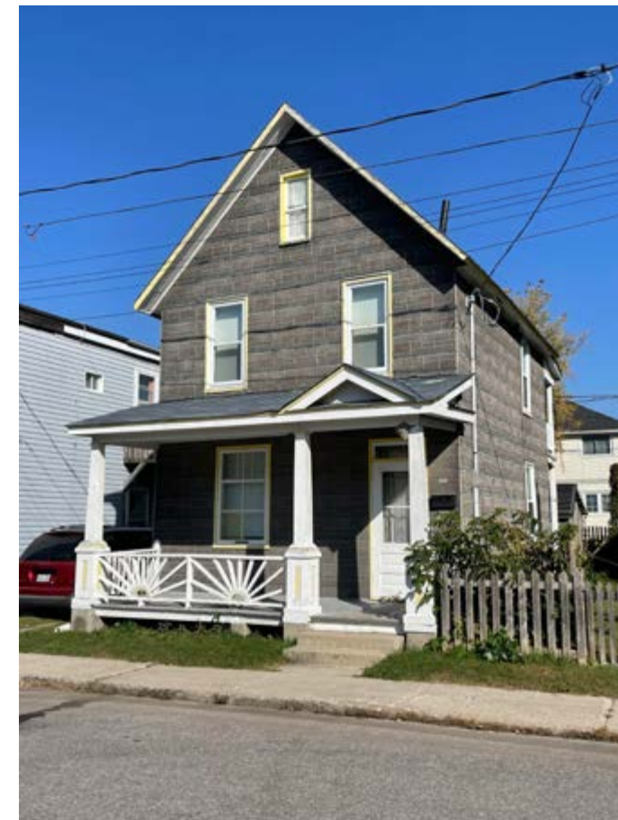
393. Revêtement ancien non traditionnel en papier brique. 57, rue Falardeau.
