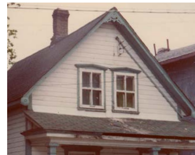
151. Gâble ouvragé et ornement à l'endroit de la corniche. 72, rue Dollard-de-Ormeaux.
