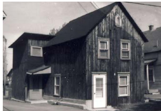
161. Maison de 2,5 étages, corps secondaire de 2 niveaux, décalé et au toit en appentis. 73, rue Dollard-des-Ormeaux.
