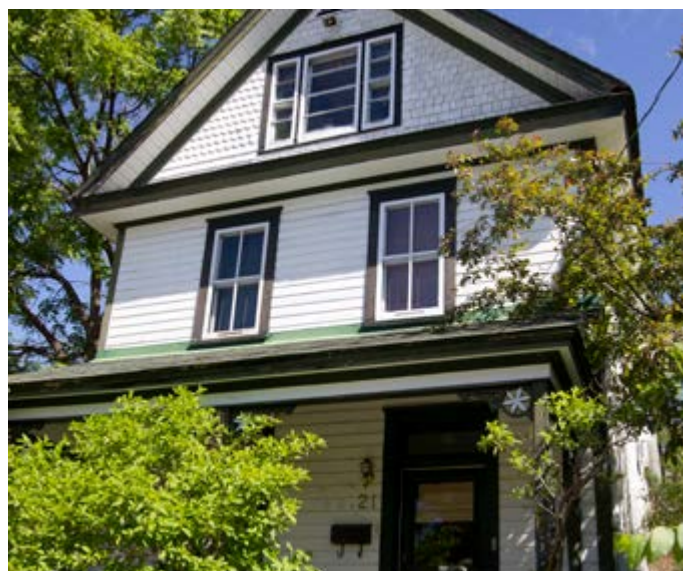
424. Maison de bois avec bardeaux dans le pignon. 21, rue du Couvent (secteur Aylmer).
