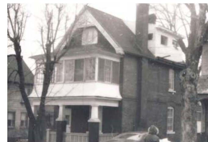
360. Cheminée en brique hors-murs. 28, rue Hanson.
