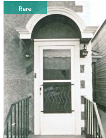
247. Auvent en plein cintre, sans colonnes. 56, rue de l'Hôtel-de-ville.
