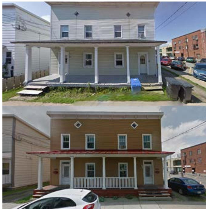
450. Édifice situé au 1145-1151, rue Sainte-Julie en 2009 (en haut) et en 2017 (en bas) à Trois-Rivières.
