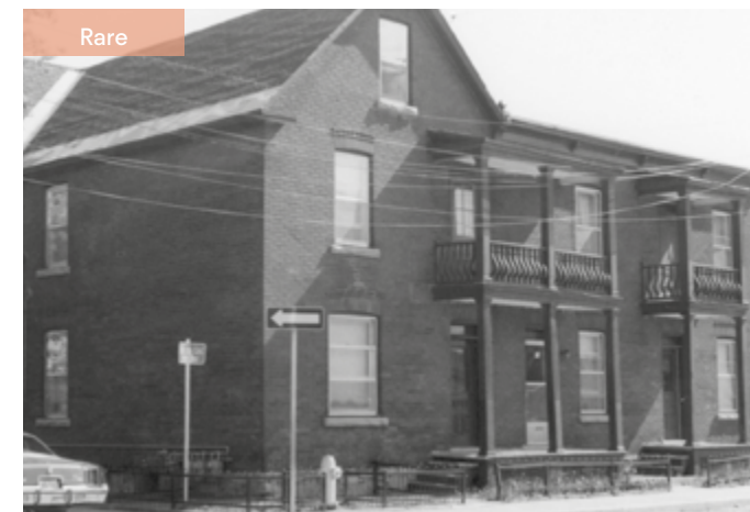
297. Maison avec une annexe au toit plat, ajoutant plusieurs logements. 17, rue Victoria.
