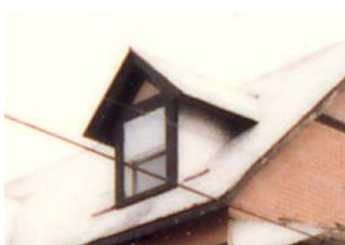
361. Lucarne à fronton. 123, rue Wellington.
