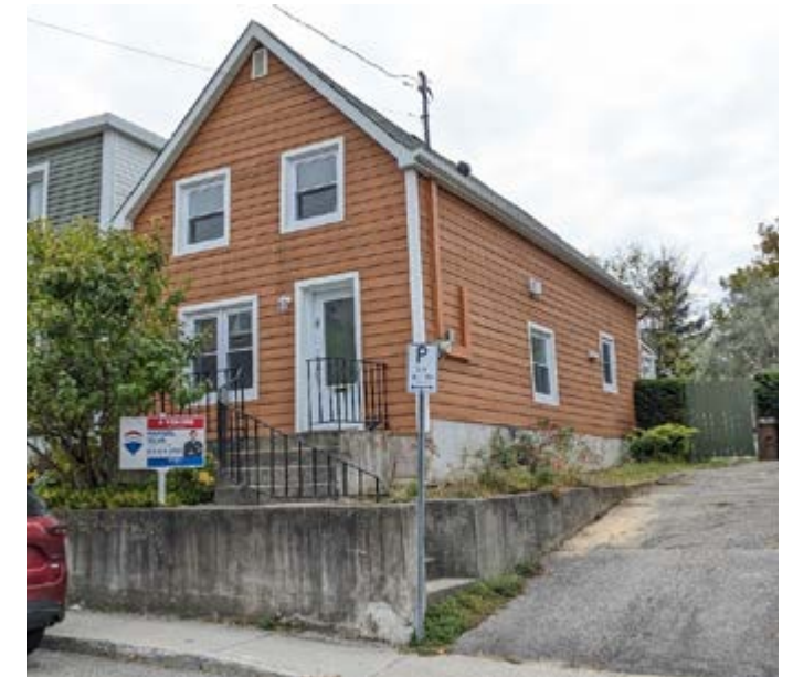
449. Maison allumette en bois restaurée avec un parement de type Maibec. 20, rue Garneau.
