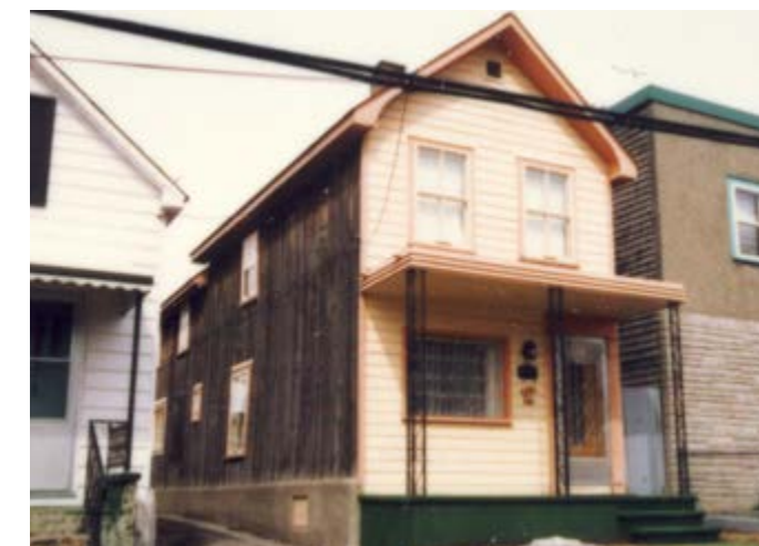
184. Combinaison de plusieurs parements : planches à feuillure ou à gorge et planches à couvre-joint. 19, rue Pilon.
