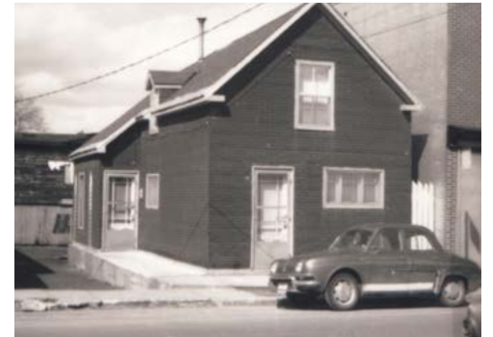
78. Pente de toit typique. 71, rue Frontenac.
