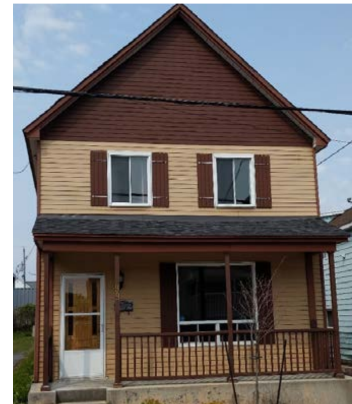
436. Maison allumette banalisée, qui a perdu plusieurs de ses caractéristiques anciennes. 99, rue Leduc.
