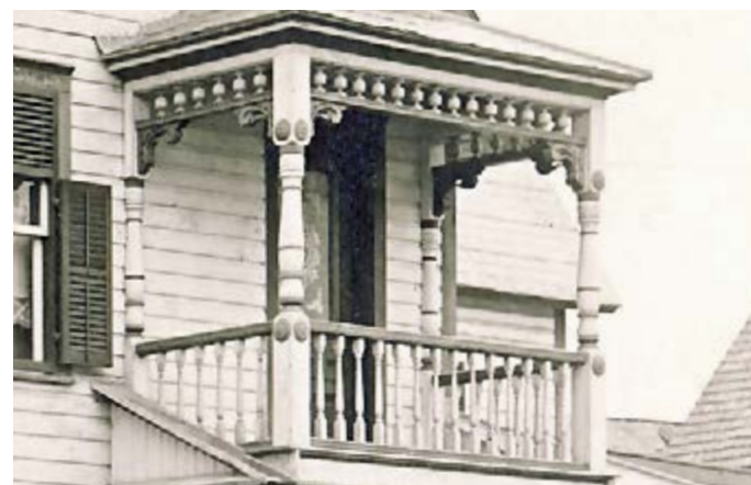
280. Aisseliers aux coins des colonnes et lambrequins sous la toiture du balcon. Emplacement inconnu.
