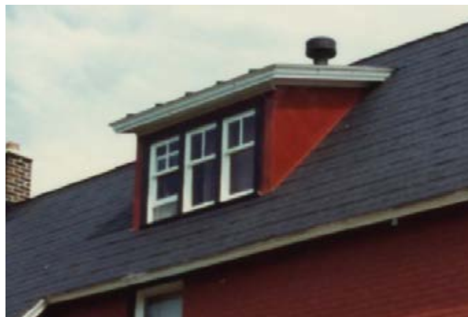
363. Lucarne rampante. 157, rue Laurier.
