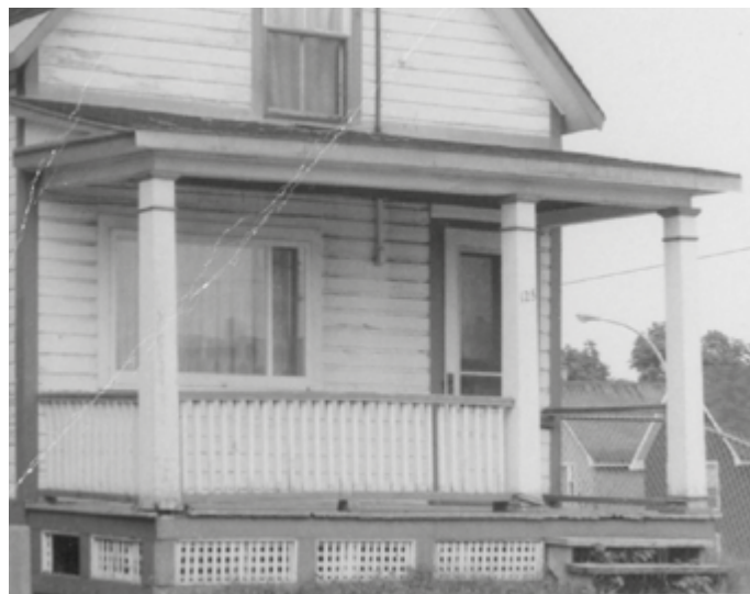
145. Garde-corps à barreaux droits. 82, rue Frontenac.
