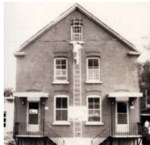
316. Composition symétrique, avec deux baies rapprochées à l'étage. 155, rue Saint-Etienne.
