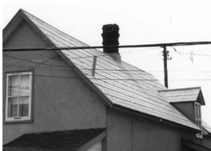
85. Toit en tôle embossée. 43, rue Carillon.
