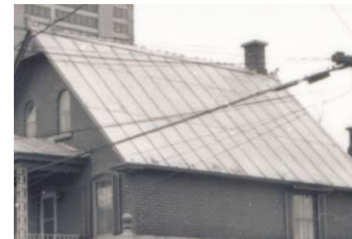
303. Toit en en tôle pincée. 133, rue Notre-Dame-de-l'Île.
