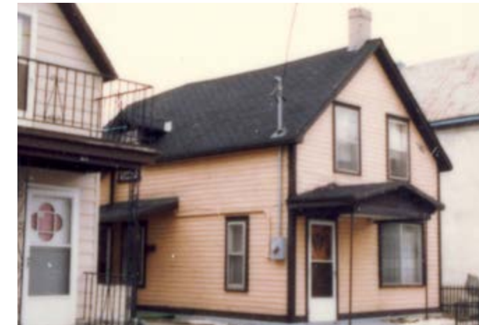
132. Cheminée dans le pignon de la façade avant. 59, rue Saint-Henri.
