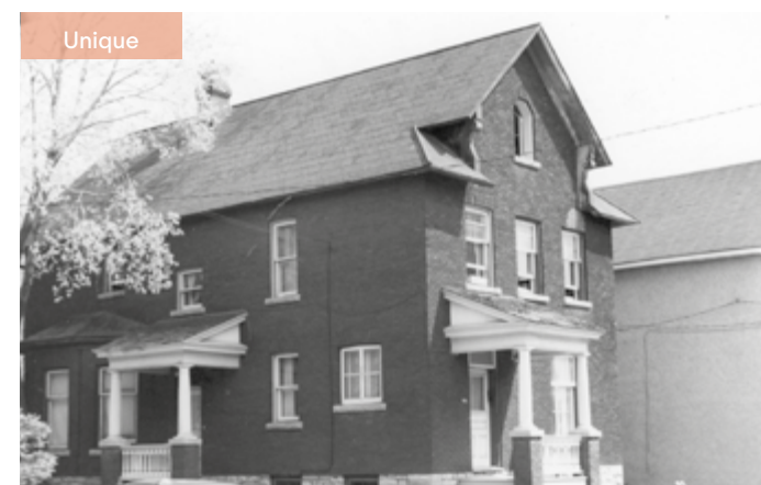
300. Toiture atypique, avec deux pans sur la façade avant, formant une lucarne. 44, rue Saint-Jacques.
