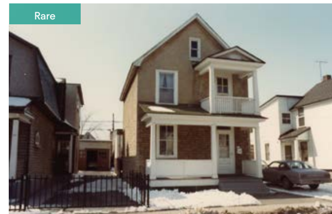
256. Plusieurs saillies sont présentes : un galerie couverte, surmontée d'un balcon et d'un auvent à fronton. 37, rue Lois.
