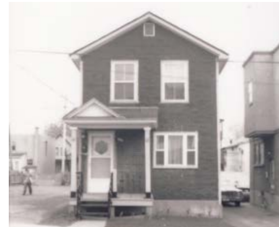
175. Toiture à pente faible. 185, rue Dollard-des-Ormeaux.
