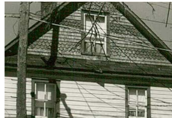
273. Ornement sur le pignon, en bardeaux de bois taillés. 263, rue Champlain
