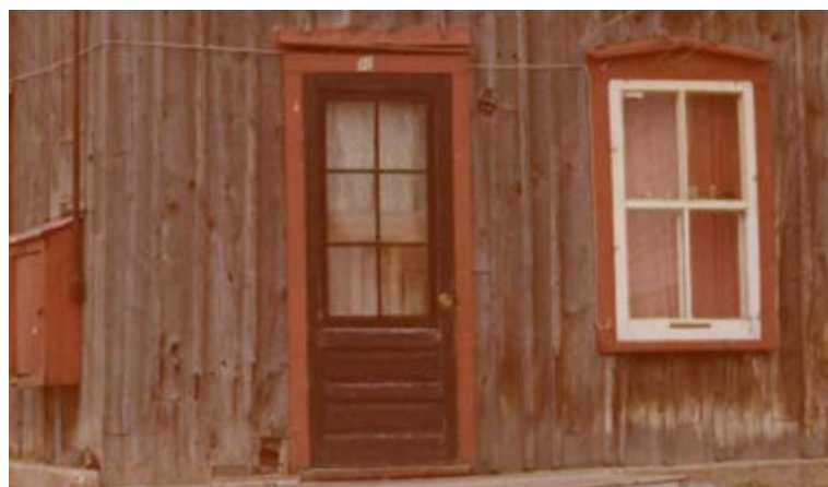
109. Contre-porte en bois, fenestrée et à panneaux. 90, rue Charlevoix.
