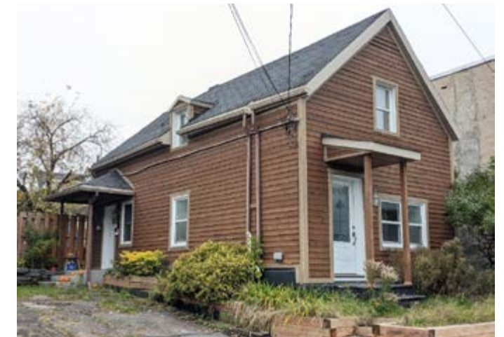
447. Maison allumette en bois restaurée avec un parement en bois. 150, rue Leduc.
