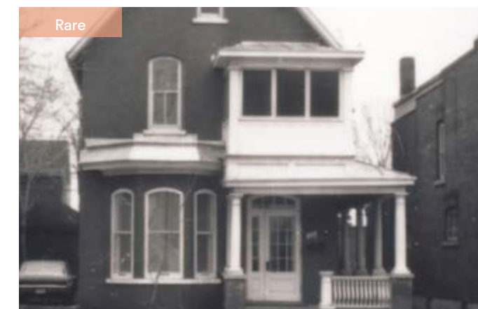
347. Plusieurs saillies sont présentes : une galerie latérale, une logette au-dessus de la porte principale et un oriel (à gauche). 156, rue Notre-Dame-de-l'Île.
