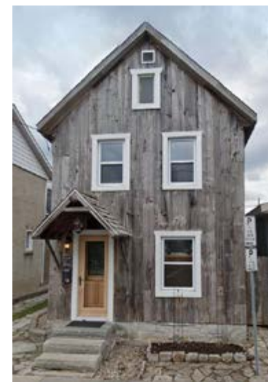
443. Maison allumette citée au 57, rue de Lanaudière, dans le secteur de Val-Tétreau.
