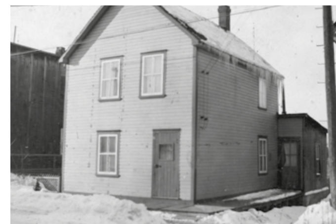
154. Maison de 2 étages, corps secondaire d'un niveau, décalé et au toit en appentis. 71, rue Charlevoix.
