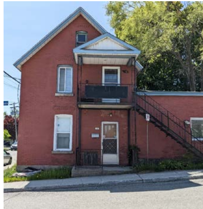
410. Colonnes et balustrade en fer forgé non traditionnelles et ajout d'un escalier devant la façade avant. 14, rue Monseigneur-Baudoin.
