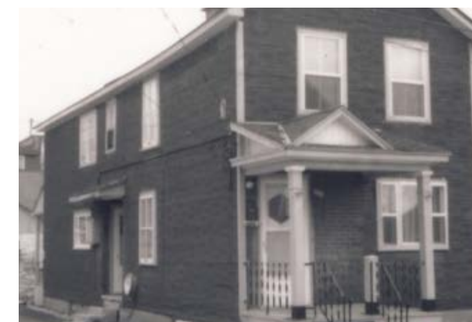
245. Perron et auvent à fronton, entrée secondaire en alcôve. 185, rue Dollard-des-Ormeaux.
