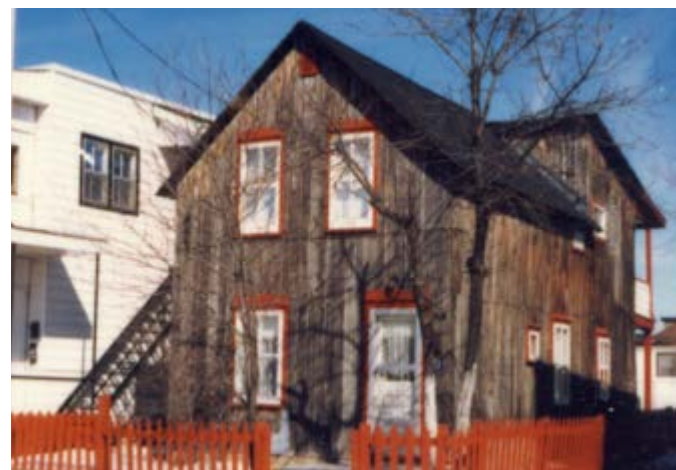
66. Maison avec un corps secondaire de deux niveaux, aligné et au toit en appentis. 27, rue Mance.
