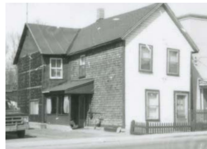
183. Combinaison de plusieurs parements : planches à feuillure ou à gorge, bardeaux de bois et papier kraft. 149, rue Papineau.
