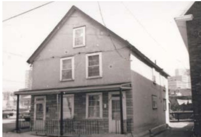
209. Composition décentrée et symétrique, avec deux baies à l'étage. 10-12, rue Victoria.
