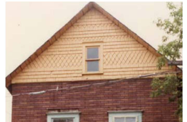
274. Ornement sur le pignon, en bardeaux de bois taillés. 271, rue Notre-Dame-de-l'Île.
