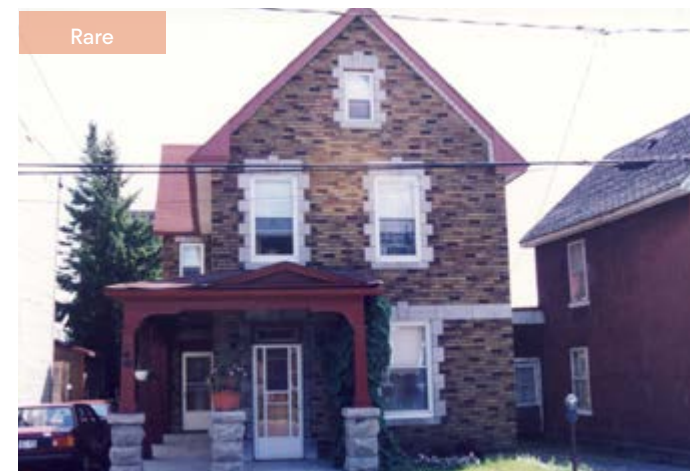
307. Parement en brique brune. 40, rue Wright.
