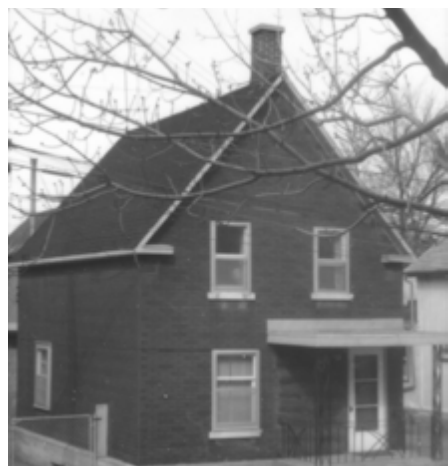
260. Cheminée sur le pignon avant. 43, rue Kent.
