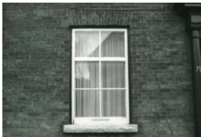
324. Fenêtre à guillotine et à 6 carreaux. 76, rue de l'Hôtel-de-ville.
