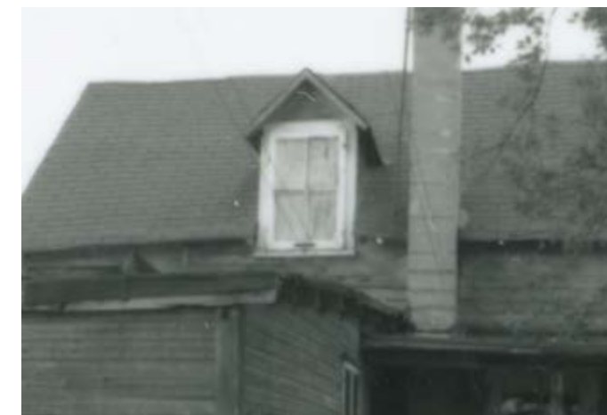
264. Lucarne pendante et à pignon à l'arrière de la maison. 105, rue Dollard-des-Ormeaux.
