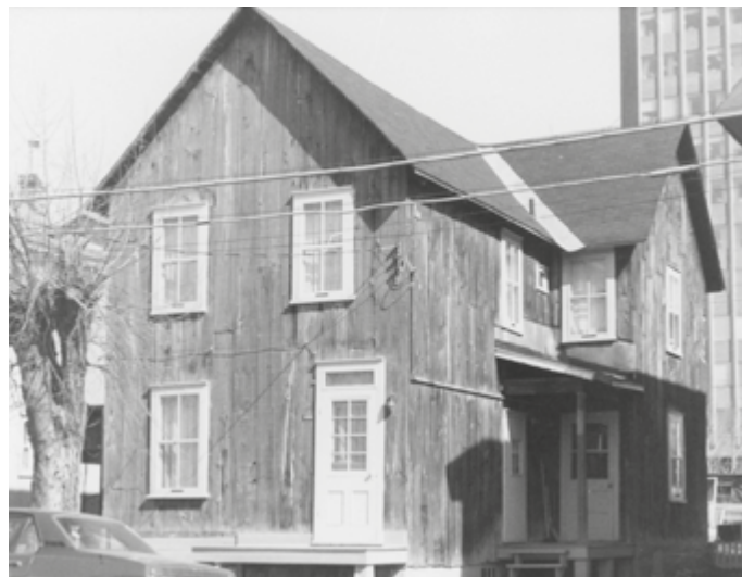
198. Composition symétrique, la baie du rez-de-chaussée est alignée avec l'une de l'étage et la porte est décentrée. 328, rue Champlain.
