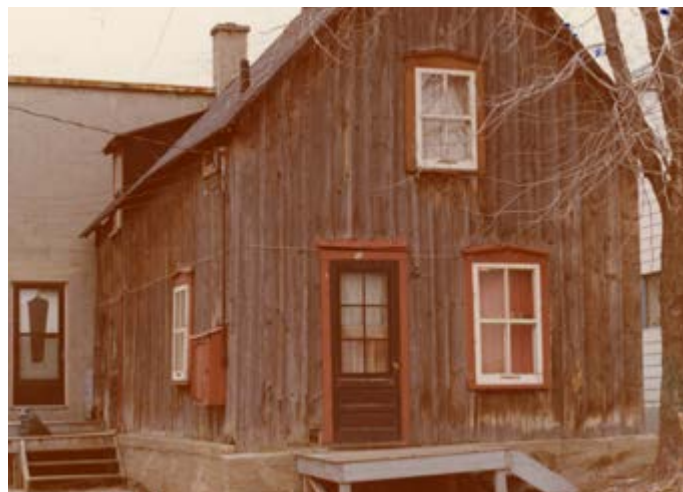
91. Parement en planches verticales brutes à couvre-joint. 90, rue Charlevoix.
