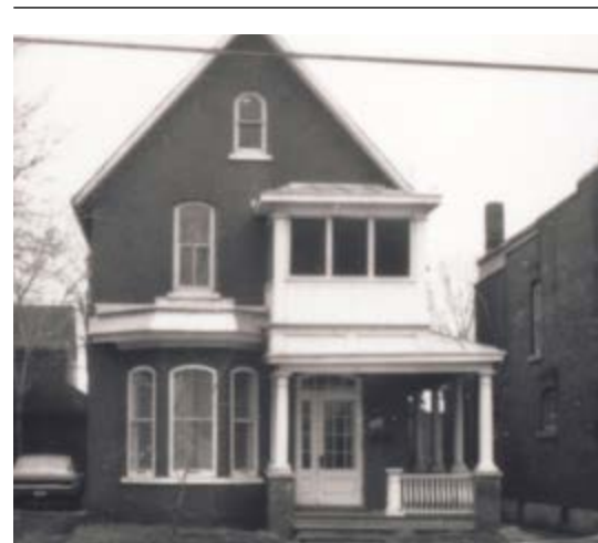
298. Toiture typique. 156, rue Notre-Dame-de-l'Île.
