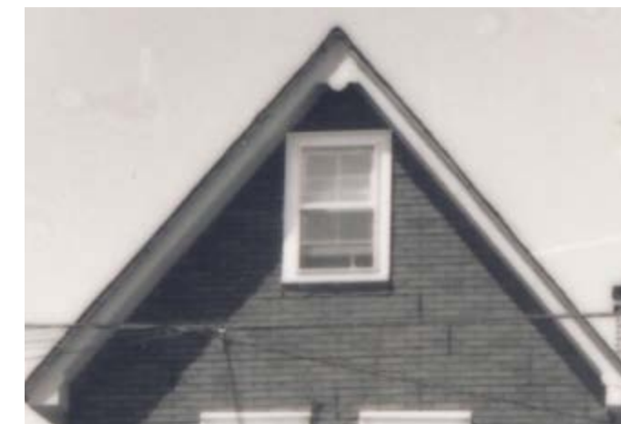
233. Fenêtre rectangulaire à carreaux. 179, rue Dollard-des-Ormeaux.
