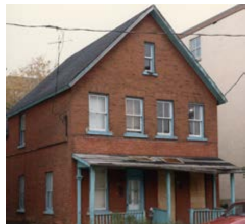
318. Composition symétrique, avec quatre ouvertures alignées aux deux niveaux. Rue Champlain.
