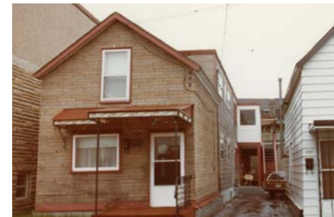
81. Toiture à pente faible. 18, rue Kent.
