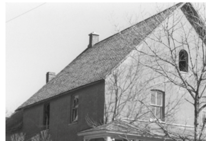
302. Toit en bardeaux de cèdre. Emplacement inconnu.
