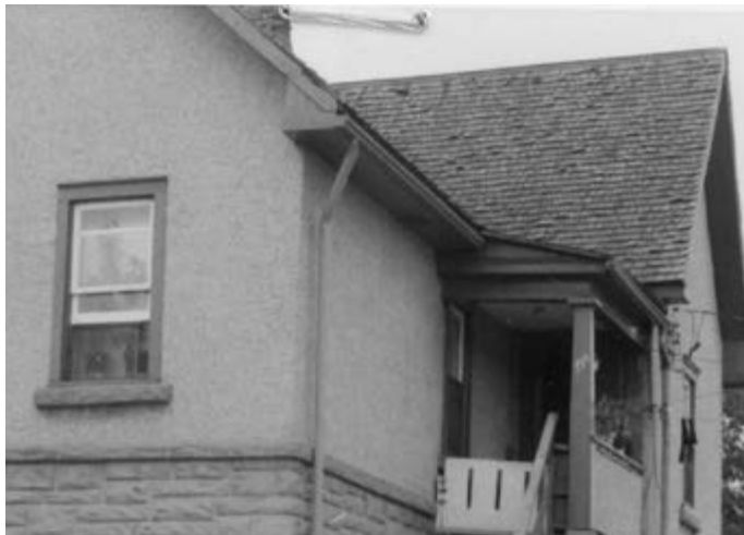
179. Toiture en bardeaux de bois. 29, rue Verdun.
