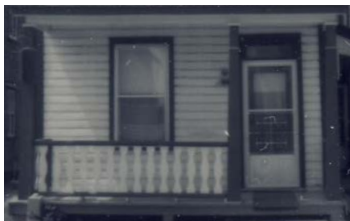
277. Garde-corps en bois scié. 127, rue Dollard-des-Ormeaux.
