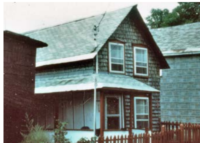
92. Parement en bardeaux de bois. Emplacement inconnu sur la rue Dollard-des-Ormeaux.
