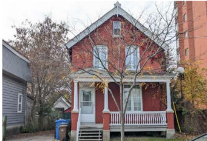
402. Revêtement ancien et préservé en brique. 251, rue Champlain.
