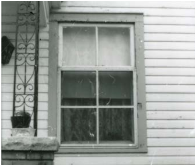
220. Fenêtre à guillotine à 6 carreaux. 85, rue Saint-Henri.
