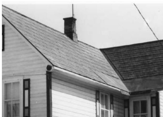
180. Toit en tôle embossée. 254, rue Champlain.
