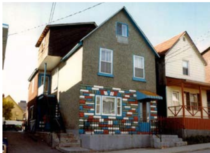
396. Revêtement d'agrégats et imitant la pierre au rez-de-chaussée. 86, rue Charlevoix.
