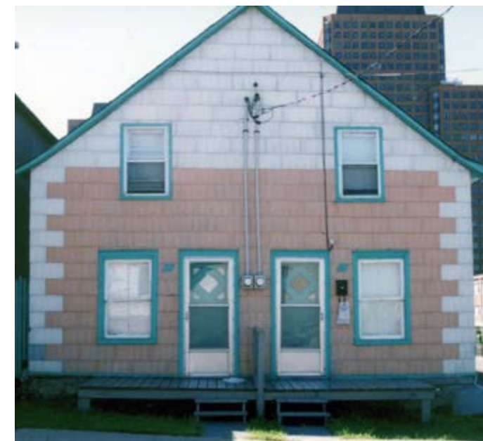
394. Revêtement en tuiles d'amiante. 10, rue Vaudreuil.
