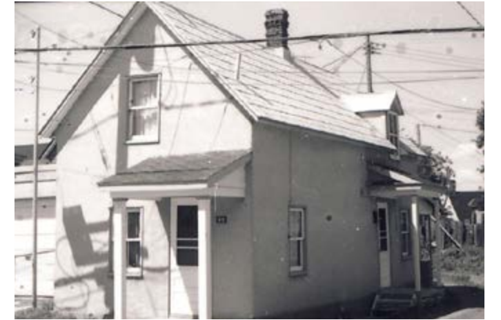
131. Cheminée en brique au centre de la maison. 45, rue Carillon.
