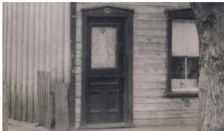
111. Porte en bois, fenestrée et à panneaux. Emplacement inconnu.
