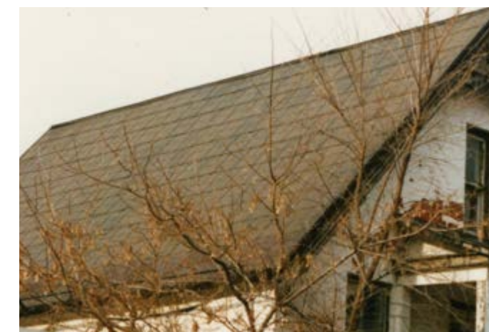
305. Toit en tôle embossée. Rue Notre-Dame-de-l'Île.
