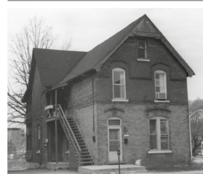
309. Composition symétrique, la porte est décentrée et la baie du rez-de-chaussée est plus large. 121, rue Montcalm.
