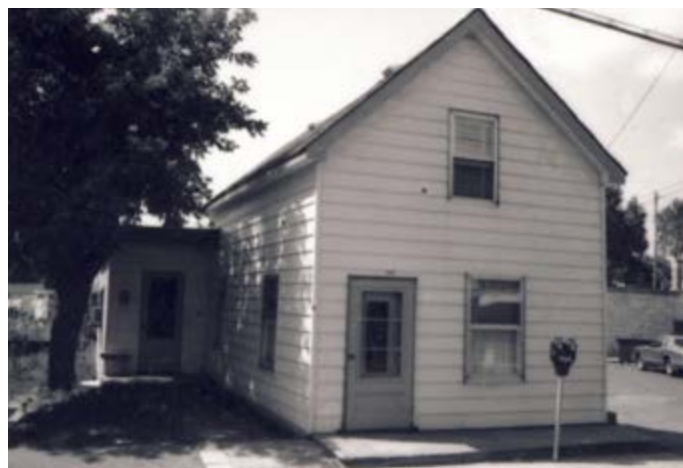
99. Composition asymétrique, avec une ouverture centrée à l'étage. La porte est décentrée au rez-de-chaussée. 149, rue Eddy.
