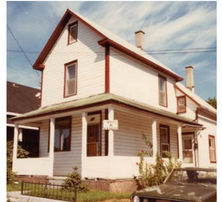
272. Chambranles et planches de coin peintes d'une couleur contrastante. 298, boulevard des Allumettières.
