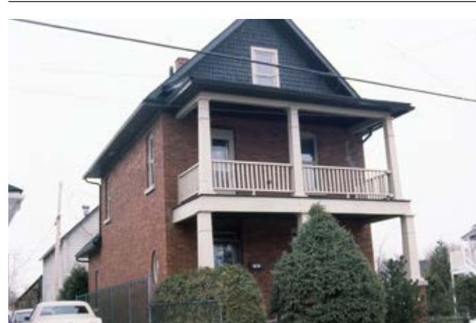
306. Parement en brique rouge traditionnelle et bardeaux de bois sur le pignon. 18, rue Bégin.
