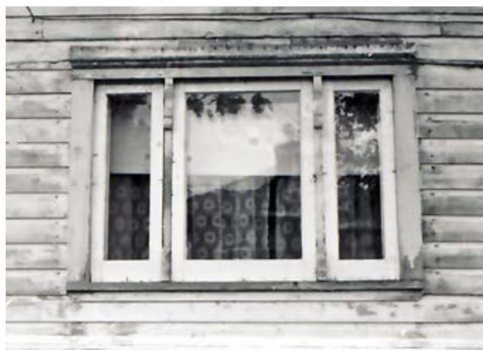
120. Fenêtre panoramique en triplet, avec un piédroit ouvragé. 150, rue Kent.
