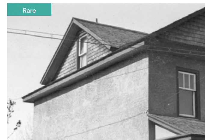
266. Lucarne-pignon latérale. 71, rue Jeanne d'Arc.
