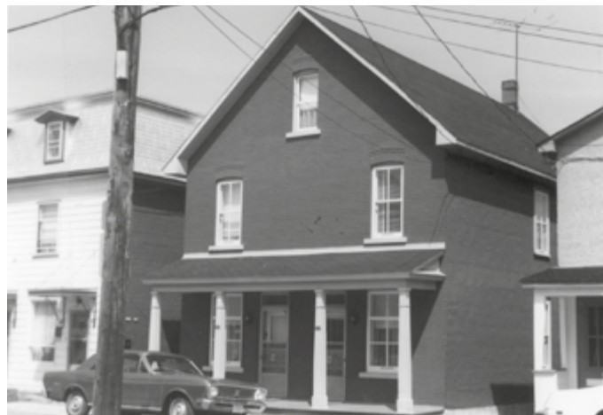
315. Composition symétrique, avec deux baies éloignées à l'étage. 92, rue Saint-Jacques.
