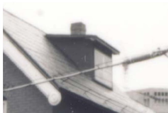
364. Lucarne rampante. 62, rue de l'Hôtel-de-ville.
