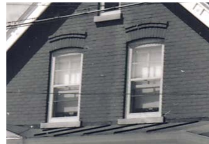
365. Plate-bande en arc surbaissé et appareillage de brique. 251, rue Champlain.
