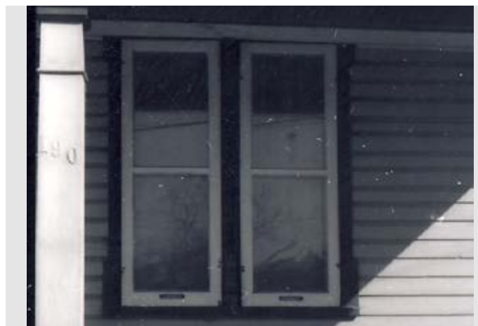
227. Fenêtre jumelée à carreaux. 190, rue Champlain.
