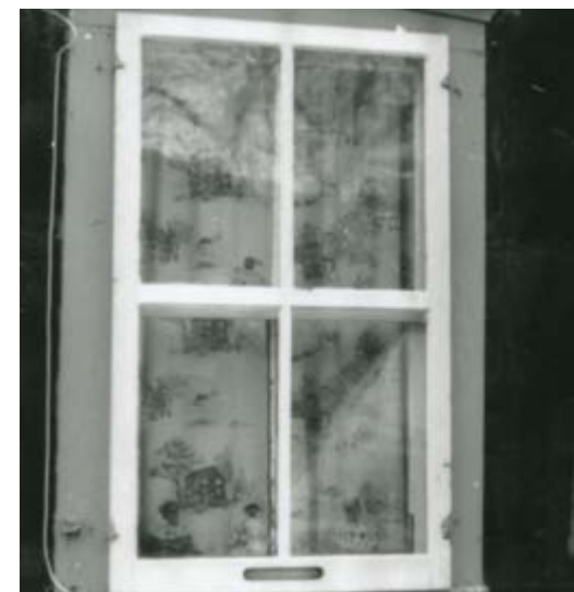
113. Contre-fenêtre à 4 carreaux. 228, rue Notre-Dame-de-l'Île.
