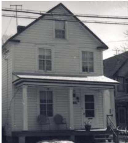
248. Galerie sur la façade principale. 310, rue Champlain.
