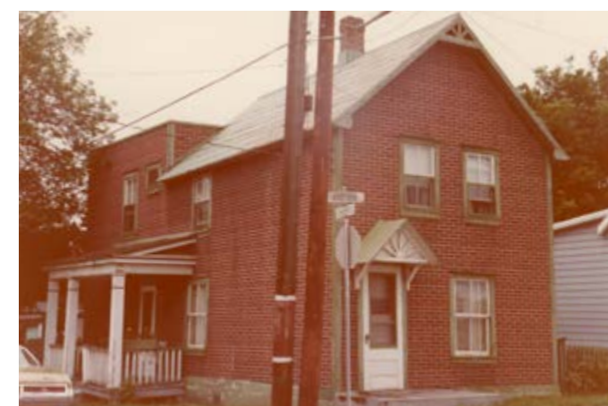
156. Maison de 2 étages, corps secondaire de 2 niveaux, aligné et au toit plat. 89, rue Dollard-de-Ormeaux.
