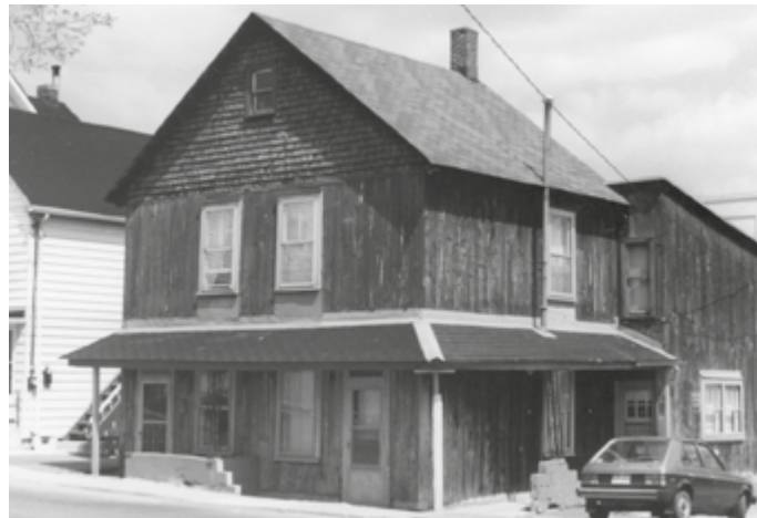
172. Maison de deux logements, corps secondaire de deux niveaux, décalé et au toit en appentis. 128, rue Saint-Rédempteur.
