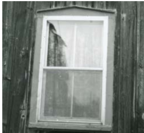
267. Chambranle simple à arc en mitre. 75, rue Kent.
