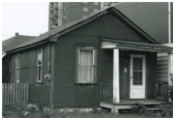
59. Maison en bois d'un étage, revêtement en papier kraft et auvent au-dessus de la porte principale. 31, rue des Açores.
