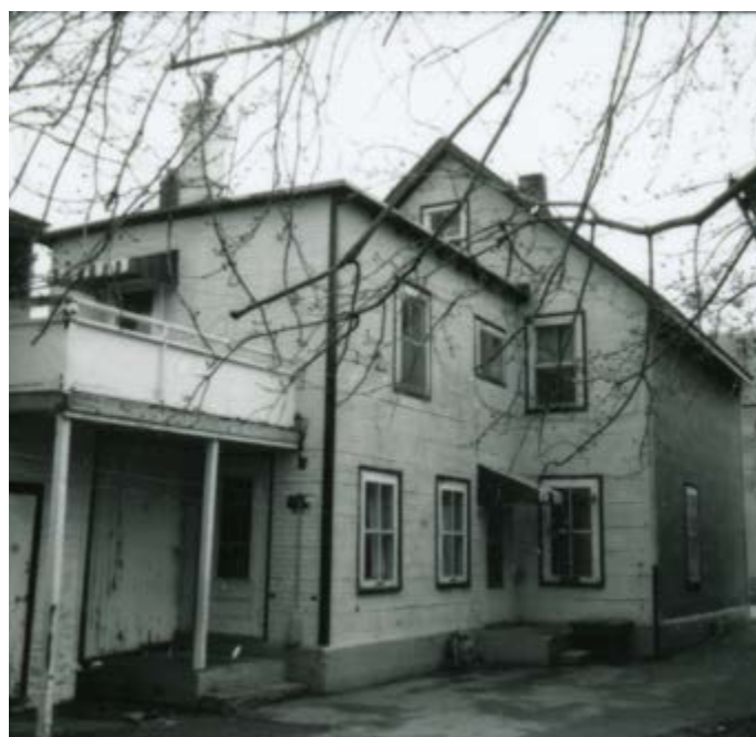
48. Maison de deux étages et demi en bois avec un corps secondaire, vu de la cour arrière. 73, rue de l'Hôtel-de-ville.
