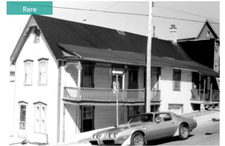
253. Balcon sur la façade latérale. 184, rue Champlain.
