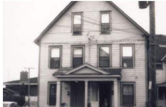
208. Composition symétrique, avec quatre baies à l'étage et deux sur le pignon. 57-59, rue Saint-Etienne.
