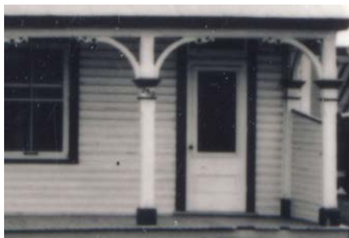
279. Aisseliers entre les colonnes et la toiture de la galerie. 253, rue Laramée.
