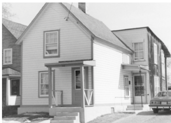
100. Composition asymétrique, avec une ouverture décentrée à l'étage. La porte est décentrée au rez-de-chaussée. 268, rue Notre-Dame-de-l'Île.
