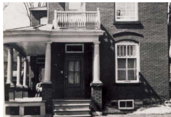
343. Galerie latérale et balcon au-dessus de la porte principale. Emplacement inconnu.
