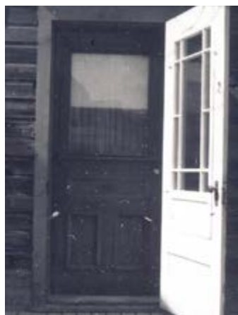
110. Contre-porte et porte en bois, fenestrées et à panneaux. 317, rue Champlain.
