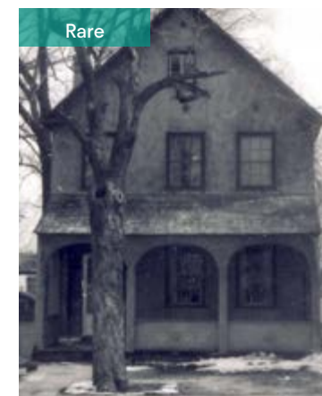
206. Composition symétrique, avec trois baies au rez-de-chaussée et à l'étage alignées. 26, rue Hanson.
