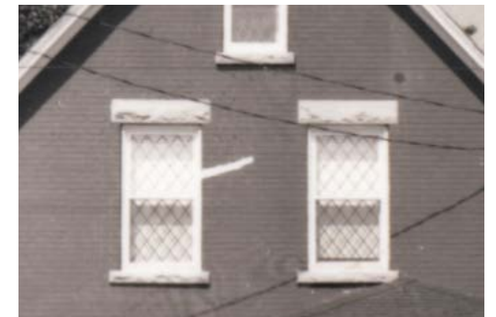
368. Linteaux bosselés en béton. 157, rue Laurier.
