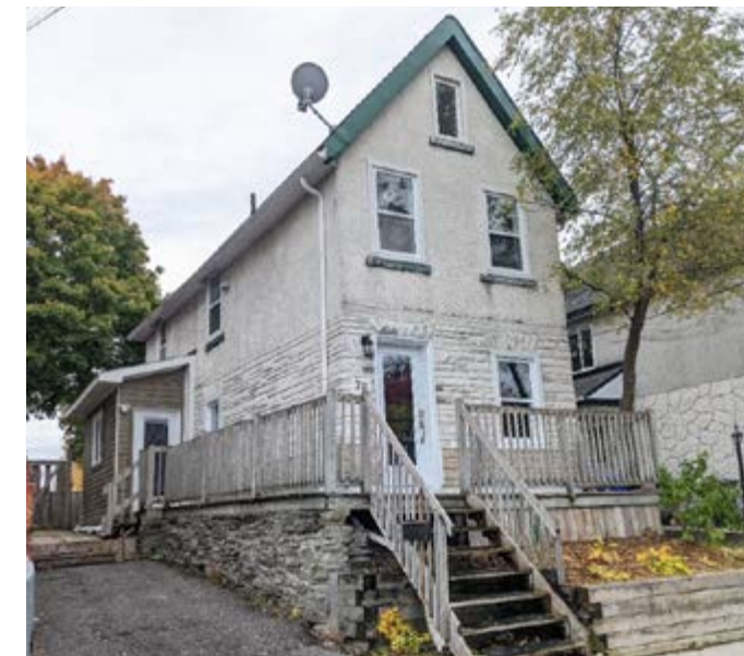
399. Revêtement non traditionnel en crépi et imitant la pierre et peint d'une couleur neutre. 78, rue Charlevoix.
