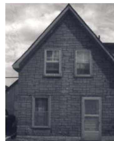
106. Composition symétrique, avec deux ouvertures rapprochées et centrées à l'étage. Les ouvertures sont décentrées au rez-de-chaussée. 83, rue Charlevoix.
