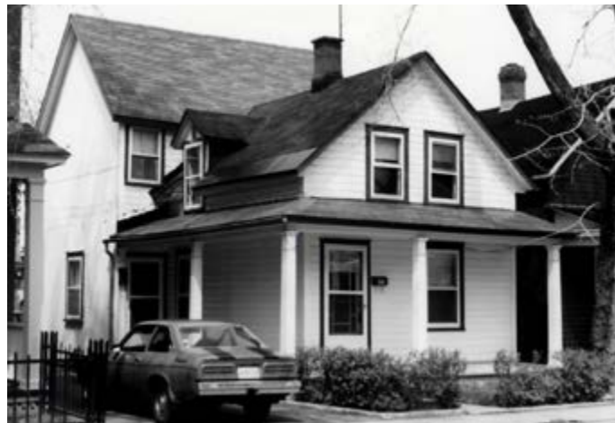
74. Maison avec un corps secondaire de deux niveaux, décalé et au toit à deux versants. 59, rue Vaudreuil.
