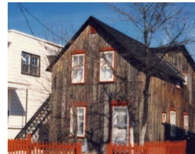
90. Parement en planches verticales brutes. 27, rue Mance.
