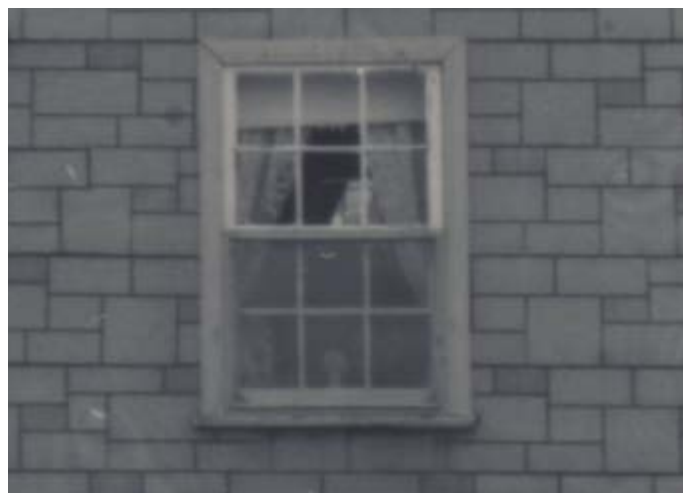
117. Fenêtre à guillotine à 12 carreaux. 43, rue Saint-Henri.
