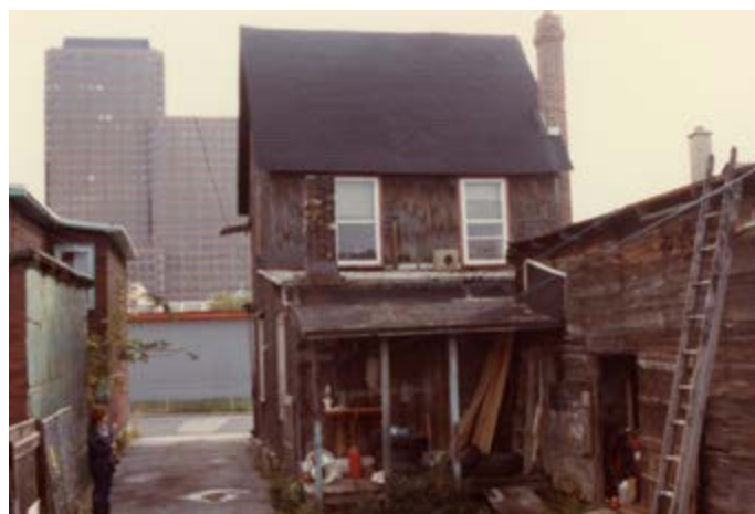
261. Cheminée hors-murs latérale. 37, rue Pilon.
