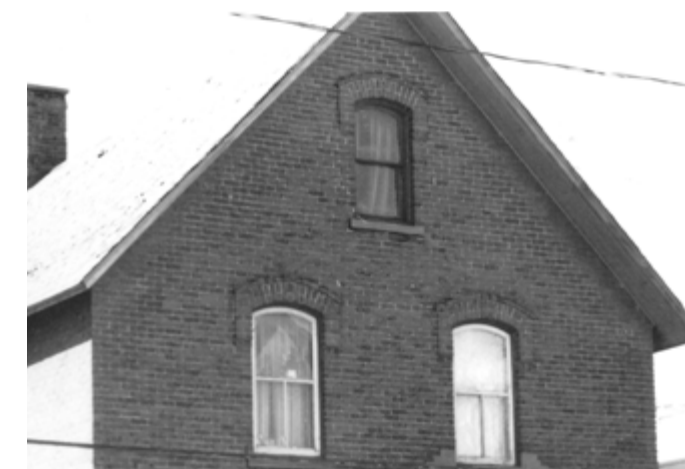
329. Fenêtre rectangulaire à arc surbaissé. 163, rue Notre-Dame-de-L'Île.
