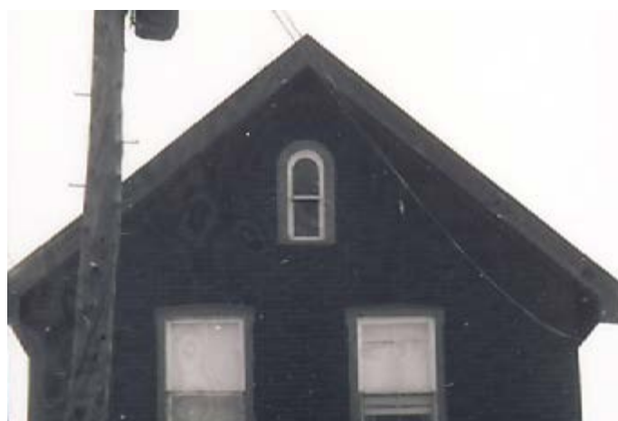
240. Fenêtre surmontée d'un arc en plein cintre. 248, rue Champlain.
