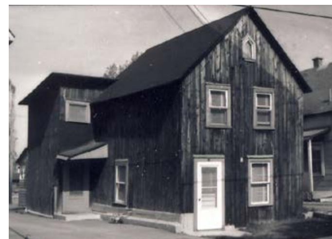
185. Parement en planches de bois verticales non traitées. 73, rue Dollard-des-Ormeaux.
