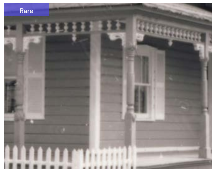
148. Aisseliers aux coins des colonnes et lambrequins sous la toiture de la galerie. 174, rue Leduc.
