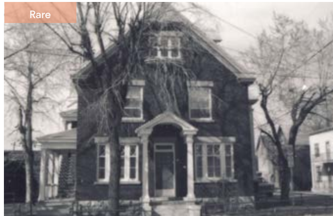
313. Composition symétrique, la porte est centrée et entourée de deux baies au rez-de-chaussée. 11, rue Victoria.
