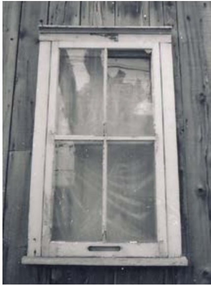
218. Contre-fenêtre à 4 carreaux. 328, rue Champlain.
