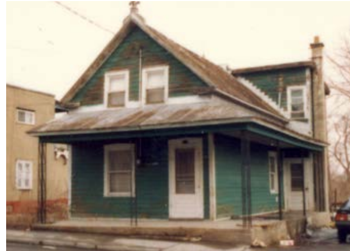
128. Galerie couverte sur les façades avant et latérale (les colonnes en fer ne sont pas d'origine). 83, rue Frontenac.
