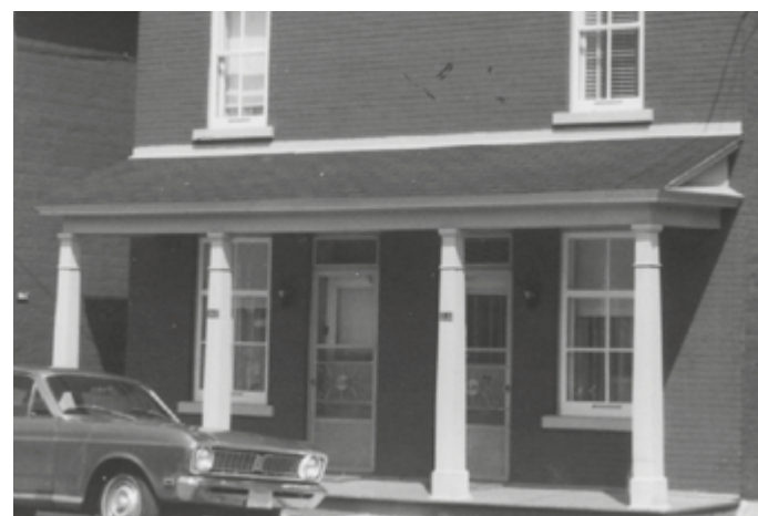
341. Galerie sur la façade avant. 92, rue Saint-Jacques.
