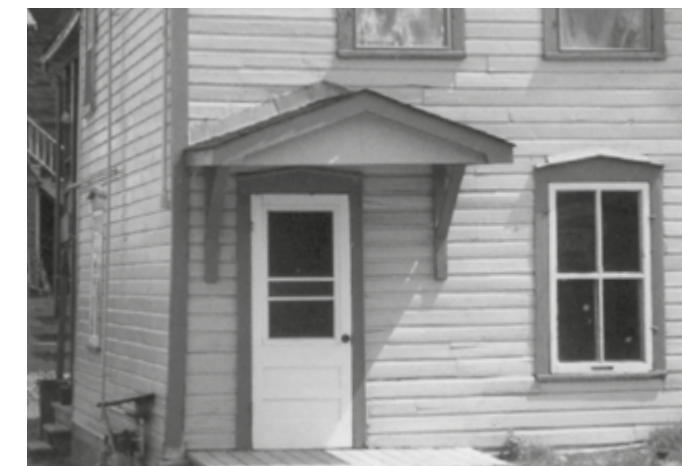
243. Perron et auvent à fronton, sans colonnes, sur la façade avant. 92, rue Laval.
