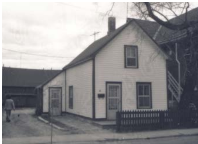
64. Maison avec un corps secondaire d'un niveau, décalé et au toit à mur pignon. 55, rue Vaudreuil.
