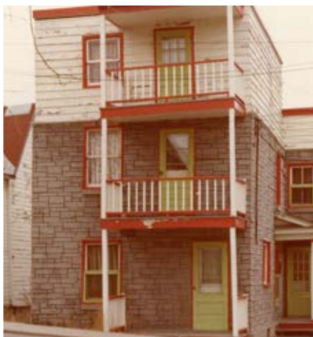
387. Maison allumette en bois agrandie d'un étage. 57, rue Dollard-des-Ormeaux.
