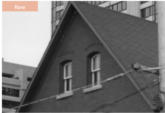
332. Deux fenêtres avec arcs surbaissés. 153, rue Notre-Dame-de-l'Île.
