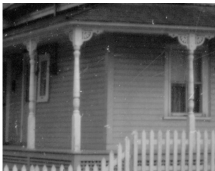
147. Aisseliers entre les colonnes et la toiture de la galerie. 114, rue Saint-Jacques.
