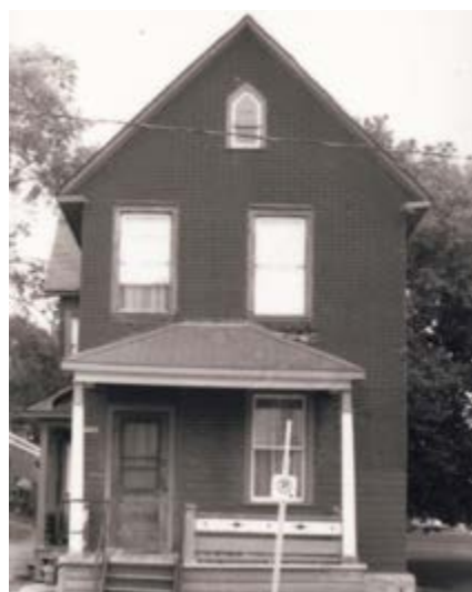
200. Composition asymétrique, les ouvertures de l'étage et du rez-de-chaussée sont alignées. 227, rue Saint-Rédempteur.
