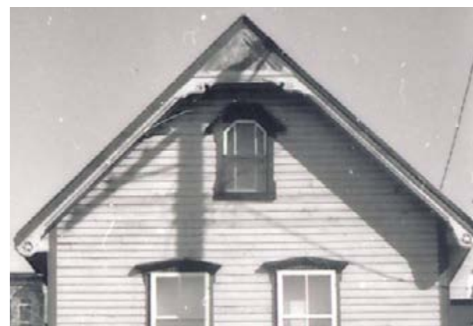
281. Gâble et fascia en bois ouvragés. 190, rue Champlain.
