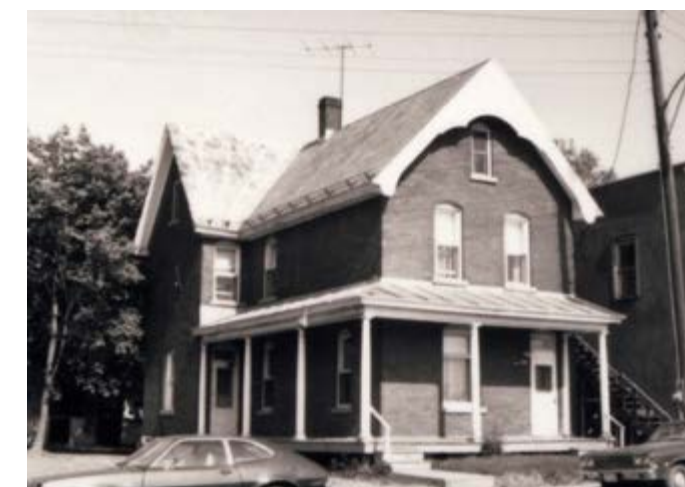
23. Maison allumette en brique, appartenant à Joseph Binet, située au 227, rue Laurier.
