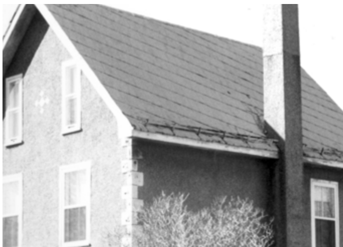
181. Toit de tôle en plaque, à la canadienne. 245, rue Papineau.
