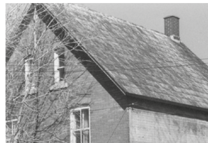
304. Toit en tôle embossée. 192, rue Champlain.
