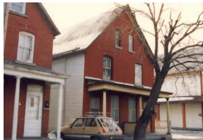
308. Parement en tôle embossée sur la façade latérale. 192, rue Champlain.
