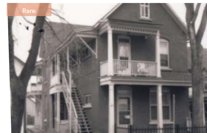
348. Plusieurs saillies sont présentes : une galerie, un balcon à auvent au-dessus de la porte principale et un escalier latéral. 57, rue Vaudreuil.
