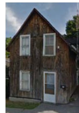
417. Maison allumette en planches verticales brutes. 53, rue Brook (secteur Aylmer).
