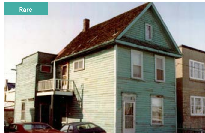
188. Parement en planches à feuillure ou à gorge et bardeaux de bois sur le pignon. 337, rue Laramée.
