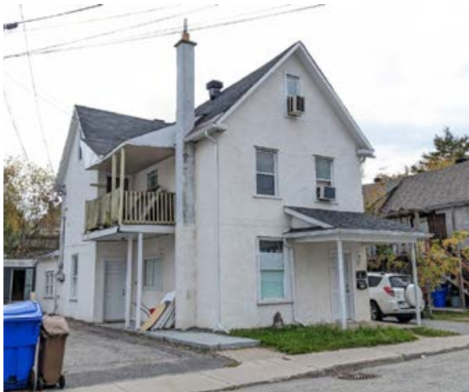
408. Cheminée non traditionnelle en béton, et balcon non traditionnel sur la façade latérale. 62, rue Charlevoix.
