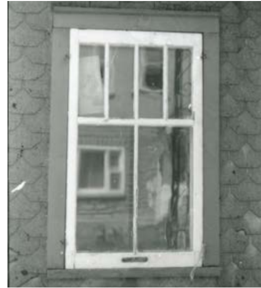
222. Contre-fenêtre à carreaux. 10, rue Garneau.
