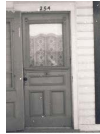
213. Contre-porte et porte en bois, à panneaux et fenestrée. 254, rue Champlain.
