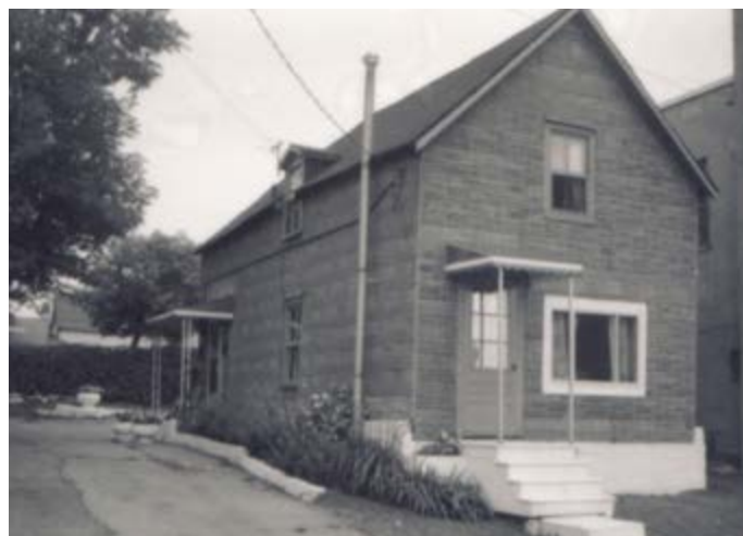
62. Maison sans corps secondaire. 151, rue Leduc.
