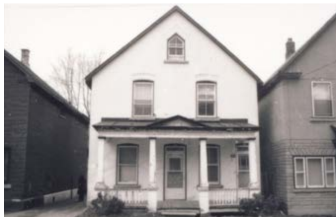
317. Composition symétrique, avec une porte centrée et une autre décentrée. 73, rue de l'Hôtel-de-ville.
