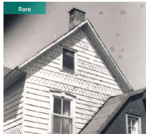
190. Parement en bardeaux de bois taillés en motifs (façade arrière). 254, rue Champlain.
