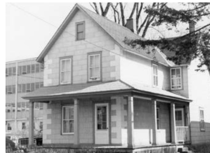
392. Revêtement en tuiles d'amiante. 274, rue Notre-Dame-de-l'Île.
