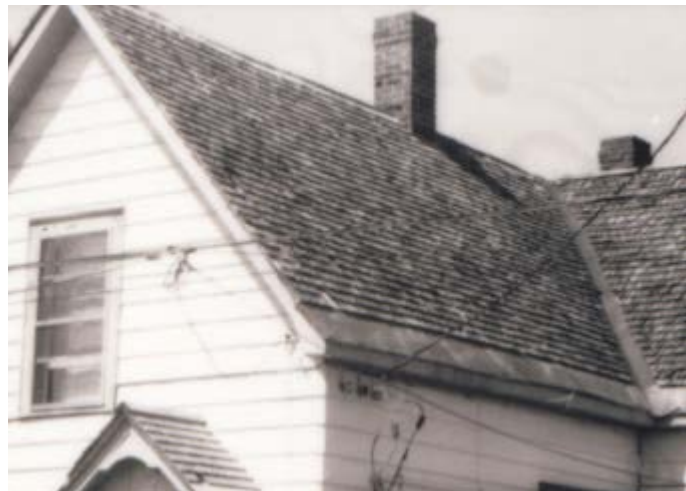
83. Toit en bardeaux de bois. 175, rue Kent.
