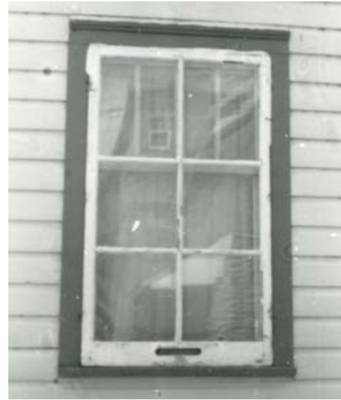
219. Contre-fenêtre à 6 carreaux. 6, rue Garneau.
