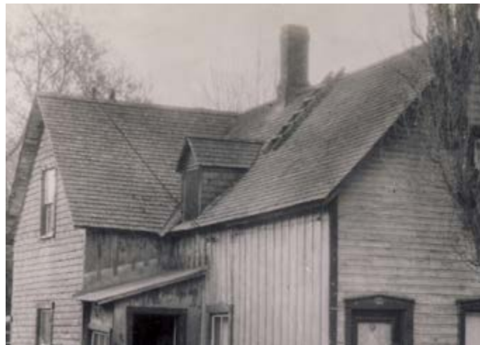
84. Toit en bardeaux de bois. Emplacement inconnu.
