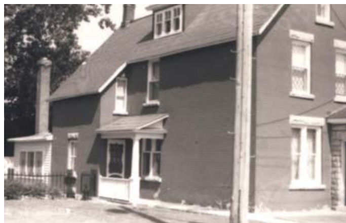
291. Maison avec un corps secondaire de deux niveaux, au toit à deux versants aligné à celui du corps principal. 157, rue Laurier.
