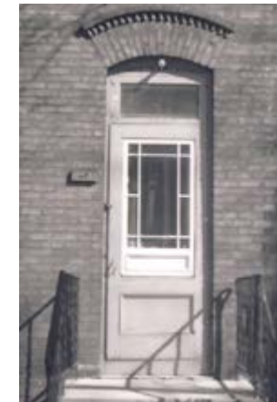
319. Contre-porte en bois fenestrée et à panneaux. L'ouverture est surmontée d'une imposte et d'un arc surbaissé ouvragé. 154, rue Champlain.
