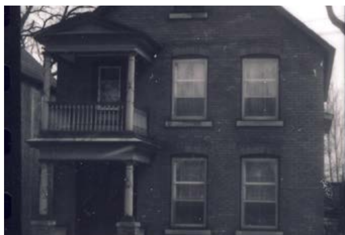
344. Balcon au-dessus de la porte principale et auvent à fronton. 24, rue Hanson.
