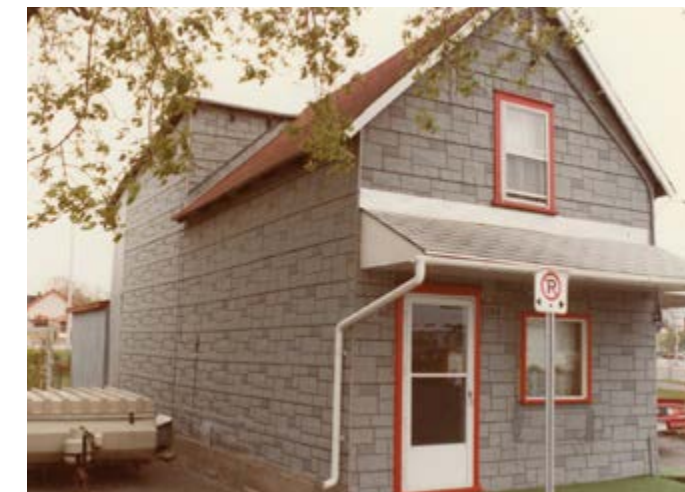
96. Parement en papier brique. 120, rue Dollard-des-Ormeaux.
