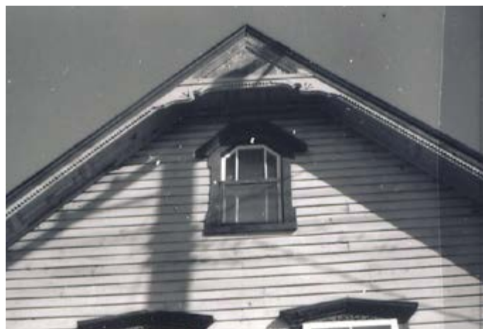
239. Fenêtre à carreaux, surmontée d'un arc brisé. 190, rue Champlain.
