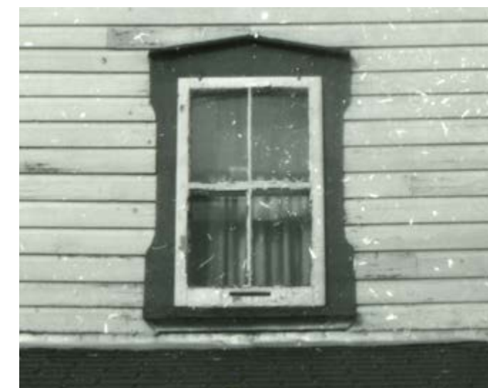
142. Chambranle à arc en mitre. 39, rue Kent.
