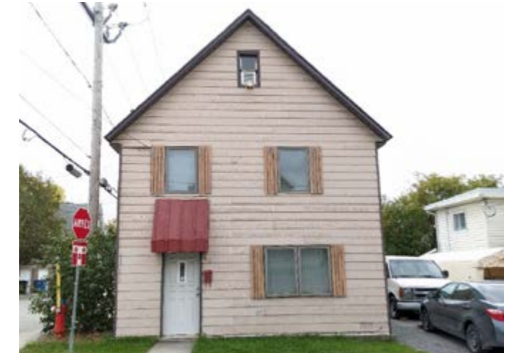
406. Baie élargie au rez-de-chaussée, baies raccourcies aux étages et menuiseries contemporaines en aluminium. 42, rue Garneau.
