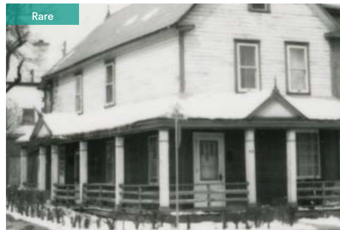
251. Galerie à frontons sur les façades avant et latérale. 45, rue Gagnon.
