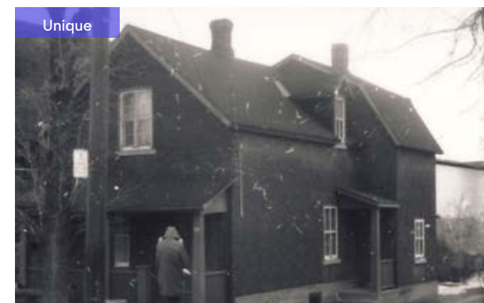
71. Maison avec un corps secondaire de deux niveaux, décalé et au toit mansardé avec mur pignon. 70, rue Hanson.
