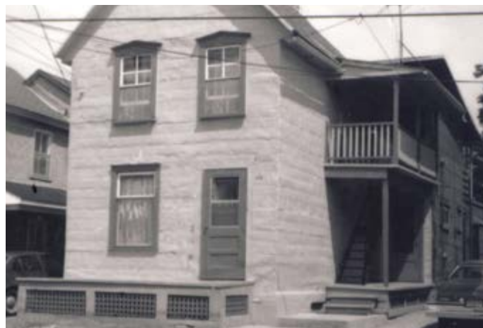
191. Parement en tôle embossée. 109, rue Garneau.
