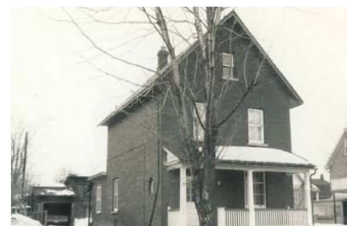
288. Maison avec un corps secondaire d'un niveau aligné et au toit plat. 17, rue Connaught.
