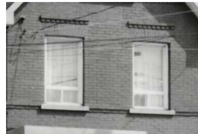
367. Plate-bande droite et appareillage de brique. 129, rue Wellington.
