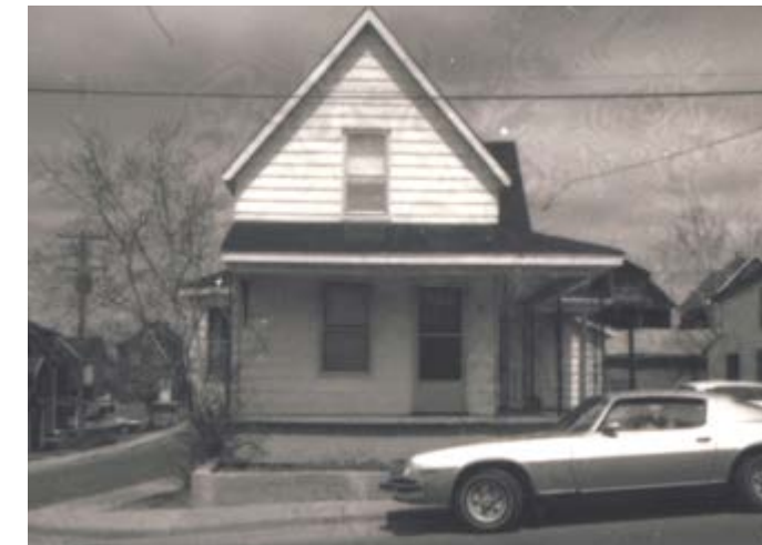
79. Toiture à pente forte. 17, rue Papineau.
