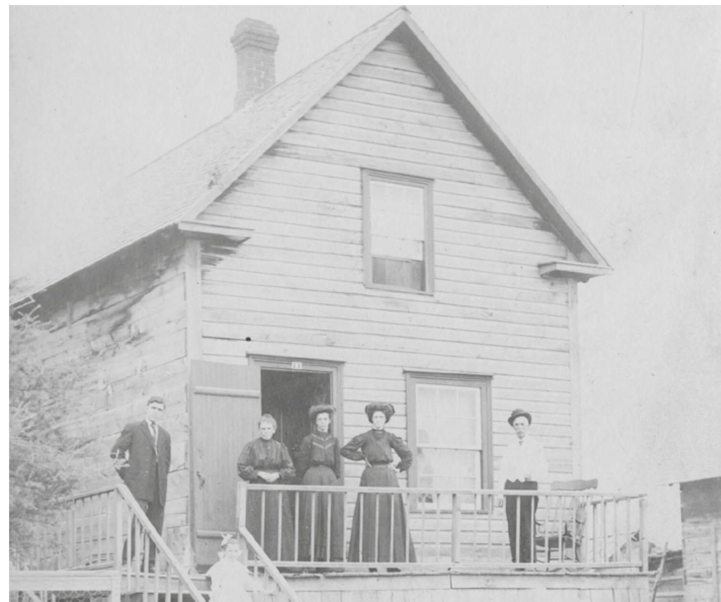
61. Maison en bois d'un étage et demi. Emplacement inconnu.
