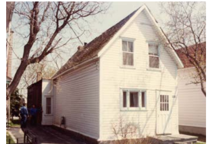
80. Toiture à pente forte. 150, rue Kent.
