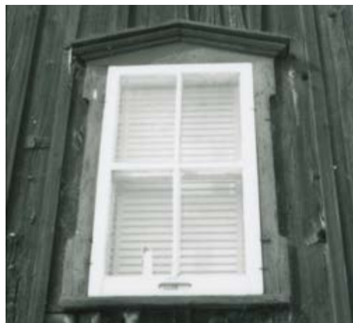
269. Chambranle ouvragé à arc en mitre. 19, rue des Braves-du-Coin.
