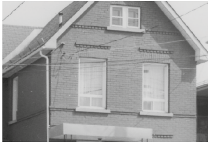
369. Frises en briques. 129, rue Wellington.
