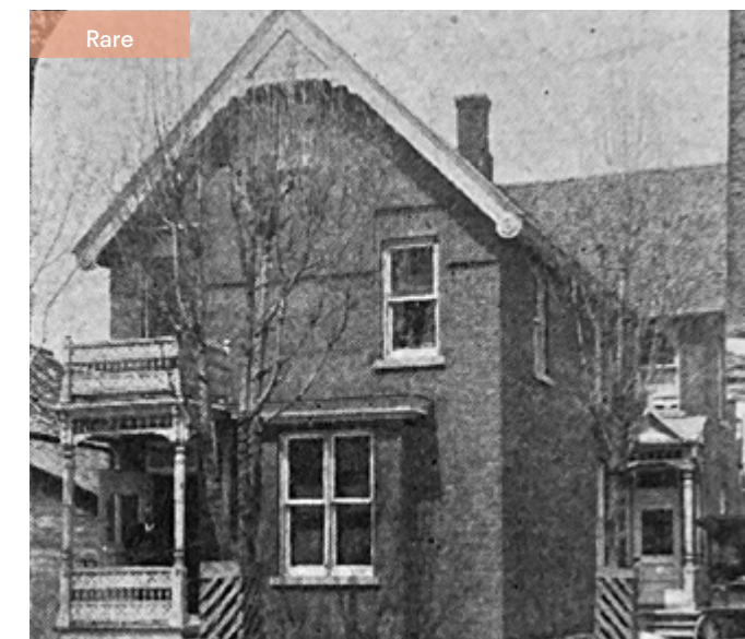
349. Plusieurs saillies sont présentes : un balcon au-dessus de la porte principale et un oriel (à droite). 69, rue Vaudreuil.
