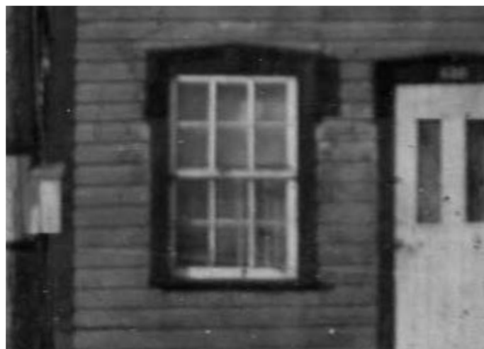
118. Fenêtre à guillotine à 12 carreaux. 128-130, rue Saint-Laurent.
