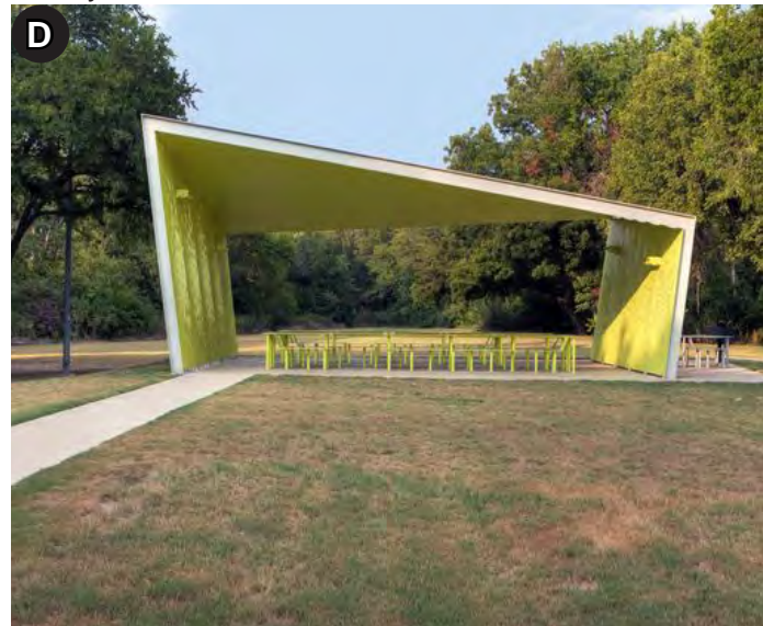
D Espace couvert pour se rassembler
