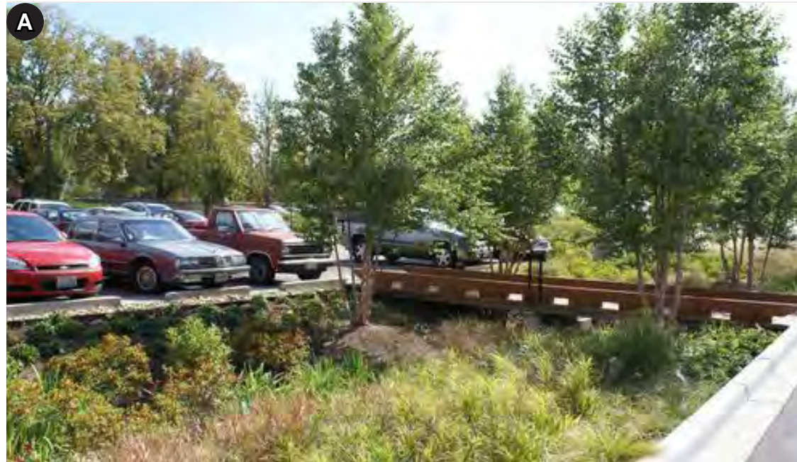
A Noue végétalisée pour la gestion des eaux
