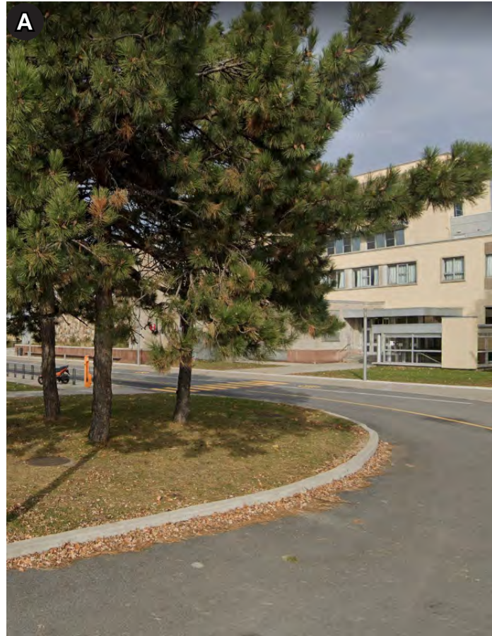
A Débarcadère avec plantation et sécurité des piétons
