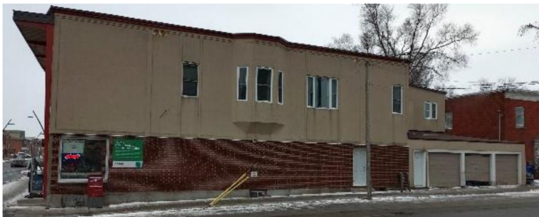
Élévation sur la rue Nicolet du bâtiment situé au 279-283, boulevard Saint-Joseph
